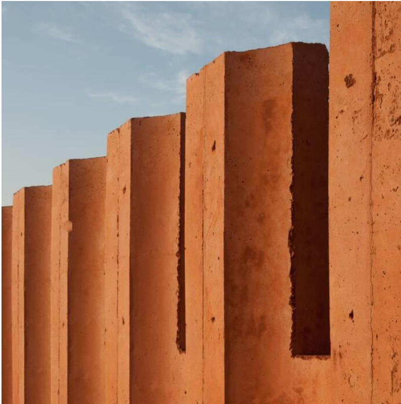
Imagem 22 – Detalhe da parede de barro durante a construção.
