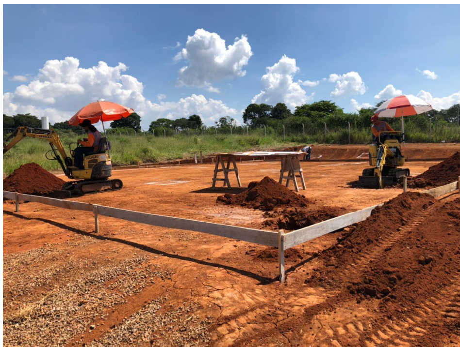
Figura 42 - Escavação das sapatas
