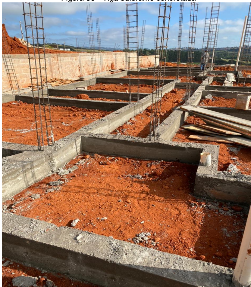
Figura 36 - Viga baldrame concretada
