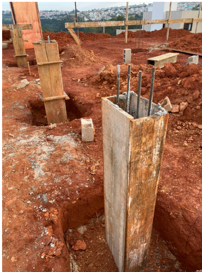
Figura 33 - Forma dos arranques de pilares
