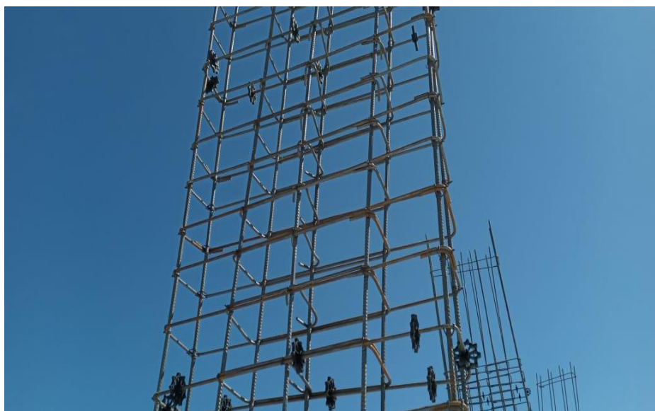
Figura 16 - Posicionamento armadura e espaçadores
