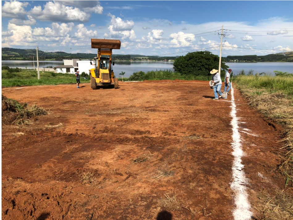
Figura 40 - Marcação do gabarito
