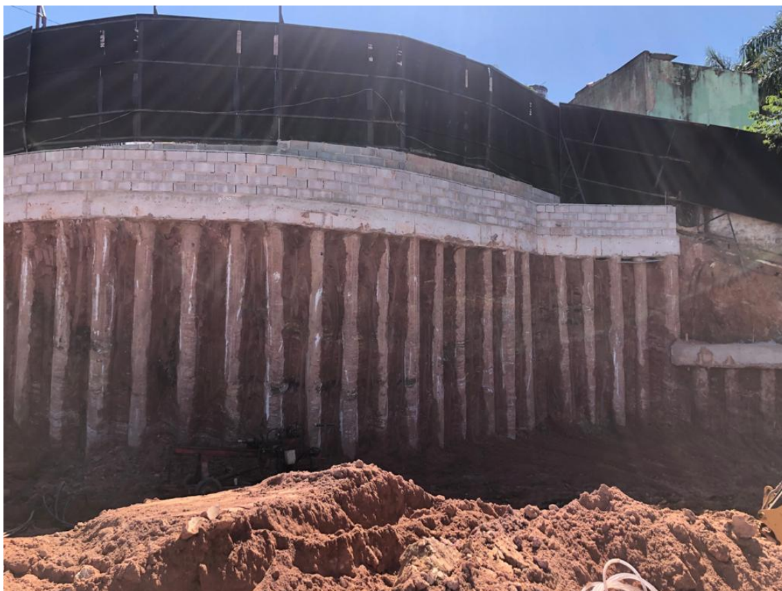
Figura 9 - Trecho da cortina de contenção
