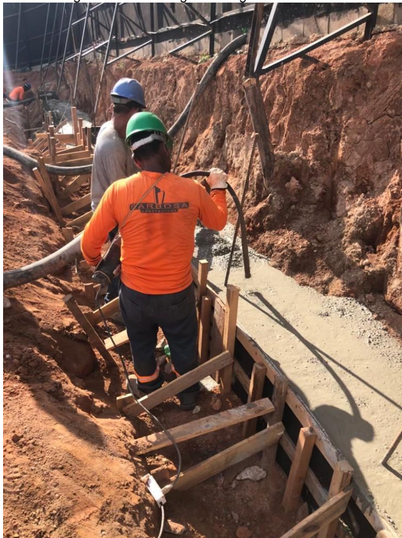
Figura 7 - Concretagem da viga de coroamento
