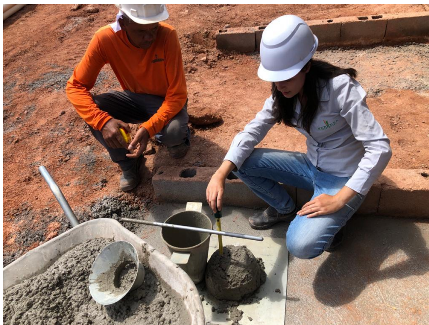
Figura 5 - Execução do Slump Test
