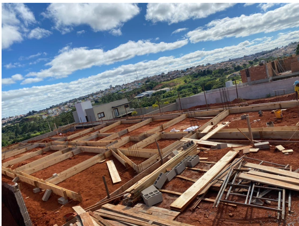
Figura 35 - Formas da viga baldrame
