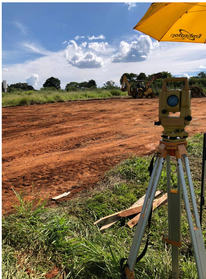
Figura 39 - Limpeza do terreno e marcação da referência
