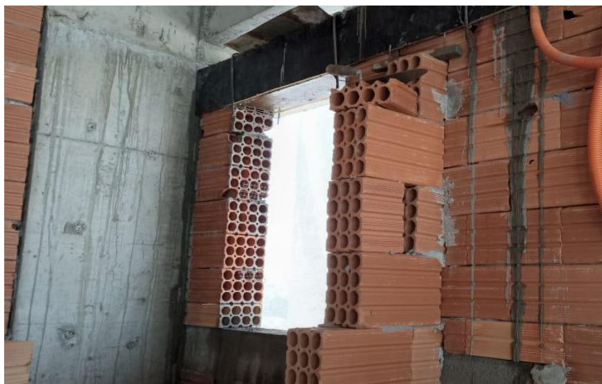
Figura 22 - Execução de verga e contraverga
