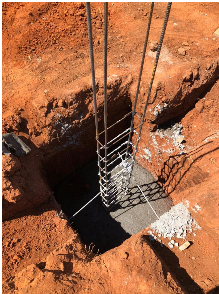
Figura 44 - Concretagem das sapatas
