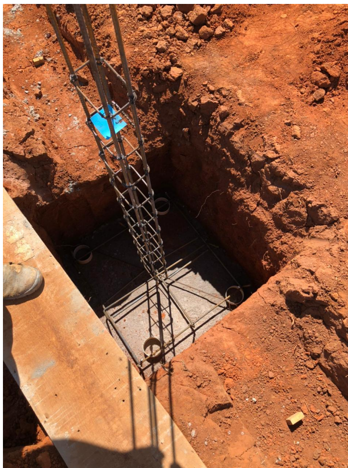
Figura 43 - Concreto magro e espaçadores
