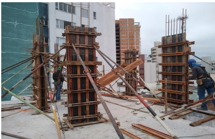
Figura 17 - Caixa de pilares prumados e travados
