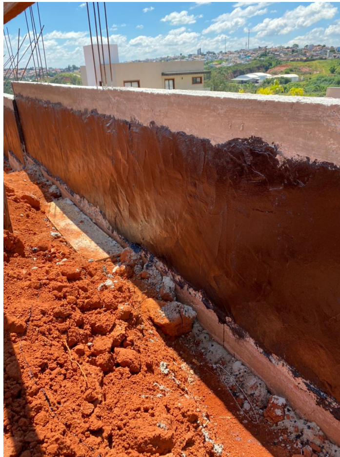
Figura 31 - Impermeabilização do muro
