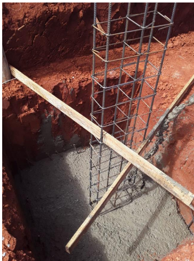
Figura 32 - Sapata isolada concretada
