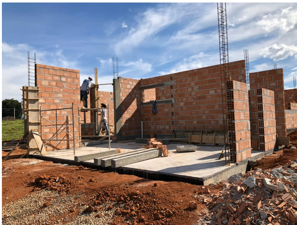
Figura 45 - Alvenaria de vedação
