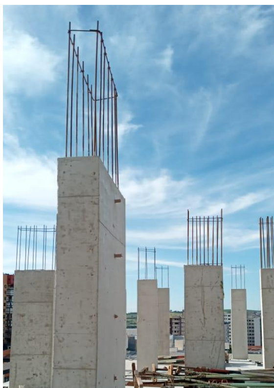
Figura 18 - Pilares concretados e desformados
