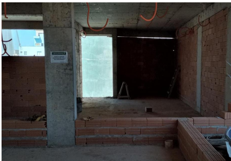
Figura 19 - Serviços primário de assentamento bloco cerâmico
