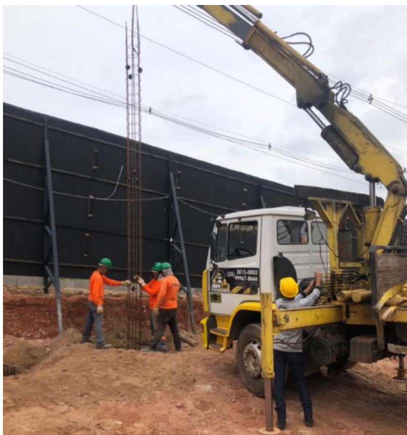
Figura 4 - Colocação da armadura no furo
