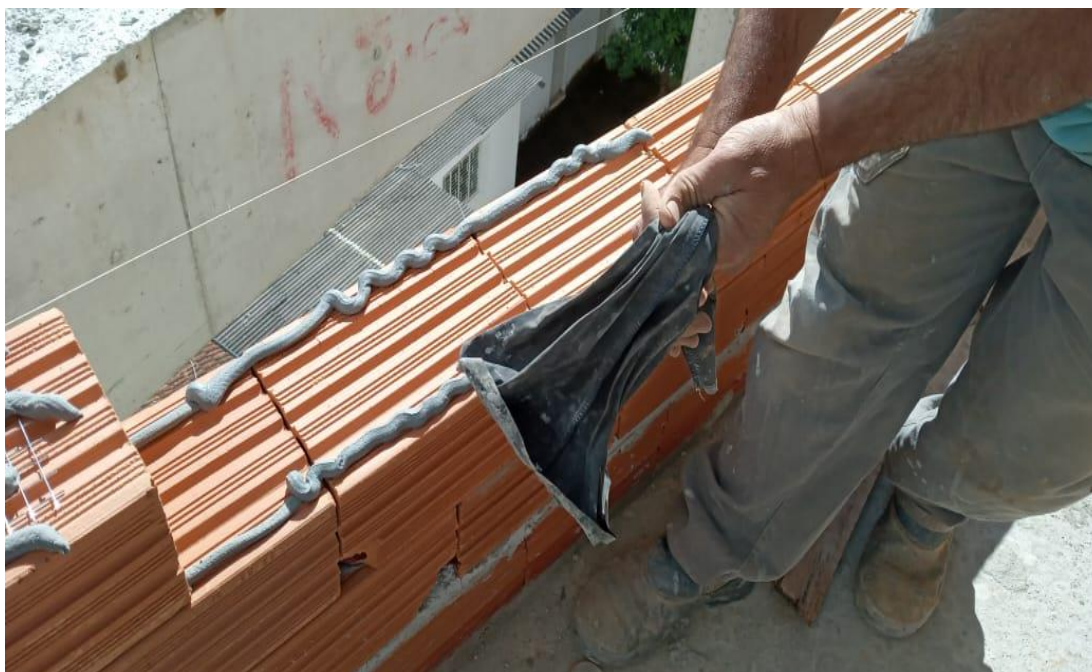
Figura 20 - Aplicação de argamassa de assentamento
