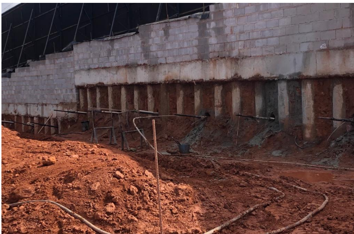
Figura 11 - Posição das monobarras e injeção de calda de cimento
