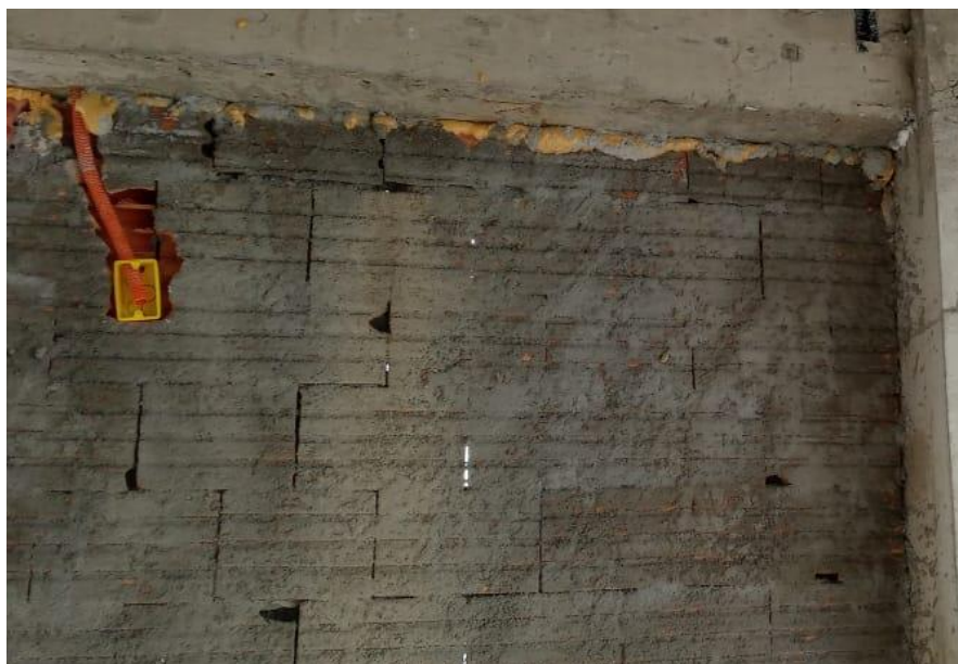
Figura 23 - Alvenaria assentada e encunhada
