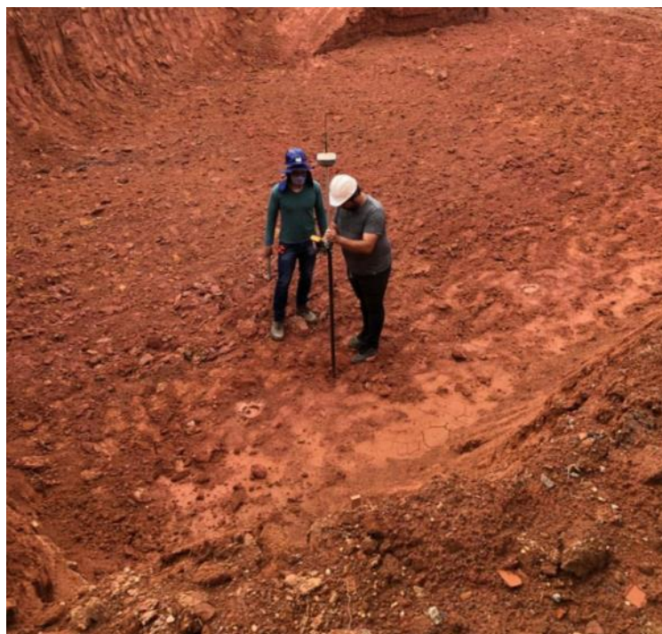
Figura 2 - Locação das estacas
