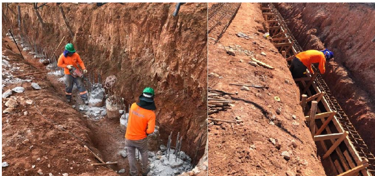
Figura 6 - Arrasamento de estacas/ execução da forma da viga
