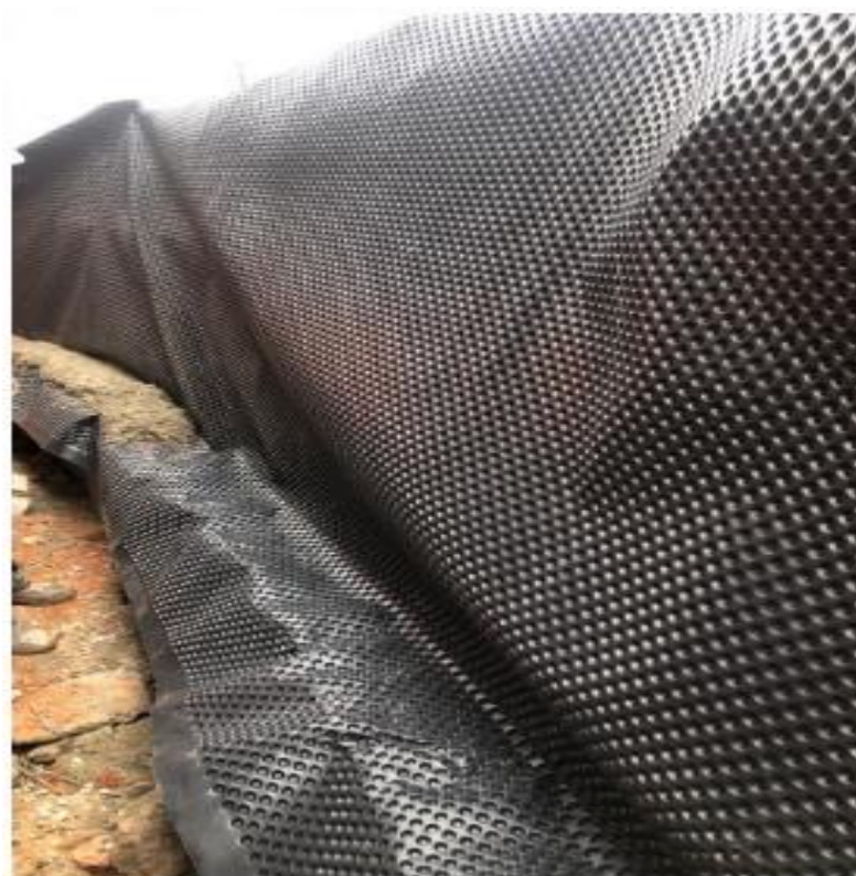
Figura 8 - Aplicação da Isostud Cortina Drenante
