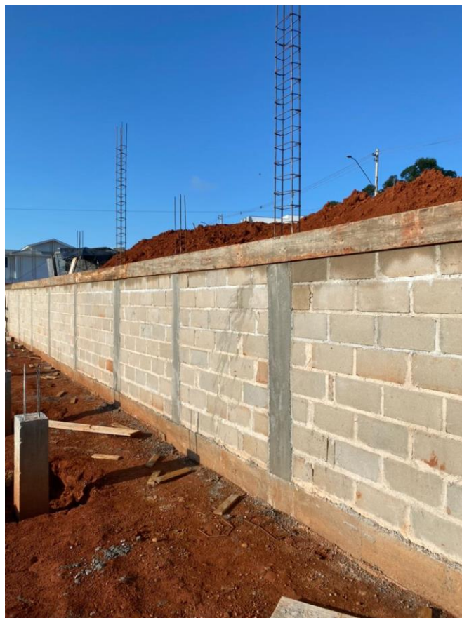
Figura 30 - Alvenaria estrutural do muro de arrimo
