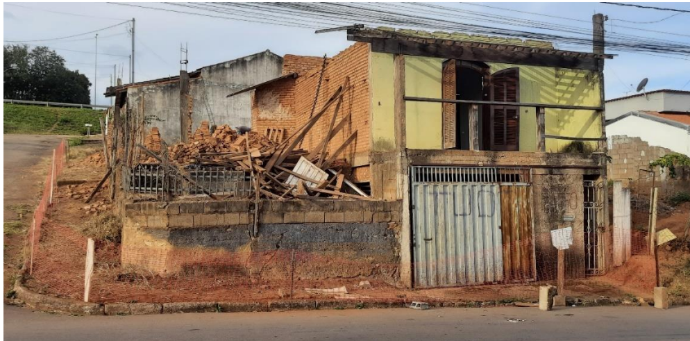
Figura 34 - Início da demolição.
