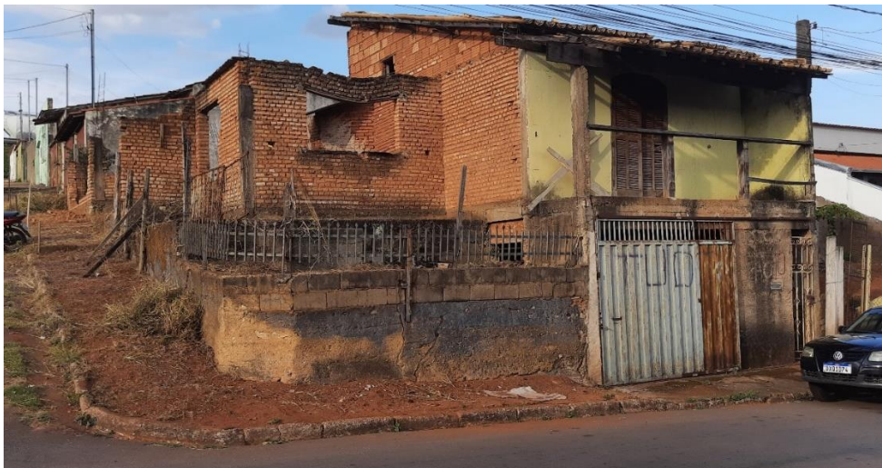
Figura 33 - Edificação antes da demolição.
