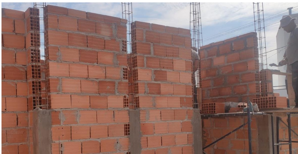
Figura 19 - Alvenaria em altura de respaldo
