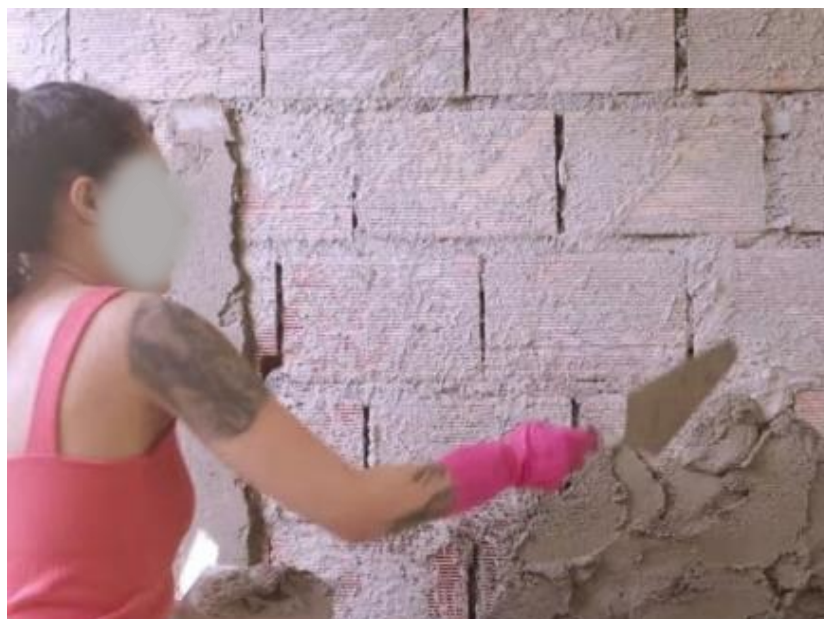
Figura 4 - Aplicação da argamassa
