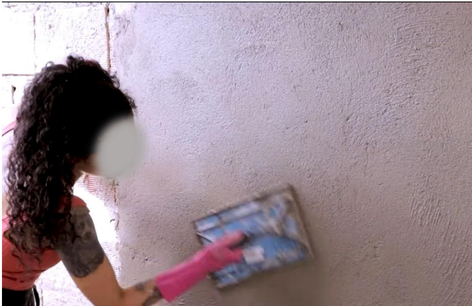
Figura 6 - Acabamento no reboco
