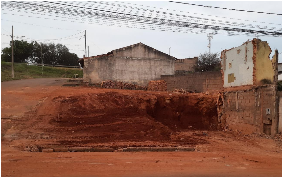
Figura 38 - Lote limpo e preparado para as etapas de construção.
