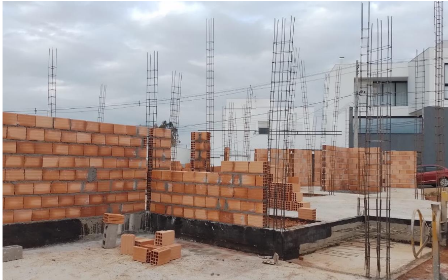
Figura 18 - Alvenaria em meia parede
