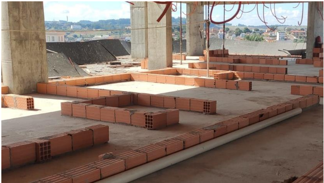
Figura 7 - Início da marcação das paredes.
