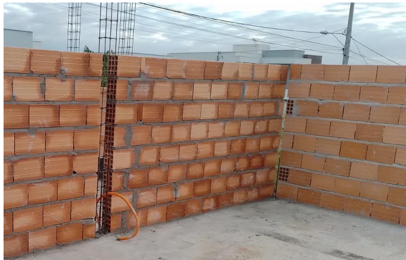
Figura 8 – Assentamento dos tijolos
