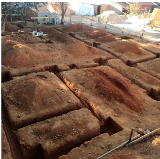
Figura 64 - Perfuração da fundação
