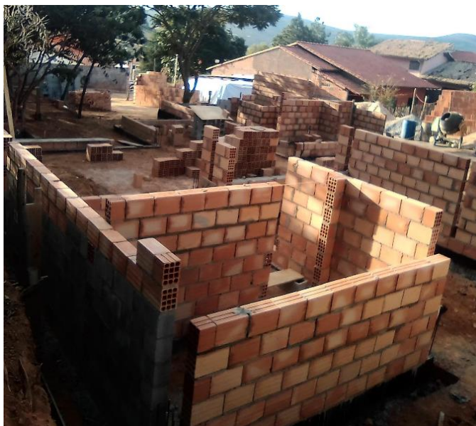
Figura 67 - Alvenaria de vedação
