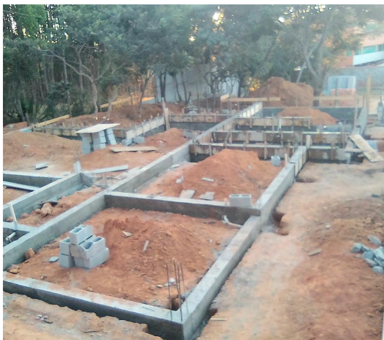
Figura 65 - Forma viga baldrame
