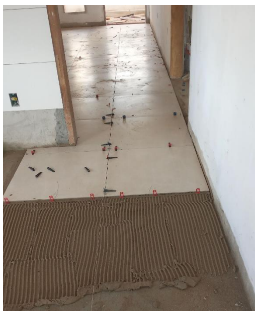
Figura 72 – Aplicação da argamassa colante
