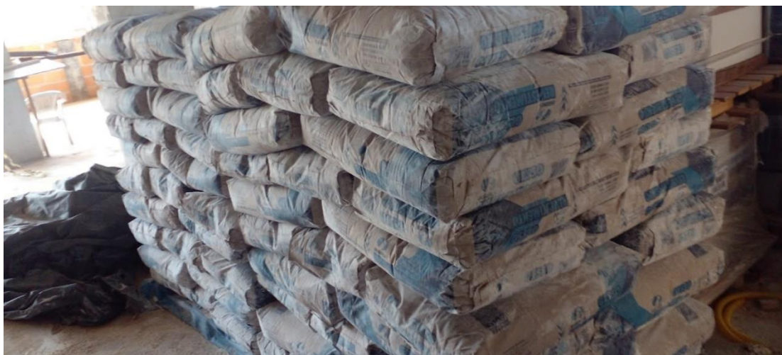
Figura 25 - Armazenamento de gesso
