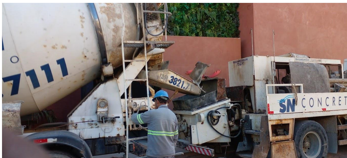
Figura 11 - Lançamento do concreto
