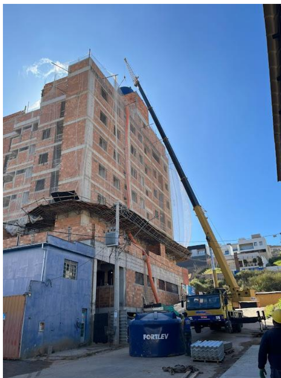
Figura 4 - Residencial Firenze (andamento da obra).
