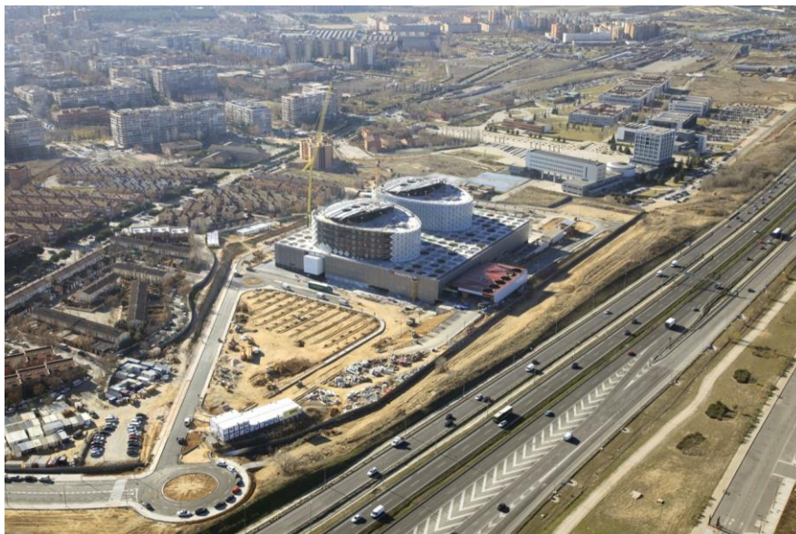
Imagem 3: Rodovia A-5, acesso principal a edificação.
