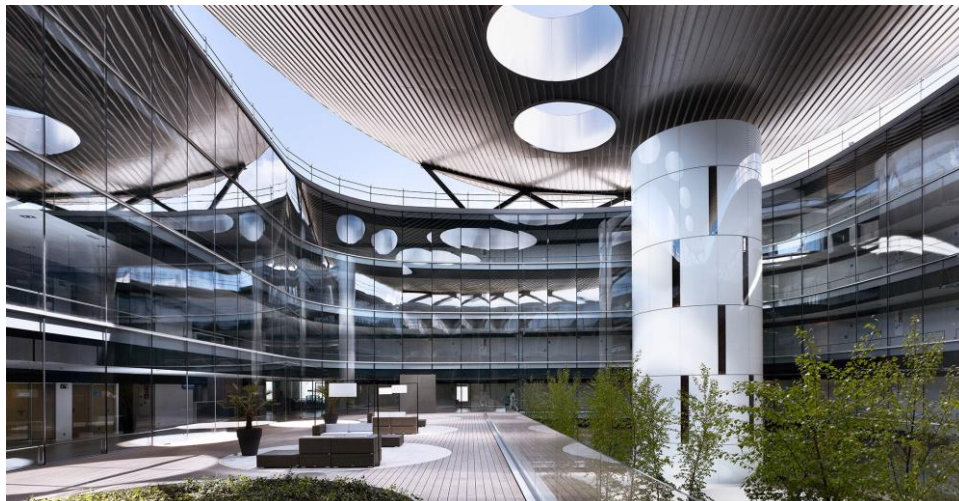
Imagem 18: Iluminação zenital, blocos superiores.
