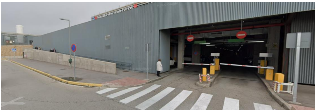
Imagem 7: Rampa externa pedonal.
