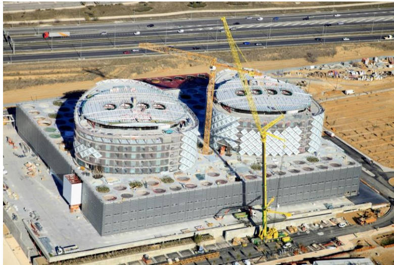
Imagem 15: Instalação dos brises.
