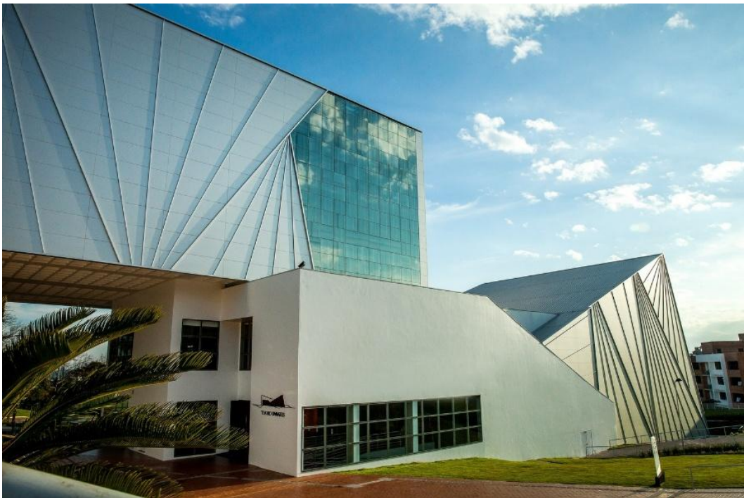
Imagem 2 - Cobertura Teatro Centro Cultural Univates
