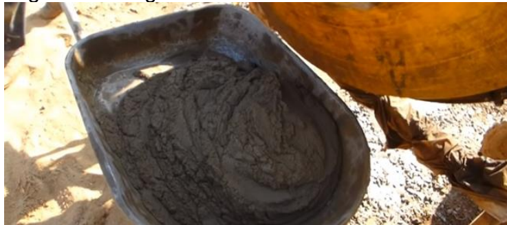
Figura 82 - Argamassa de assentamento de blocos
