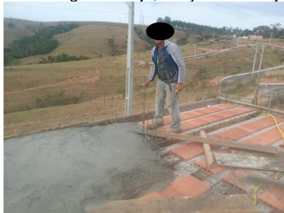
Figura 59 - Concretagem da laje, treliçada com lajota cerâmica
