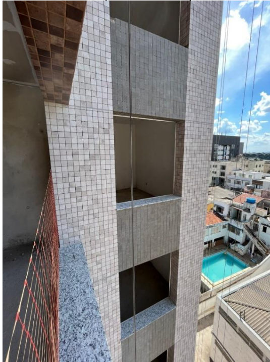
Figura 120 - Lateral do prédio com pastilhas assentadas
