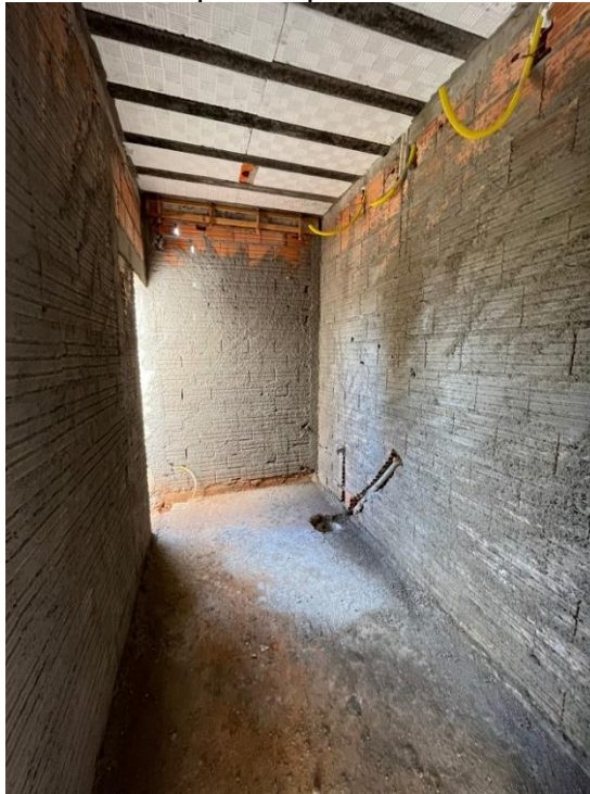
Figura 111 - Chapisco aplicado em um corredor
