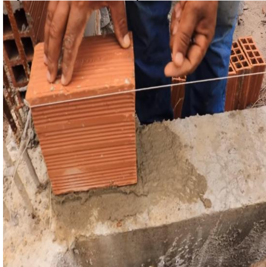
Figura 143 - Tijolo de canto da primeira fiada sendo assentado
