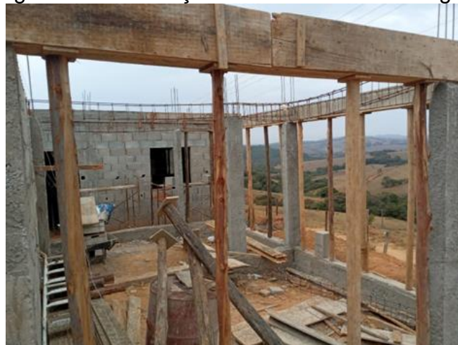
Figura 62 - Colocação das armaduras das vigas
