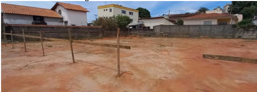
Figura 15 - Gabarito na obra
