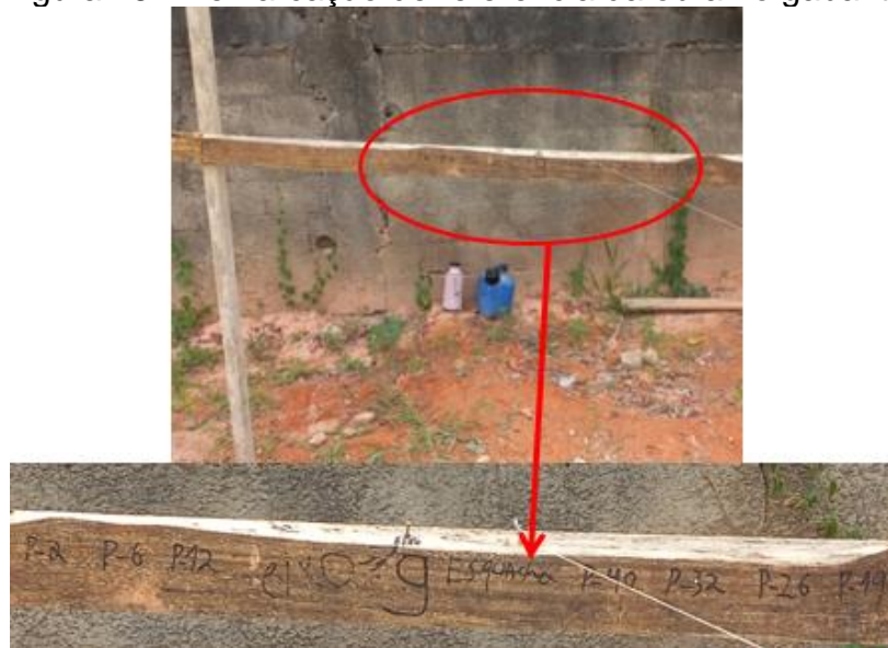
Figura 16 - Demarcação de referência da obra no gabarito
