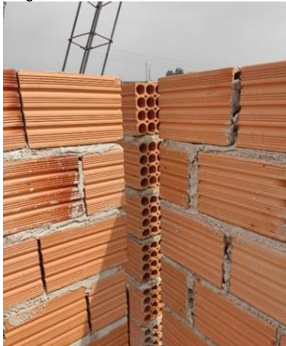
Figura 47 - Assentamento da alvenaria
