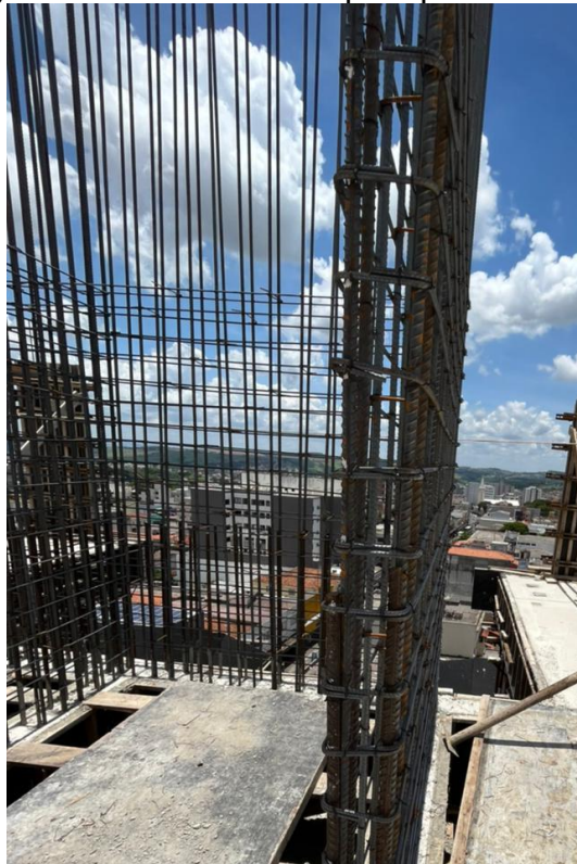
Figura 90 - Armadura do pilar parede vista 1
