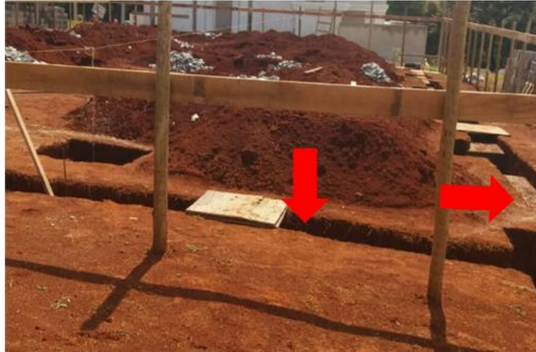
Figura 42 - Escavação das vigas baldrames
