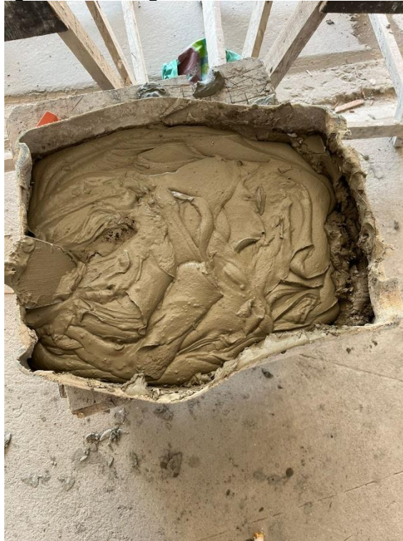
Figura 114 - Argamassa de assentamento
