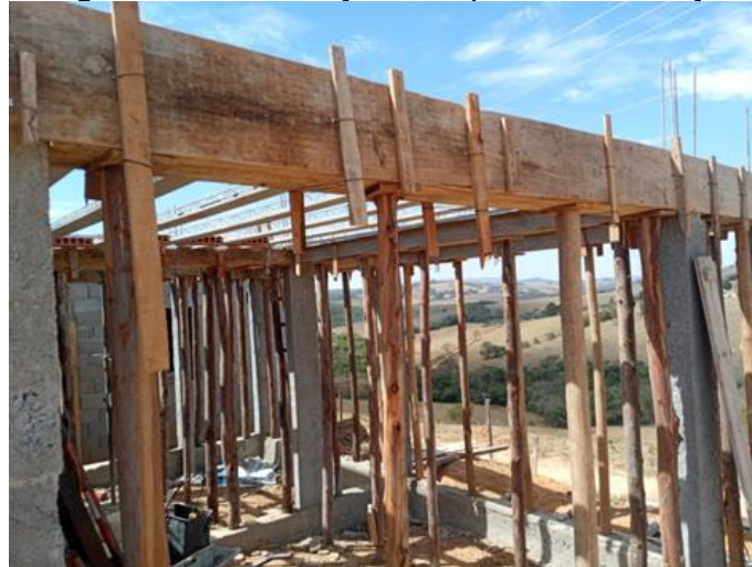
Figura 63 - Colocação dos palitos de treliça
