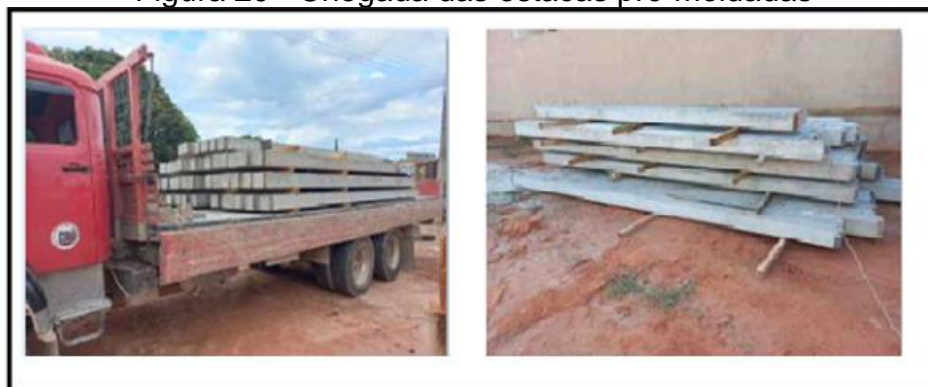
Figura 20 - Chegada das estacas pré-moldadas
