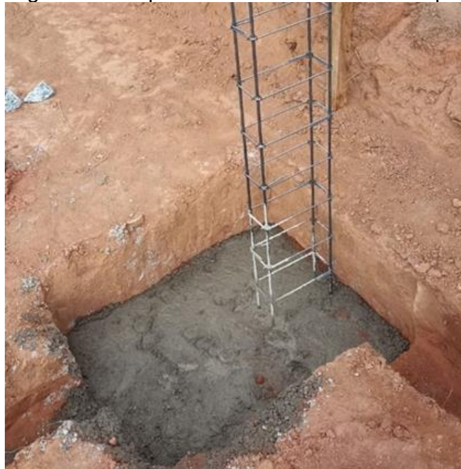
Figura 79 - Sapata com armadura de arranque
