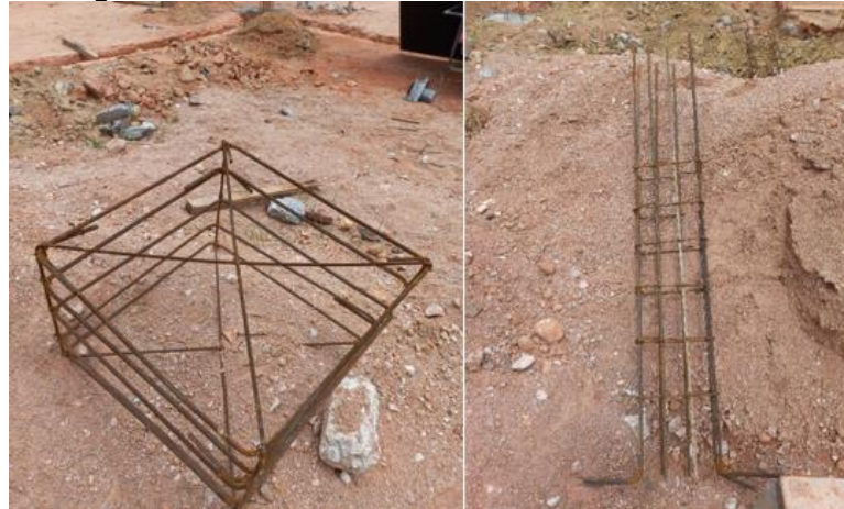
Figura 31 - Armaduras do bloco de coroamento
