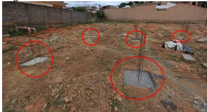
Figura 35 - Blocos de coroamento concretados
