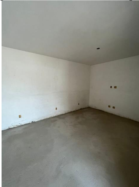
Figura 108 - Comodo revestido com gesso
