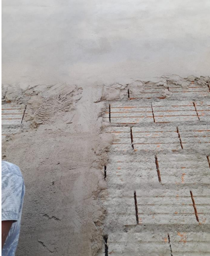
Figura 151 - Execução de reboco com argamassa estabilizada
