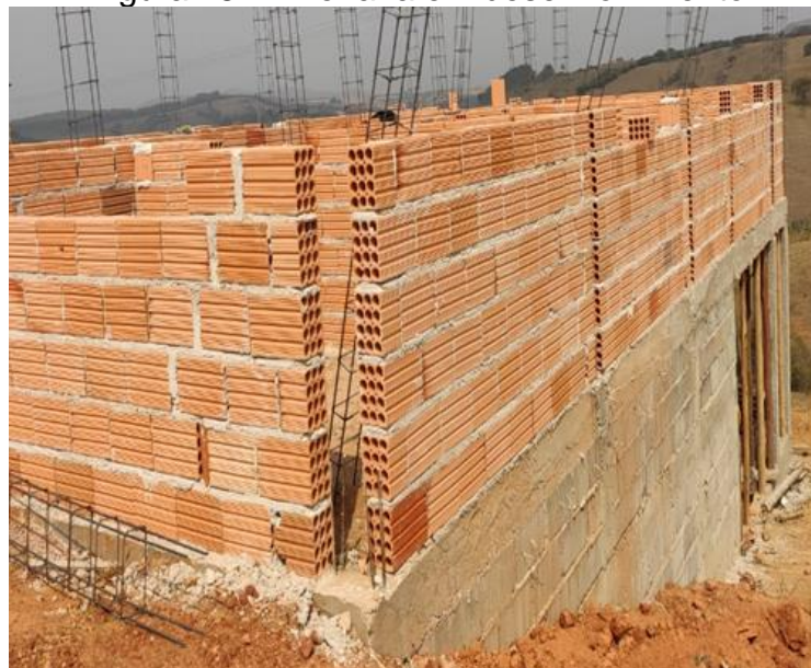
Figura 48 - Alvenaria em desenvolvimento
