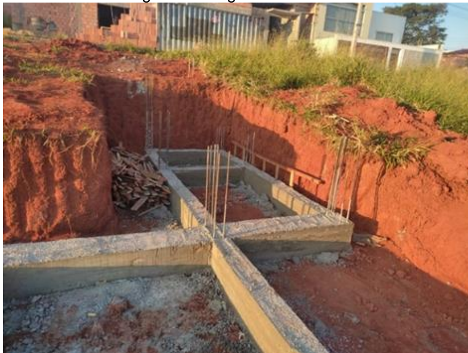
Figura 44 - Vigas concretadas
