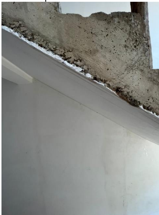
Figura 107 - Gesso aplicado na escada de concreto armado
