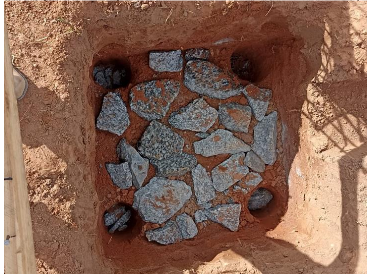
Figura 77 - Sapatas compactadas com matacões e brocas perfuradas
