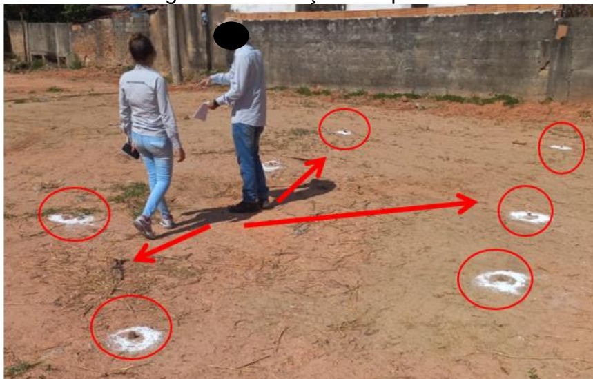
Figura 17 - Locação dos pilares
