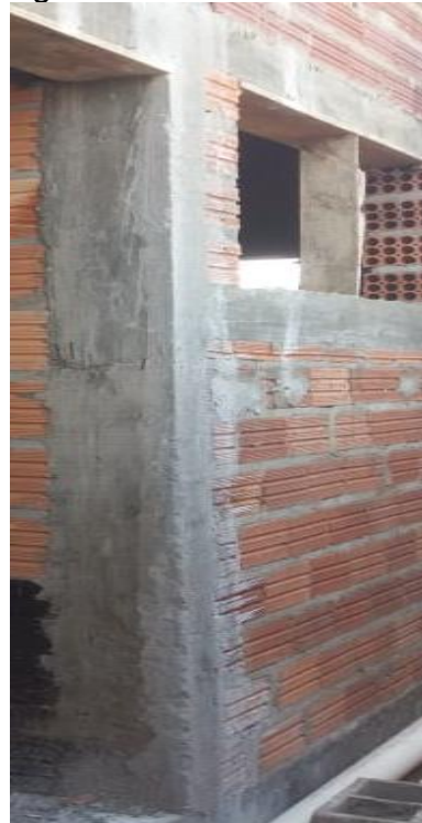
Figura 52 - Pilar concretado
