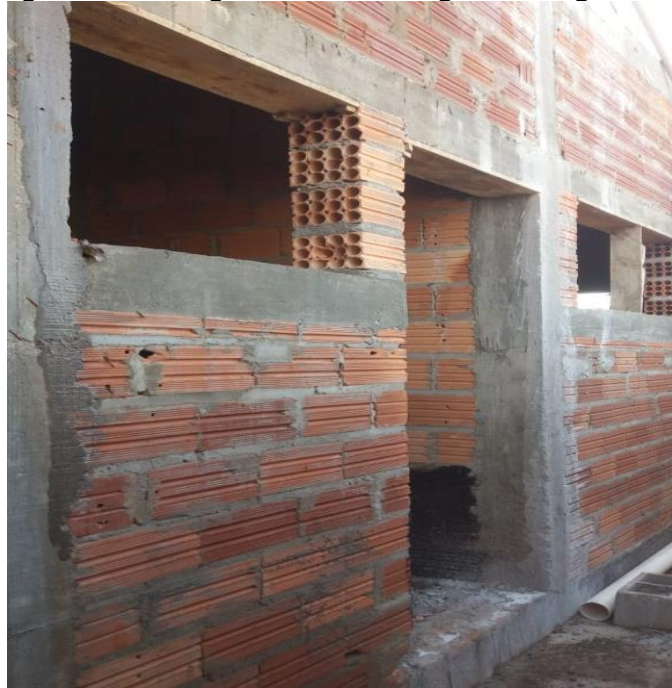
Figura 50 - Vergas e contra vergas em viga única
