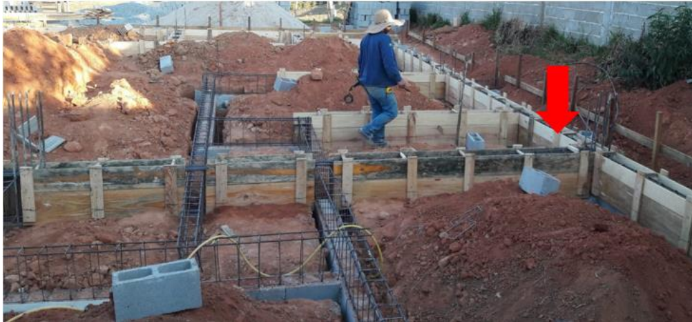
Figura 43 - Colocação das amaduras e confecção das formas
