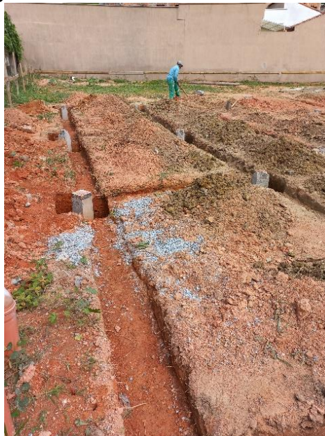
Figura 26 - Abertura das valas e blocos
