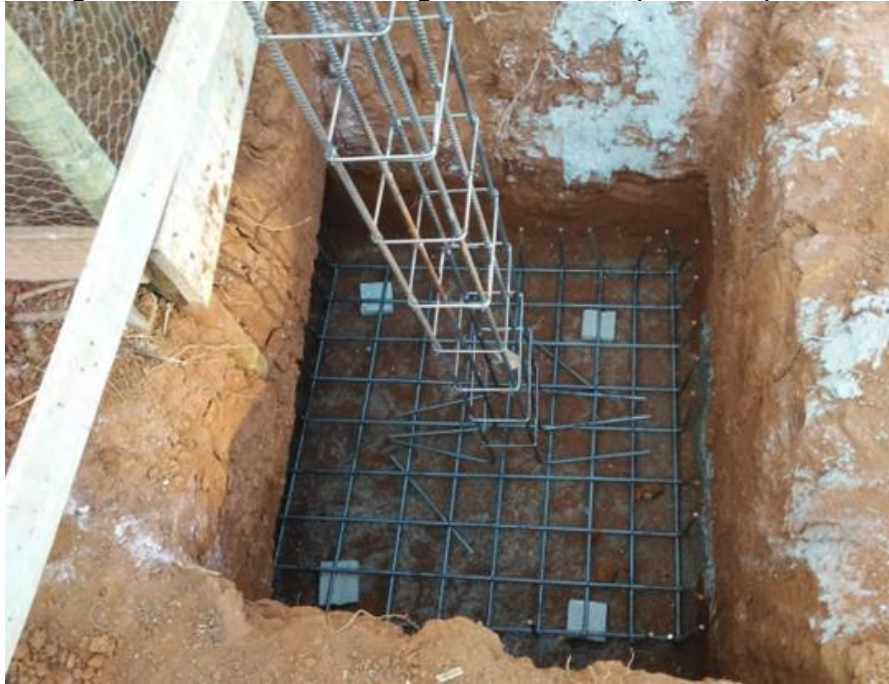
Figura 39 - Início concretagem dos Arranques dos pilares
