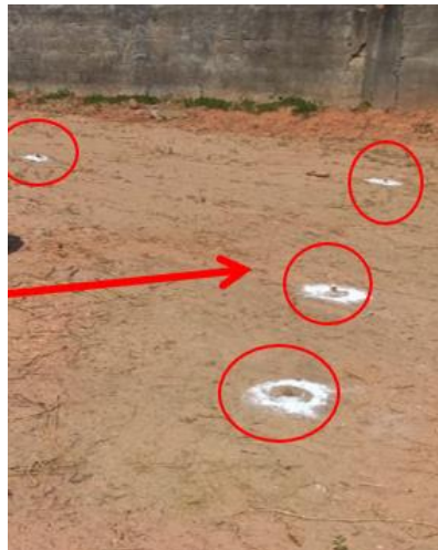
Figura 14 - Estacas de madeira cravadas
