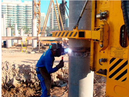
Figura 24 - Soldagem de emenda entre estacas pré-moldadas de concreto
