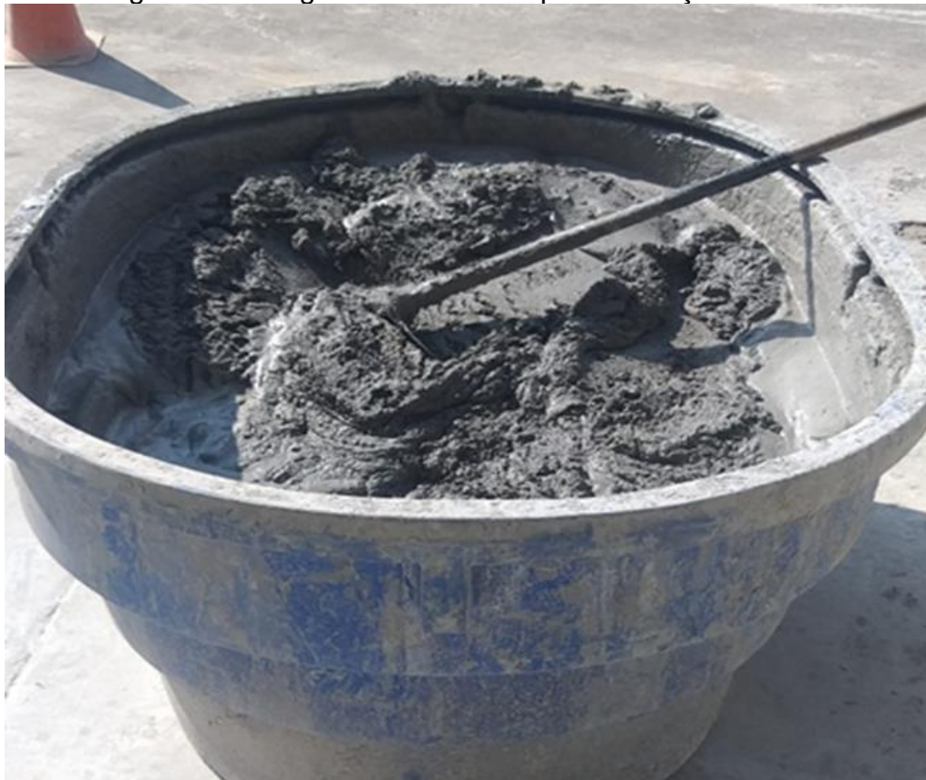
Figura 150 - Argamassa utilizada para emboço e reboco
