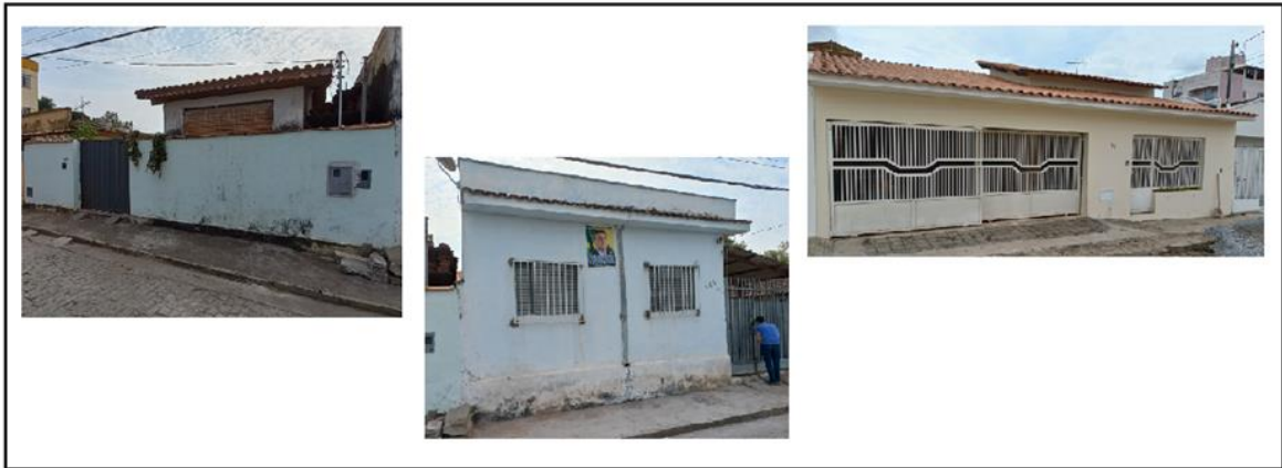
Figura 3 - Fachadas de residências vistoriadas
