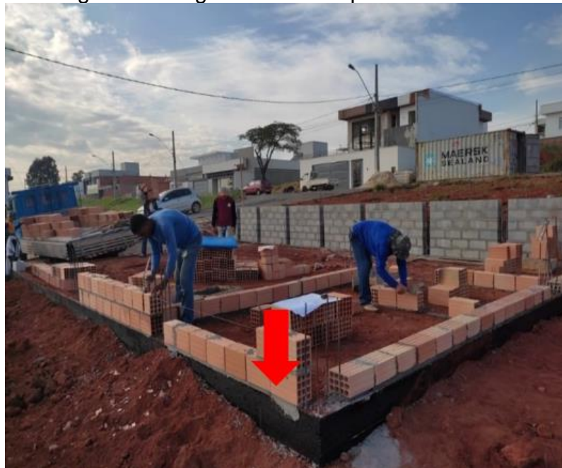
Figura 45 - Viga baldrame impermeabilizadas
