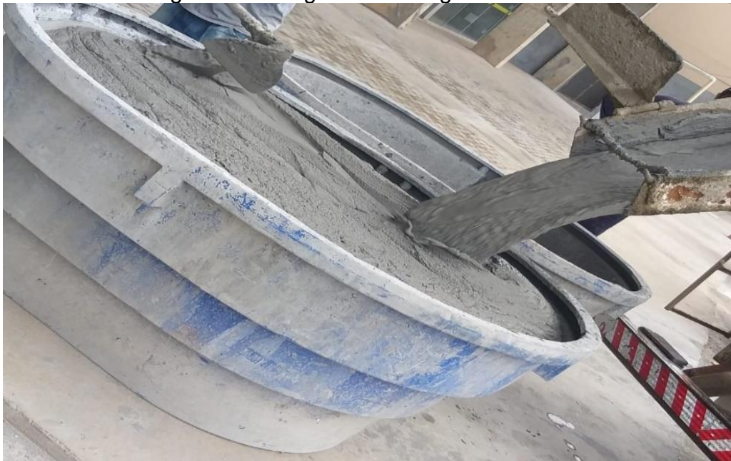
Figura 138 - Argamassa chegando na obra
