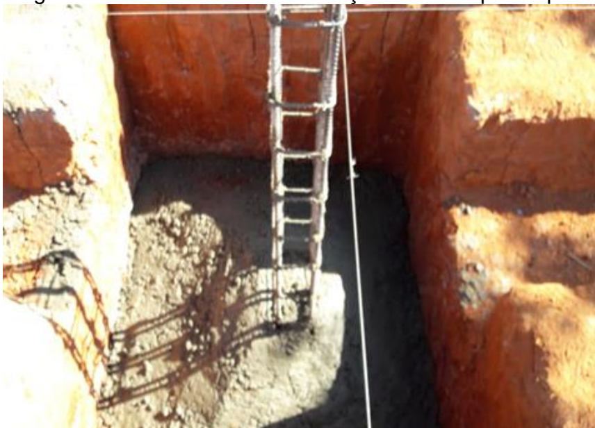
Figura 40 - Alinhamento e amarração do arranque do pilar
