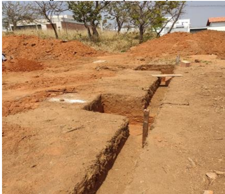
Figura 38 - Preparação das sapatas
