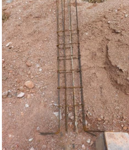
Figura 32 - Armadura do arranque
