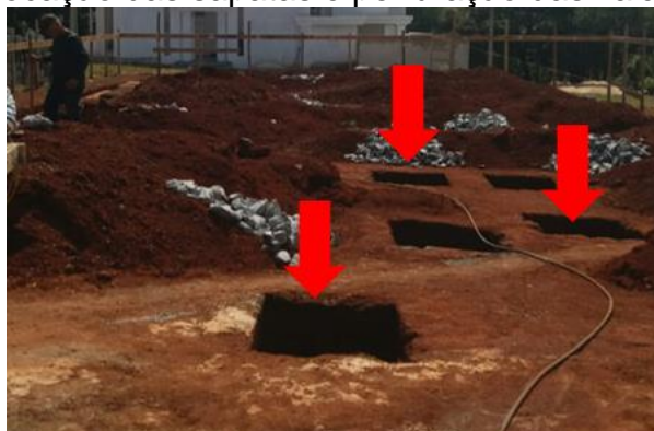
Figura 37 - Alocação das sapatas e perfuração das valas de fundação
