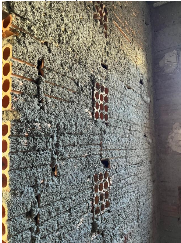
Figura 109 - Chapisco aplicado na alvenaria vista lateral
