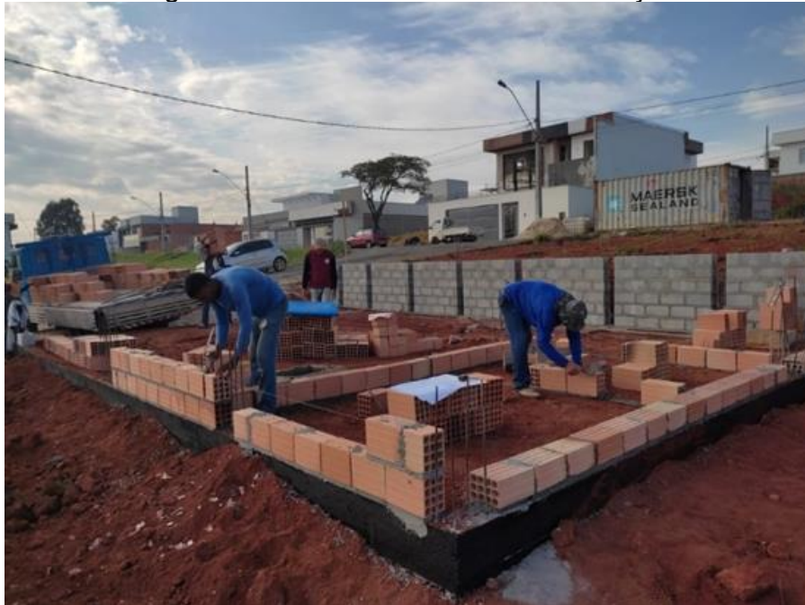
Figura 46 - Início da alvenaria de vedação
