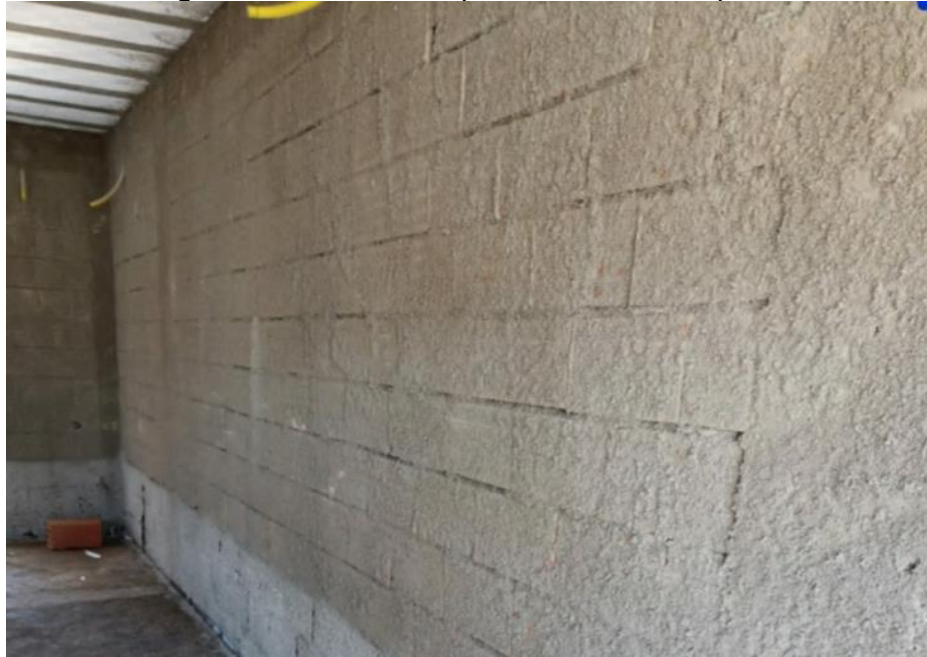
Figura 149 - Parede após receber o chapisco
