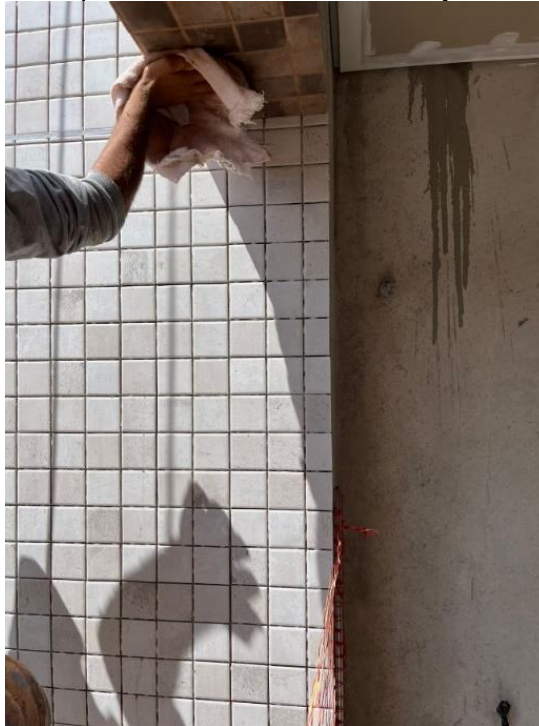
Figura 123 - Limpeza e acabamento do rejunte das pastilhas
