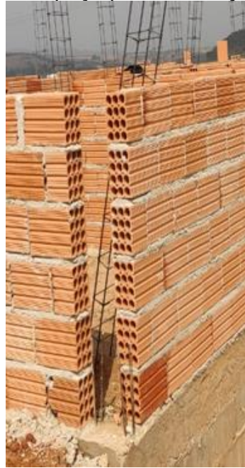
Figura 51 - Espaço para colocação do pilar
