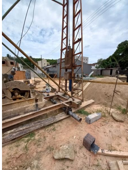
Figura 22 - Equipamento utilizado para cravação das estacas
