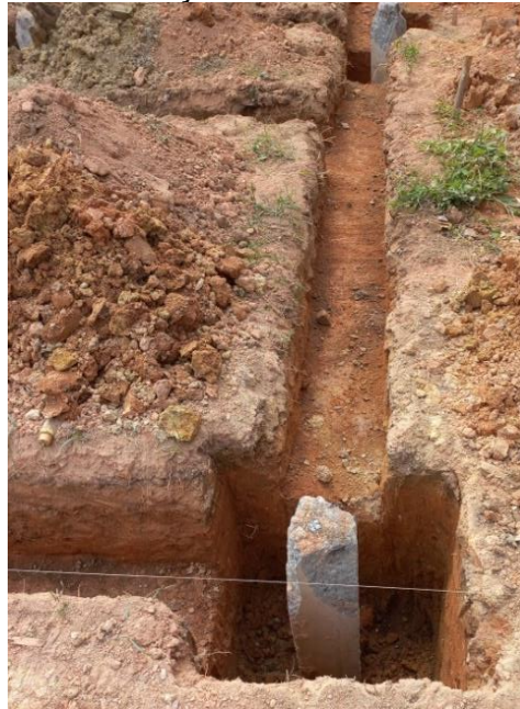
Figura 28 - Escavação dos blocos de coroamento
