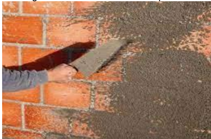
Figura 148 - Parede sendo chapiscada
