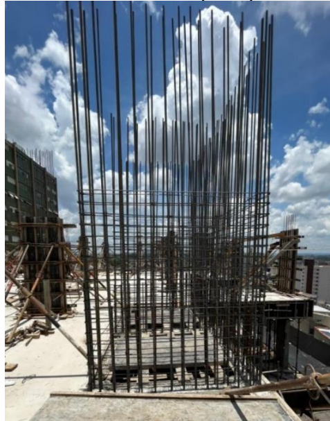
Figura 91 - Armadura de pilar parede vista 2
