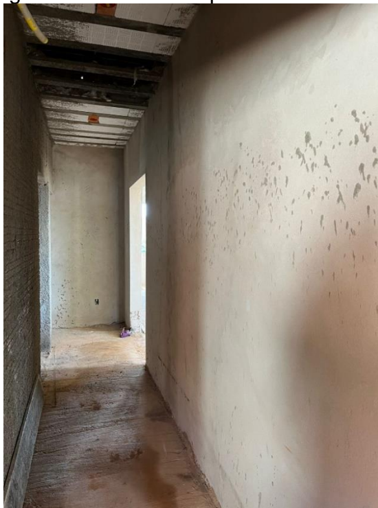
Figura 112 - Reboco aplicado no corredor
