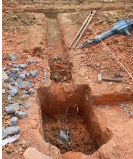
Figura 29 - Preparação do bloco de coroamento
