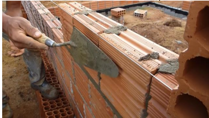
Figura 84 - Nivelamento horizontal de uma parede de alvenaria
