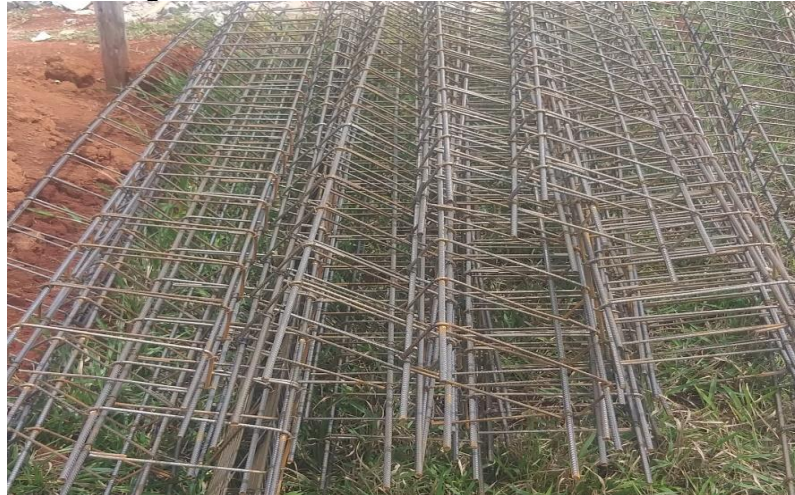
Figura 132 – Armaduras confeccionadas
