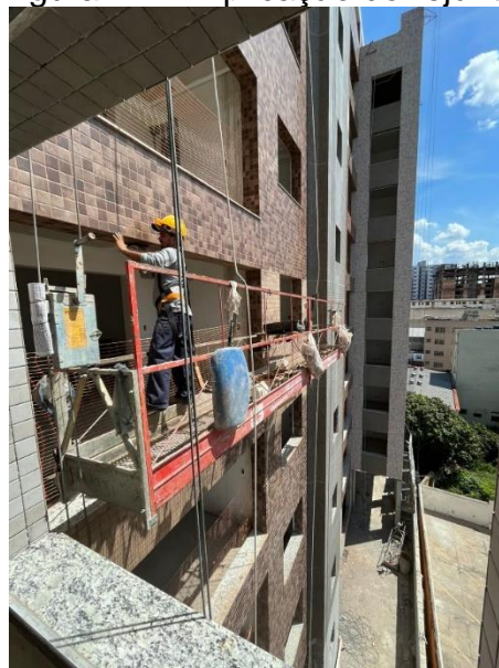
Figura 122 - Aplicação do rejunte
