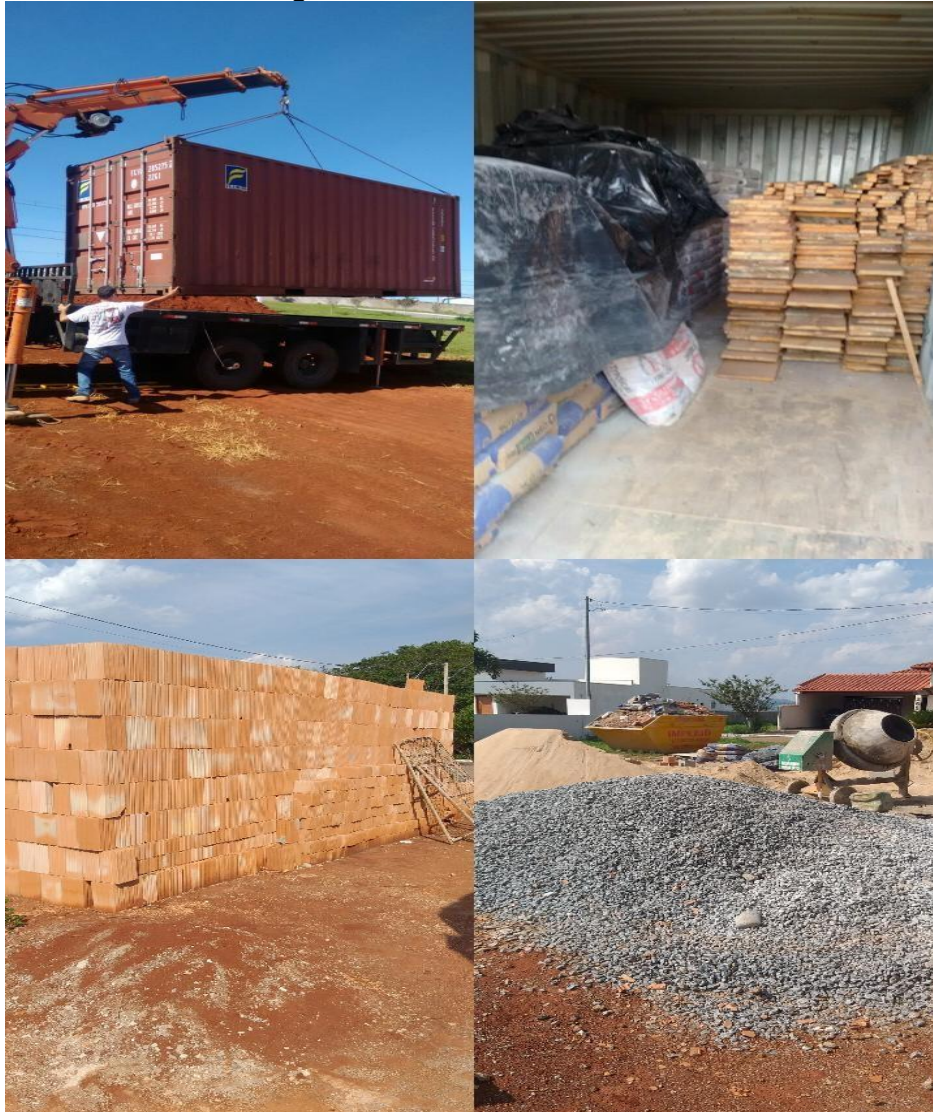
Figura 141 - Canteiro de obra
