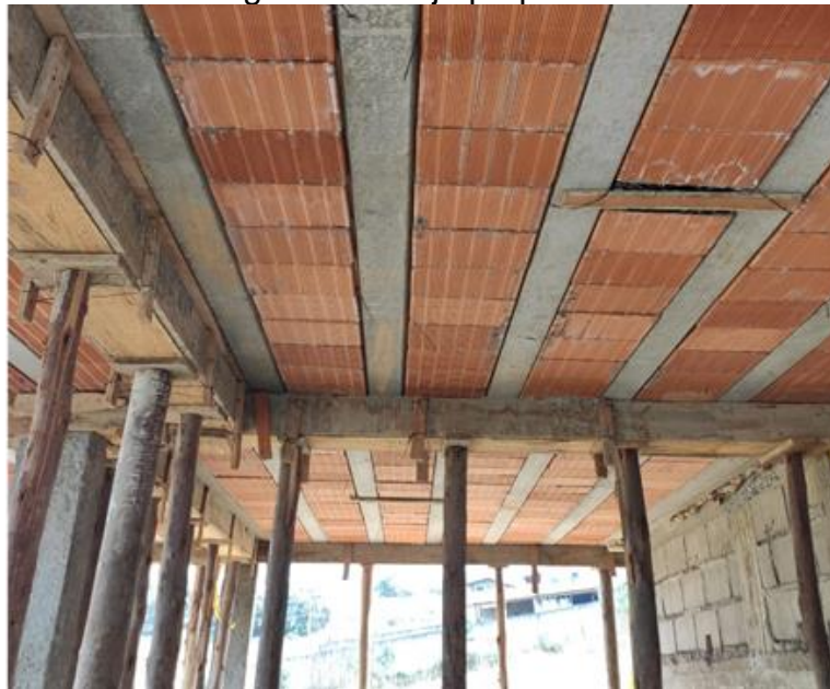
Figura 58 - Laje preparada
