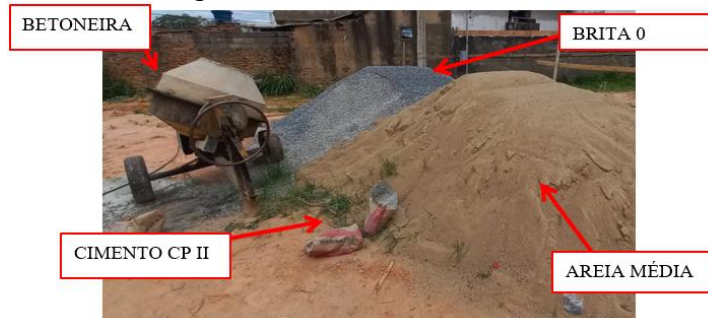
Figura 34 - Canteiro de obra
