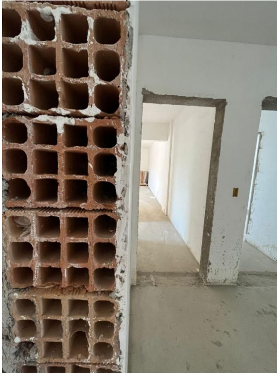
Figura 106 - Gesso aplicado no bloco cerâmico
