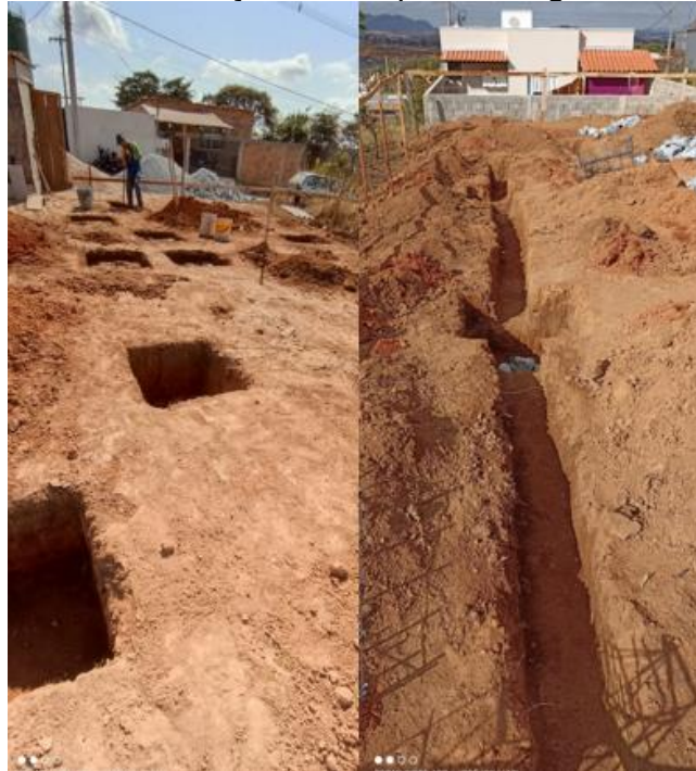
Figura 76 - Escavação das sapatas e vigas baldrames
