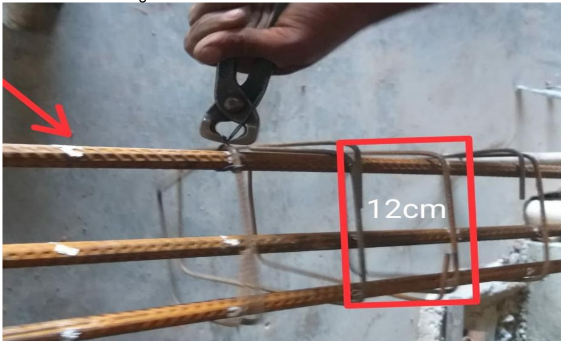
Figura 129 - Armadura sendo confeccionada
