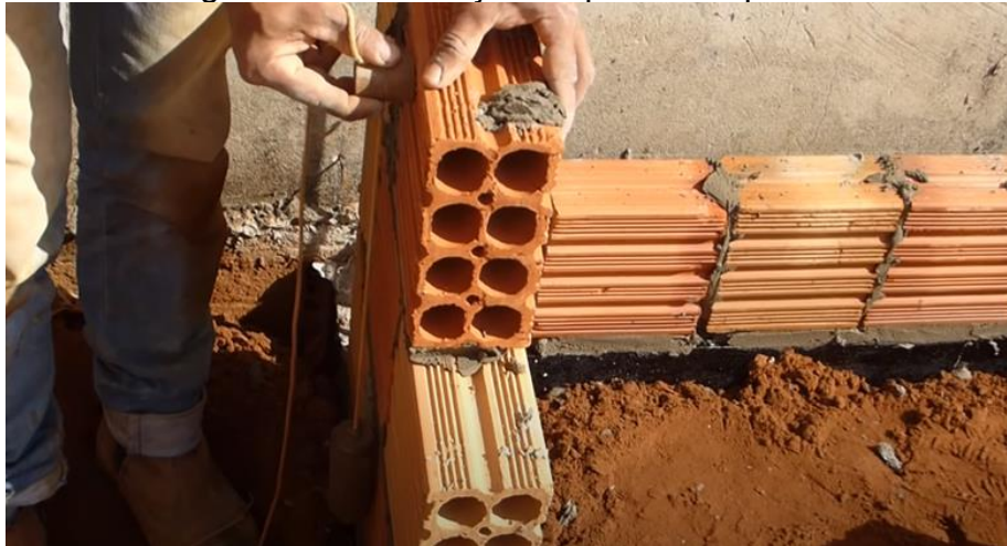
Figura 85 - Verificação do prumo da parede
