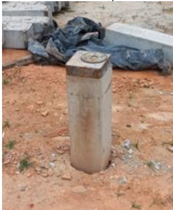
Figura 21 - Estaca cravada – P22: profundidade de 11,5 m
