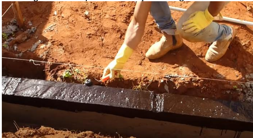
Figura 80 - Impermeabilização da viga baldrame
