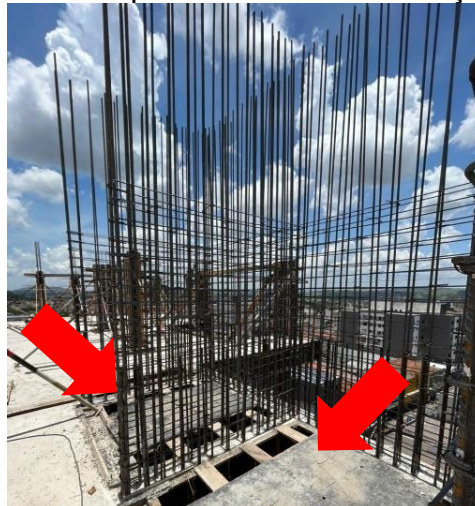
Figura 92 - Pranchas para fechamento do foço do elevador
