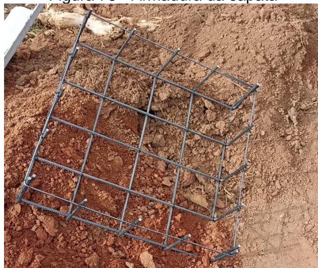
Figura 78 - Armadura da sapata
