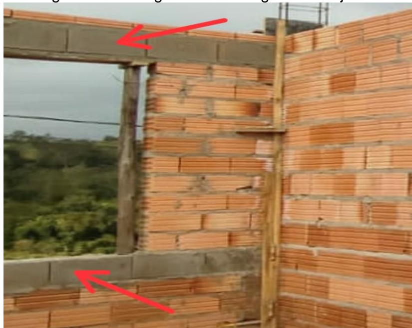
Figura 147 - Verga e contra verga de uma janela
