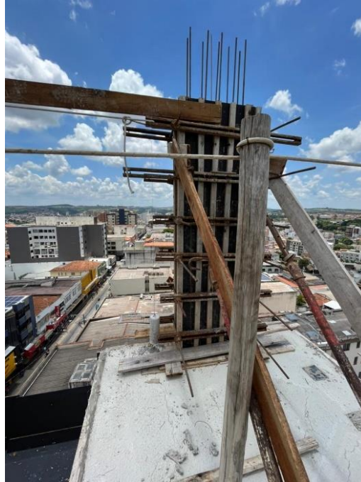
Figura 98 - Caixaria travada e prumada
