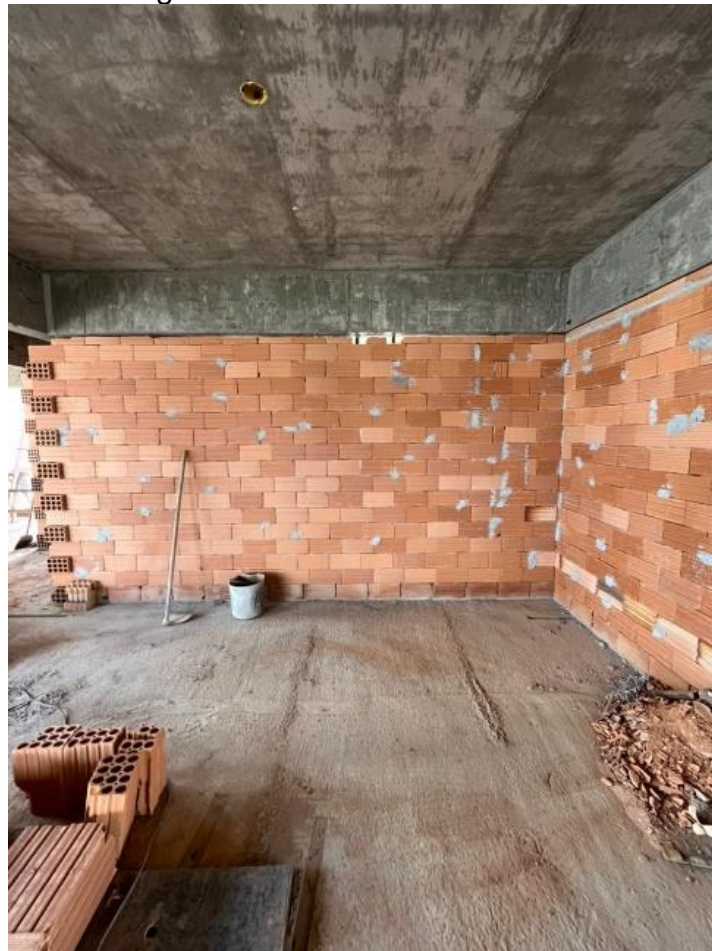
Figura 105 - Alvenaria executada
