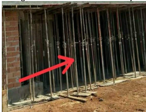
Figura 133 - Escoramento da laje
