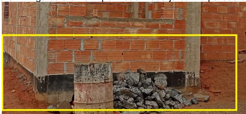
Figura 81 - Viga baldrame impermeabilizada já com a parede erguida
