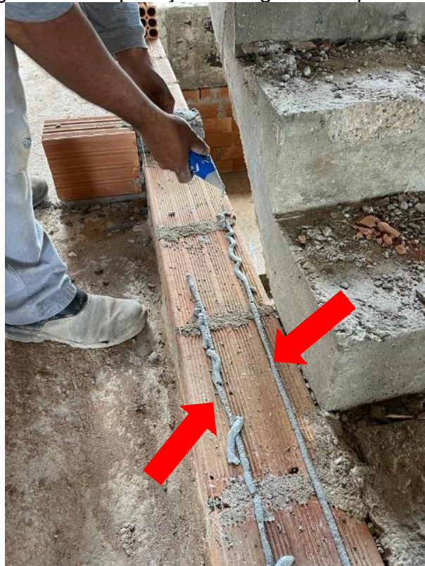
Figura 104 - Aplicação da argamassa polimérica
