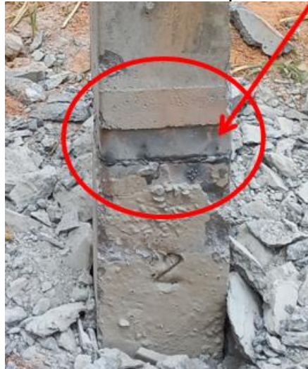
Figura 25 - União das estacas por solda elétrica
