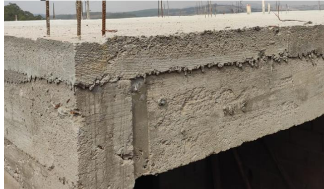
Figura 61 - Recorte do concreto curado
