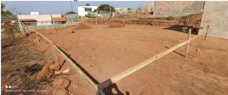
Figura 74 - Gabarito da obra
