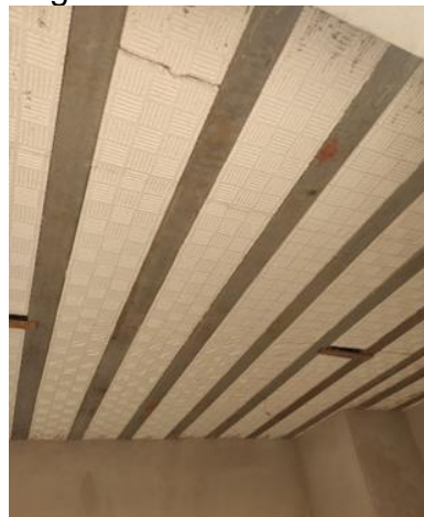
Figura 64 - EPS instalado
