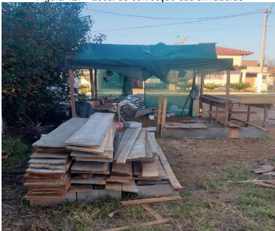
Figura 127 - Local de confecção das armaduras
