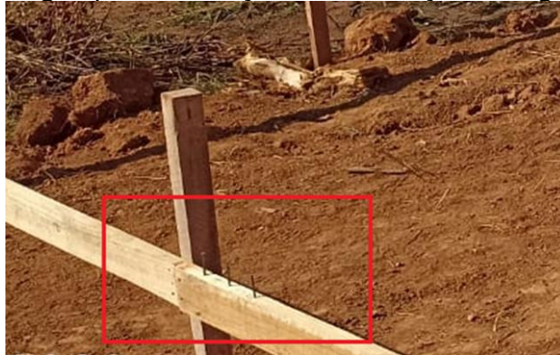
Figura 75 - Pregos para marcação das fundações e vigas baldrames
