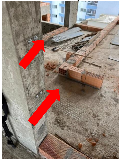
Figura 101 - Telas de fixação e travamento
