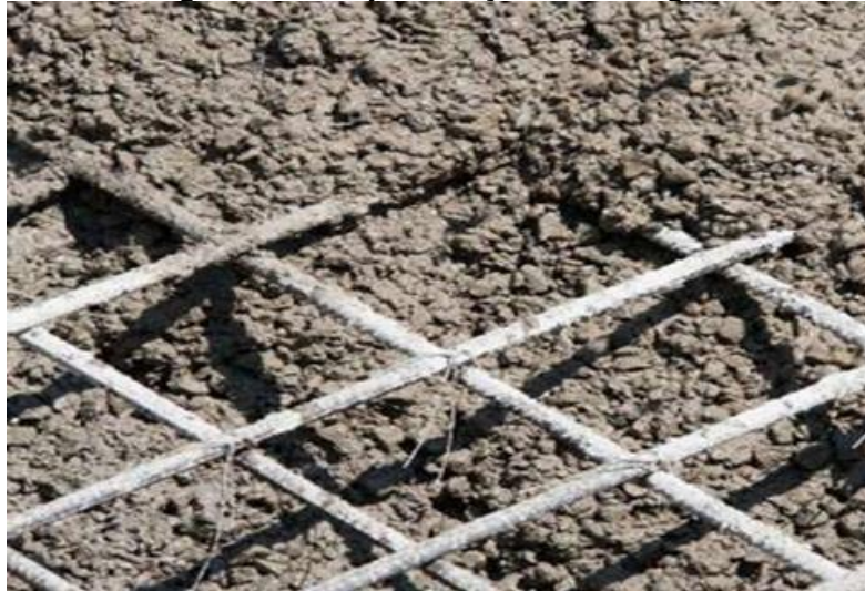
Figura 55 - Laje maciça concretagem
