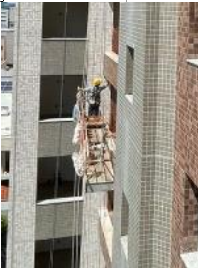
Figura 119 - Assentamento das pastilhas na fachada
