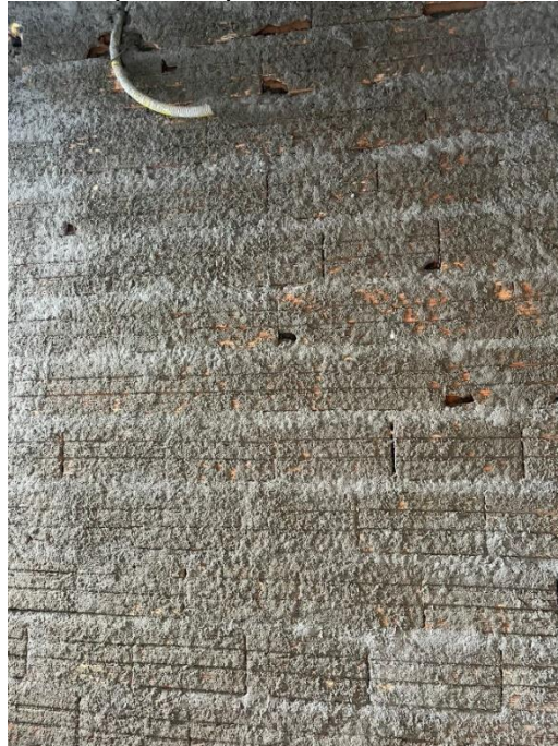
Figura 110 - Chapisco aplicado na alvenaria vista frontal
