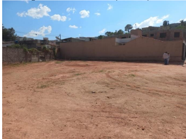
Figura 12 - Terreno após limpeza
