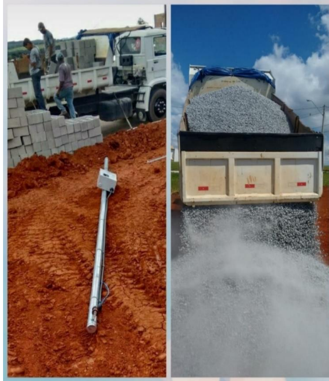
Figura 137 - Materiais sendo entregues no canteiro de obra
