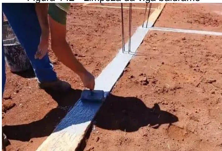
Figura 142 - Limpeza da viga baldrame
