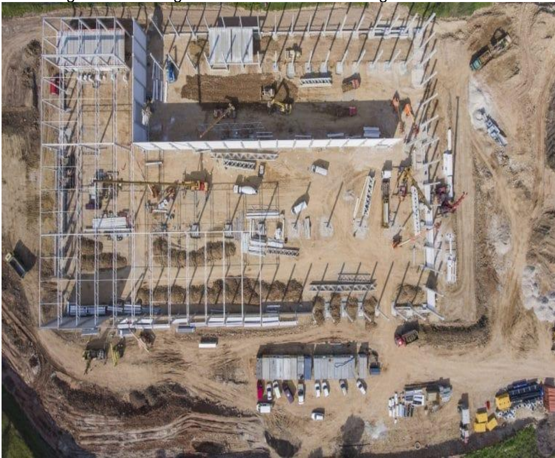
Figura 139 - Imagem de canteiro de obra de grande dimensão
