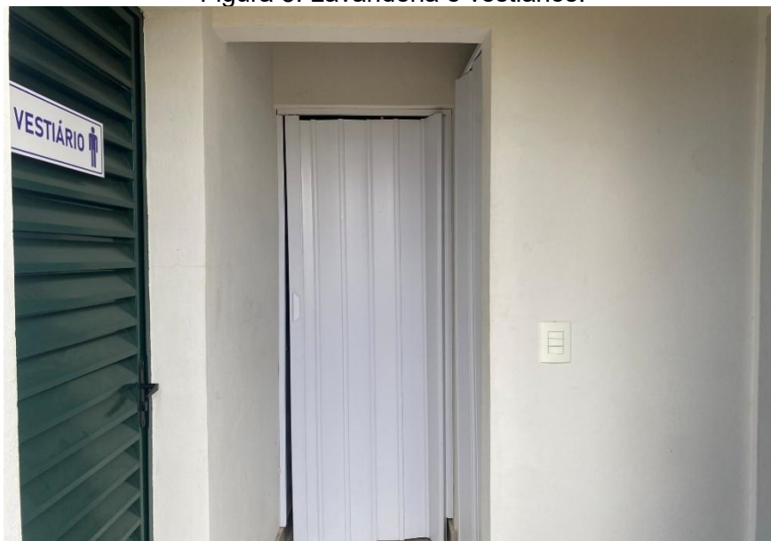
Figura 3: Lavanderia e vestiários.
