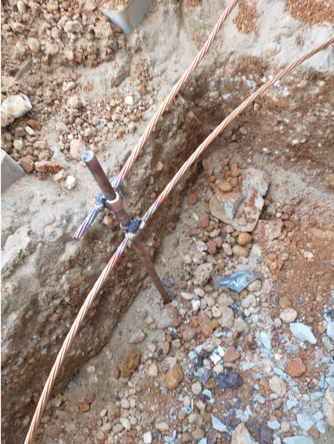
Figura: 08 Solda Exotérmica realizada a fusão entre haste e cabo de cobre nu
