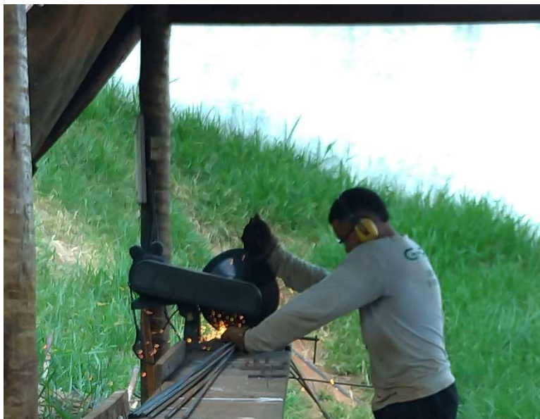
Figura 15: Trabalhador utilizando EPI's durante uso da serra de esquadria
