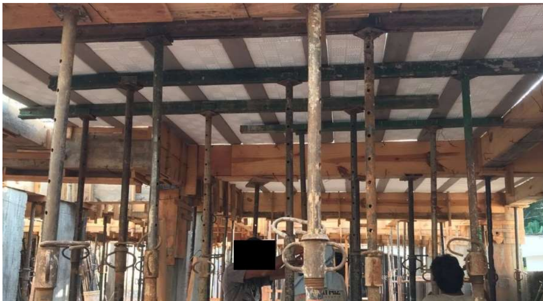
Figura 53: Escoramento da laje
