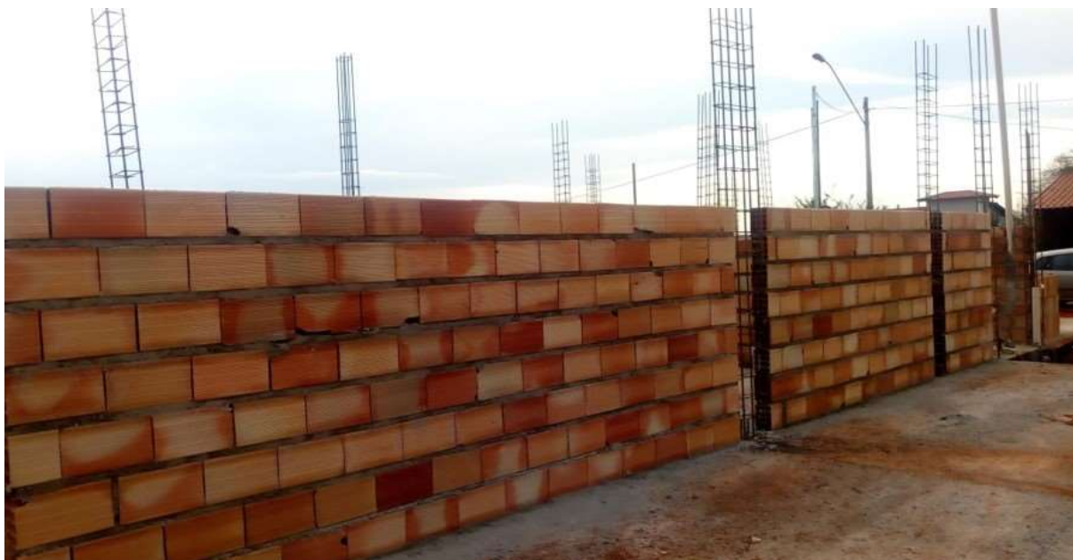
Figura 37: Alvenaria de vedação
