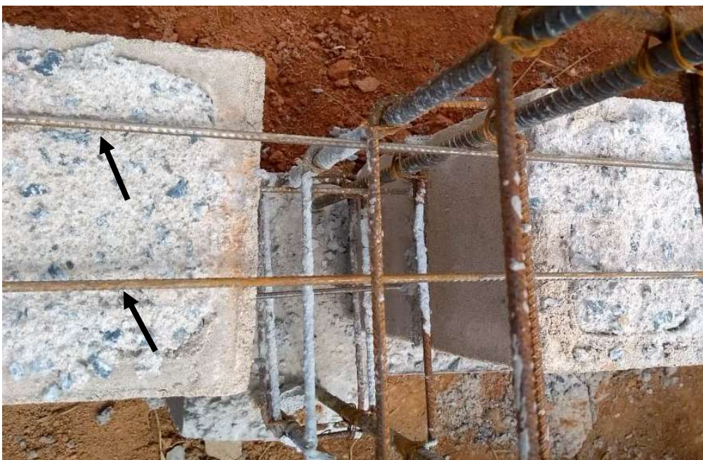
Figura 24: Disposição das barras entre fiadas
