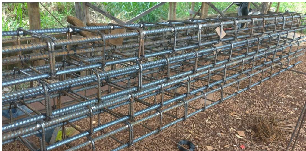
Figura 20: Armações prontas e separadas para entrega
