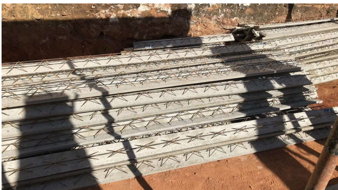
Figura 49: Vigotas com armaduras treliçadas
