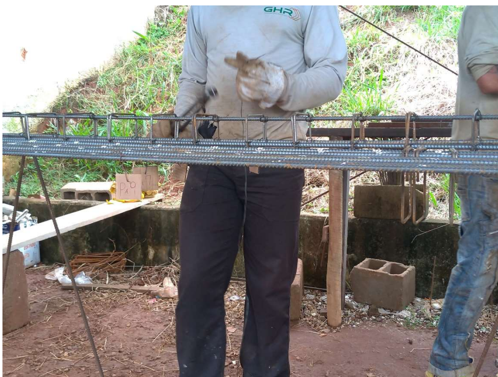
Figura 19: Utilização do Cavalete para ajuste do ambiente ao trabalhador
