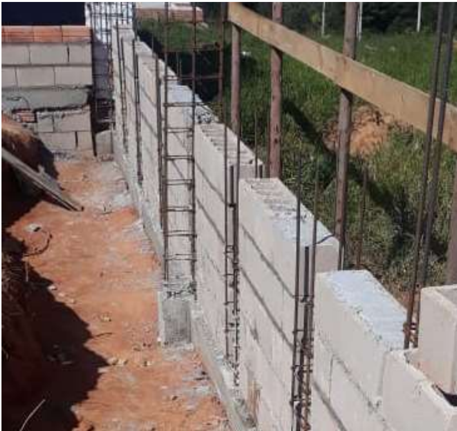
Figura 25: Muro de contenção sendo elevado
