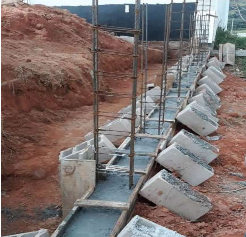
Figura 23: Armações dispostas na sapata corrida
