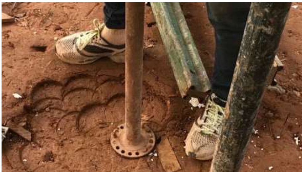
Figura 57: Compactação manual do solo
