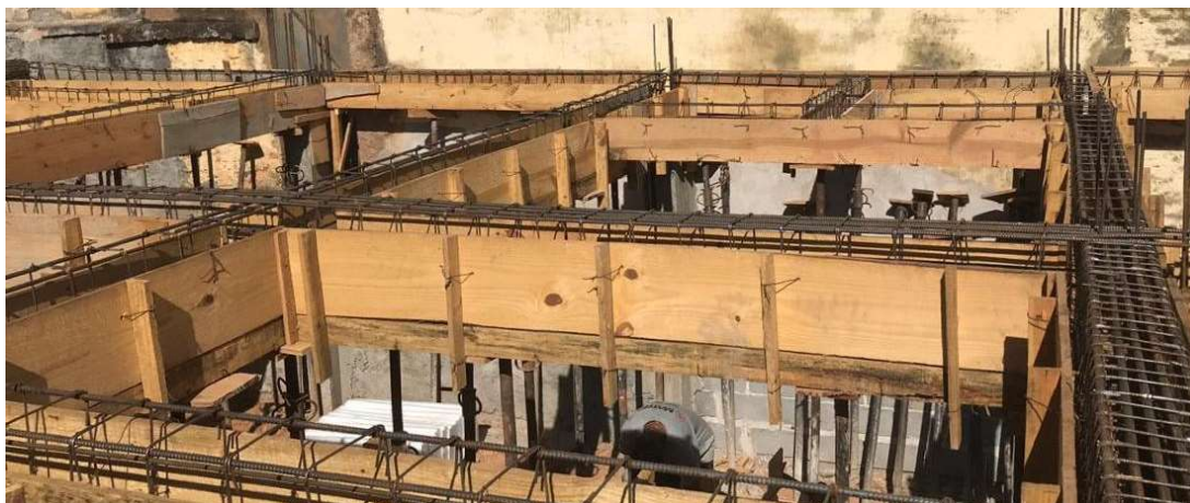
Figura 51: Vigas de ancoragem da laje
