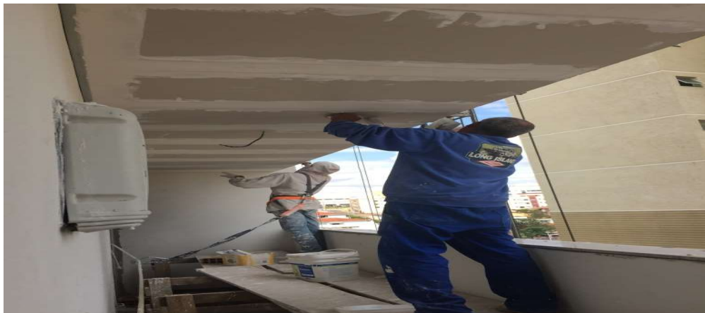
Figura 8: Instalação forro acartonado
