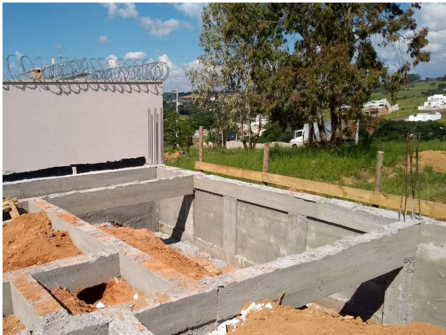
Figura 26: Muro de contenção finalizado
