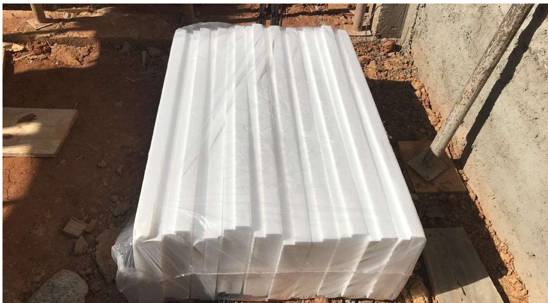
Figura 50: Lajota de EPS para enchimento de laje treliçada
