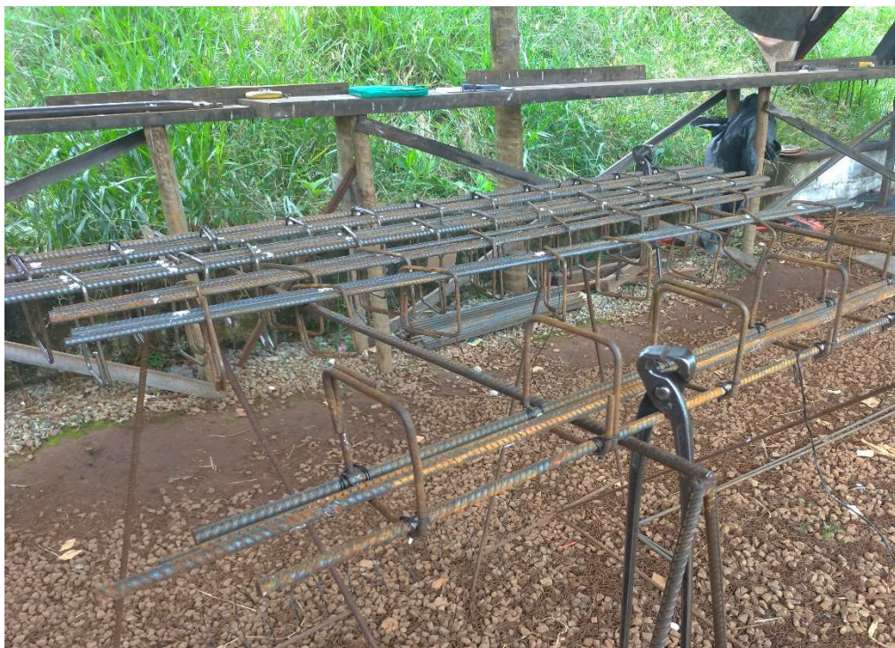
Figura 18: Cavaletes utilizados para adaptação do posto de trabalho
