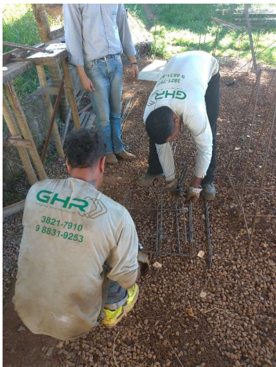
Figura 17: Postura inadequada dos trabalhadores ao exercer uma tarefa
