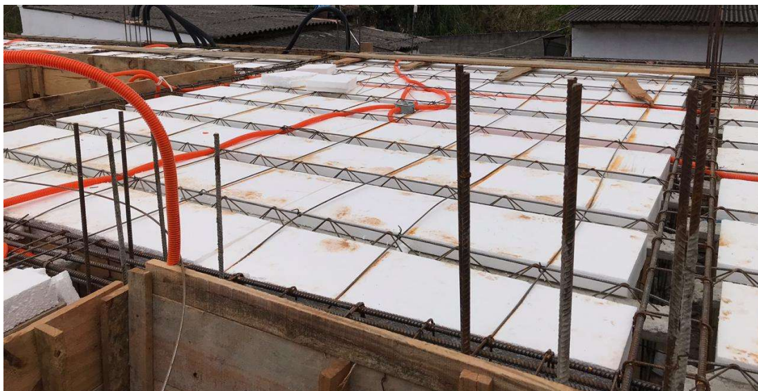
Figura 54: Posicionamento dos eletrodutos para rede elétrica
