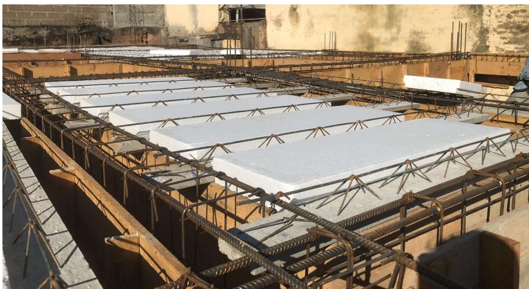
Figura 52: Montagem finalizada da laje com vigotas treliçadas e EPS
