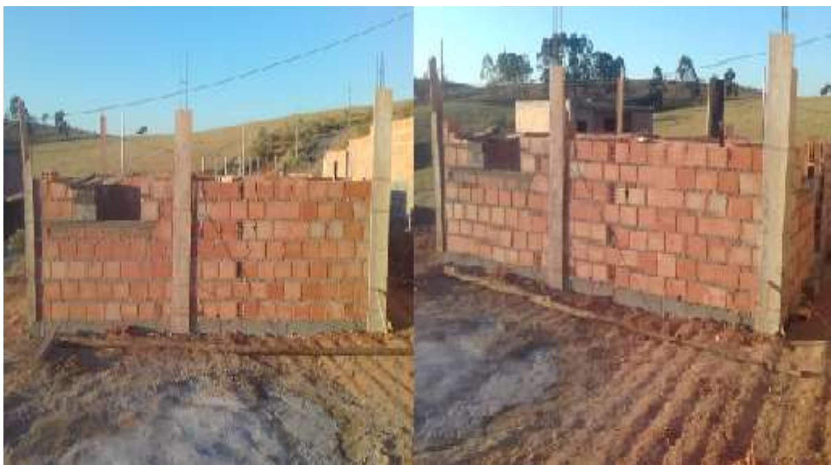
Figura 5: Execução de alvenaria de vedação
