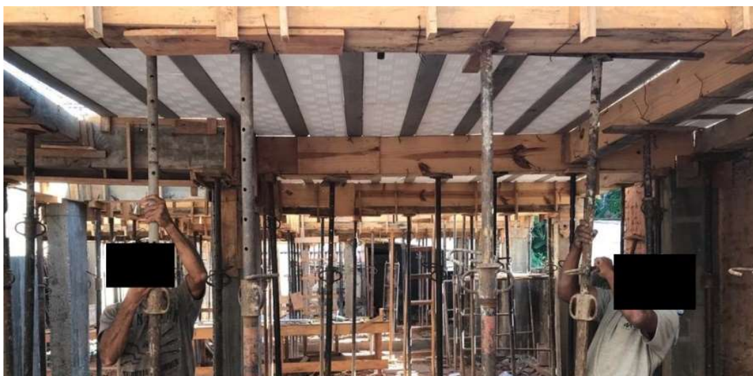
Figura 59: Montagem do sistema de escoramento da laje
