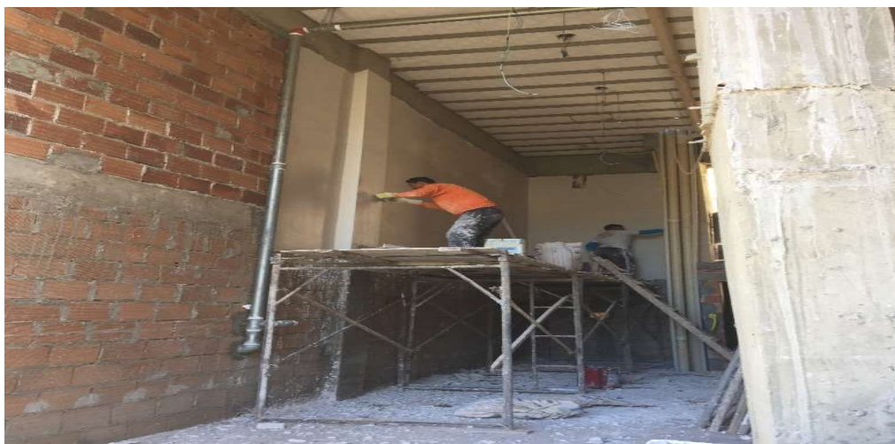
Figura 9: Revestimento de alvenaria em gesso
