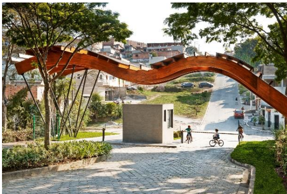
Imagem 3 - Vista da portaria.
