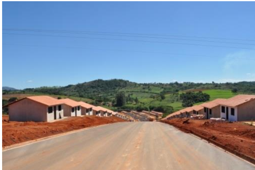
Imagem 35 – Bairro Fonte Verde em fase de construção.
