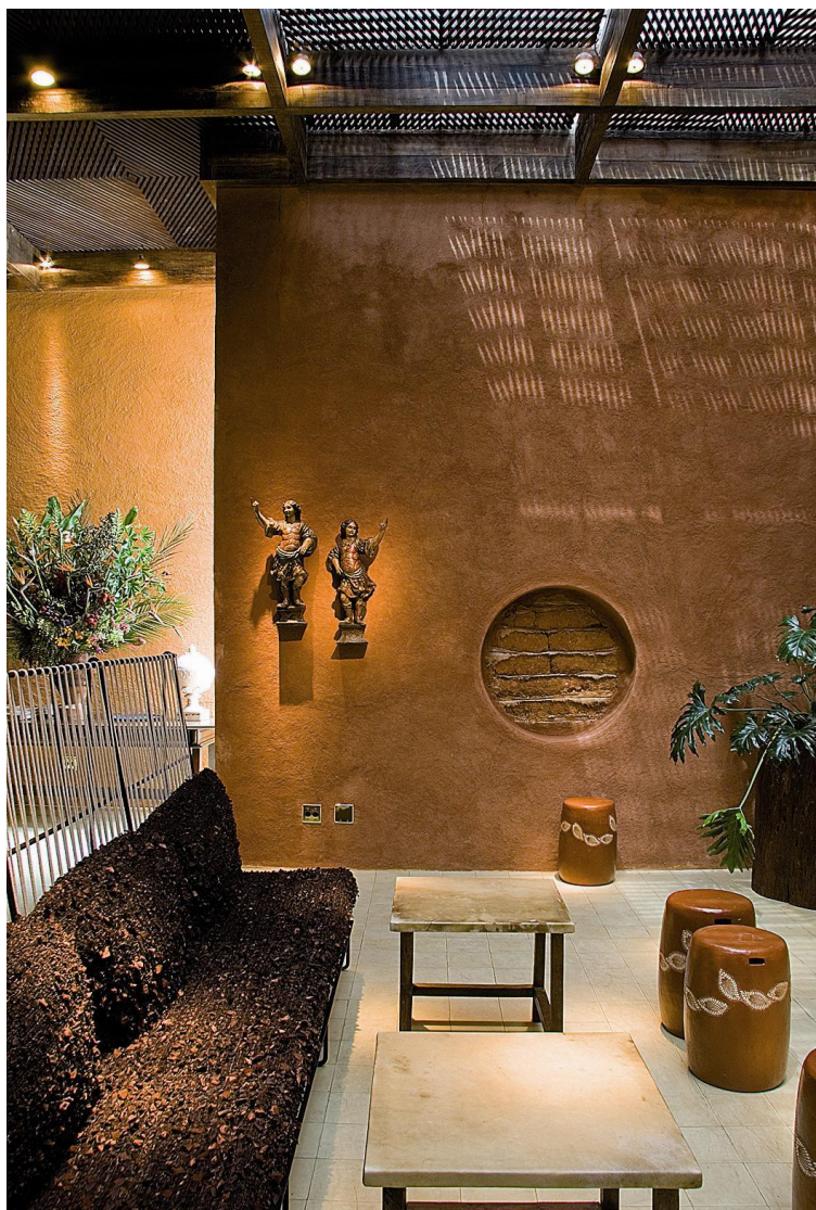
Imagem 11: O recorte circular expõe o interior da parede em superadobe
