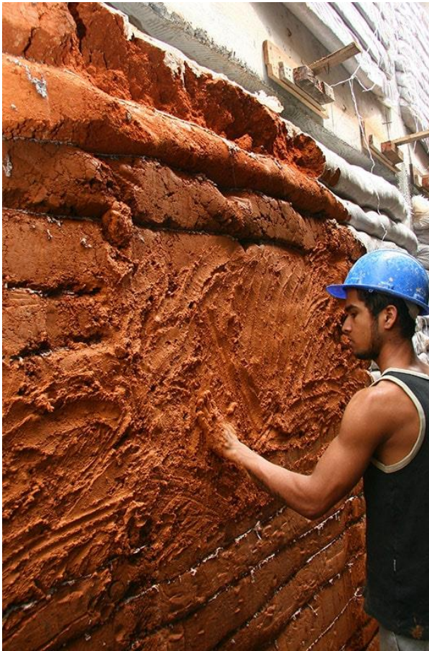
Imagem 13: Acabamento com reboco com terra
