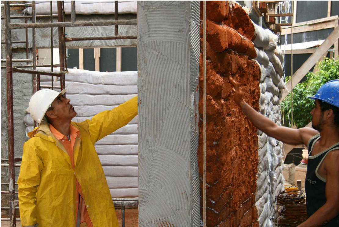
Imagem 12: Execução das paredes em superadobe
