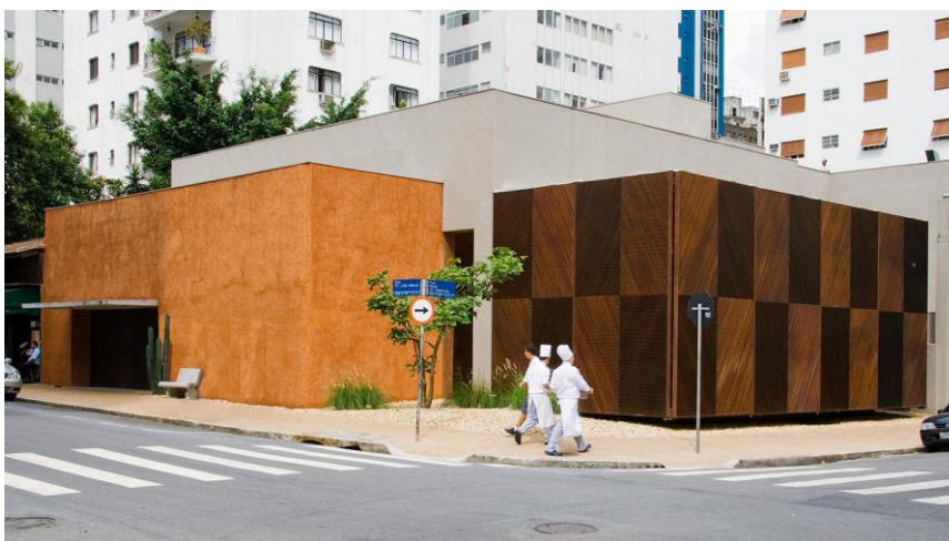
Imagem 4: Fachada principal do restaurante.
