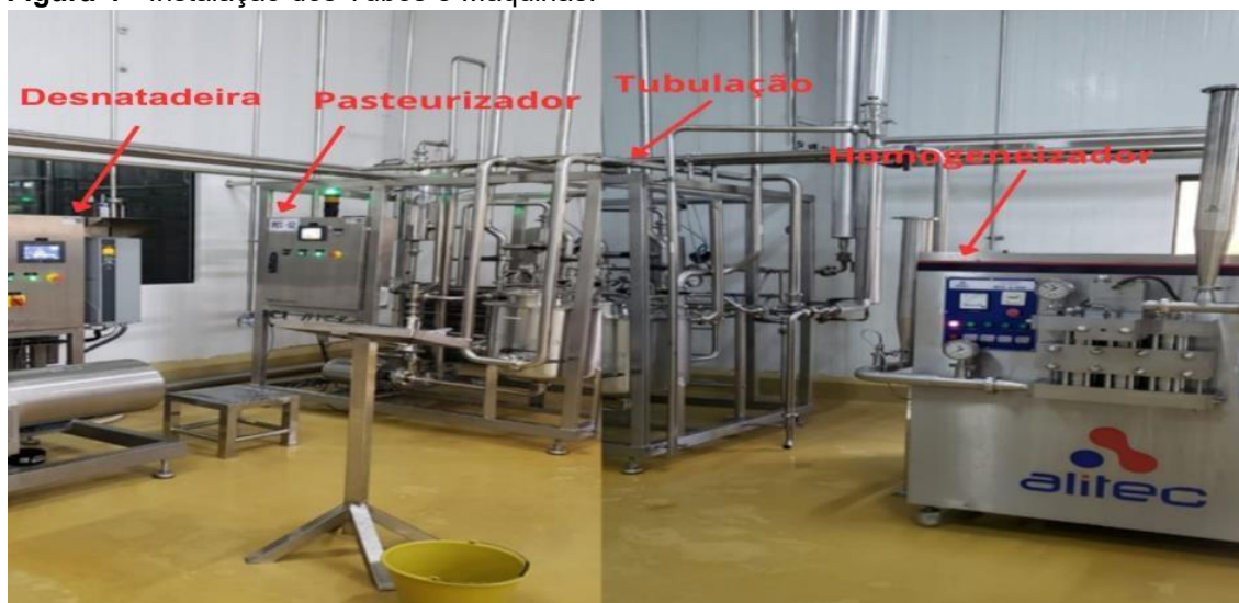
Figura 4 - Instalação dos Tubos e Máquinas.
