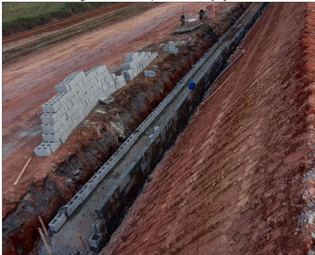
Figura 82 – Construção da canaleta projetada
