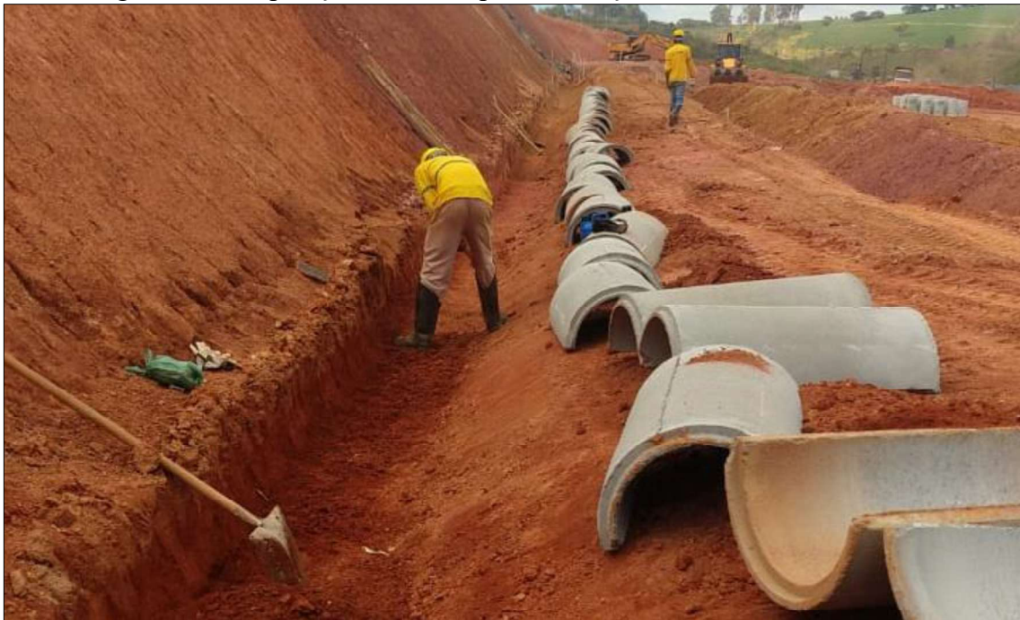
Figura 34 – Preparação da bermas para instalação das canaletas meia cana
