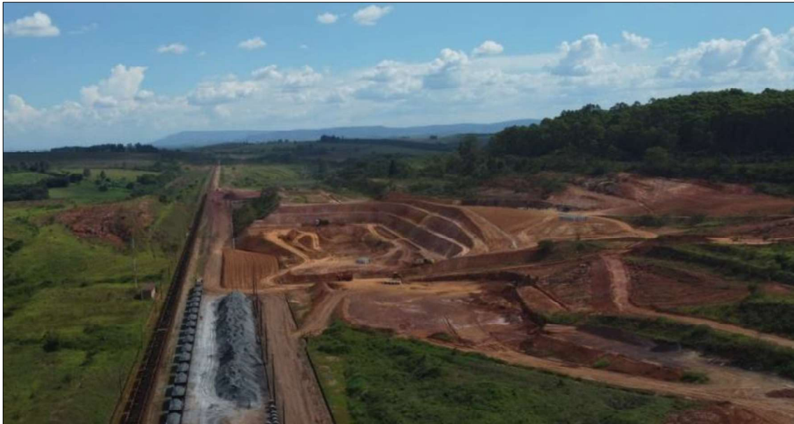
Figura 60 – Andamento da obra de escavação
