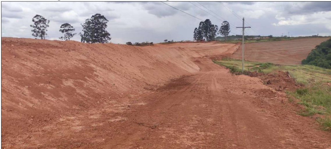
Figura 72 – Vista do talude, na parte baixa do aterro finalizado
