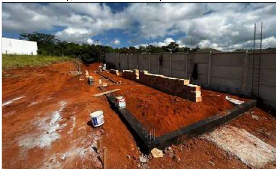
Figura 50 – Baldrames impermeabilizados
