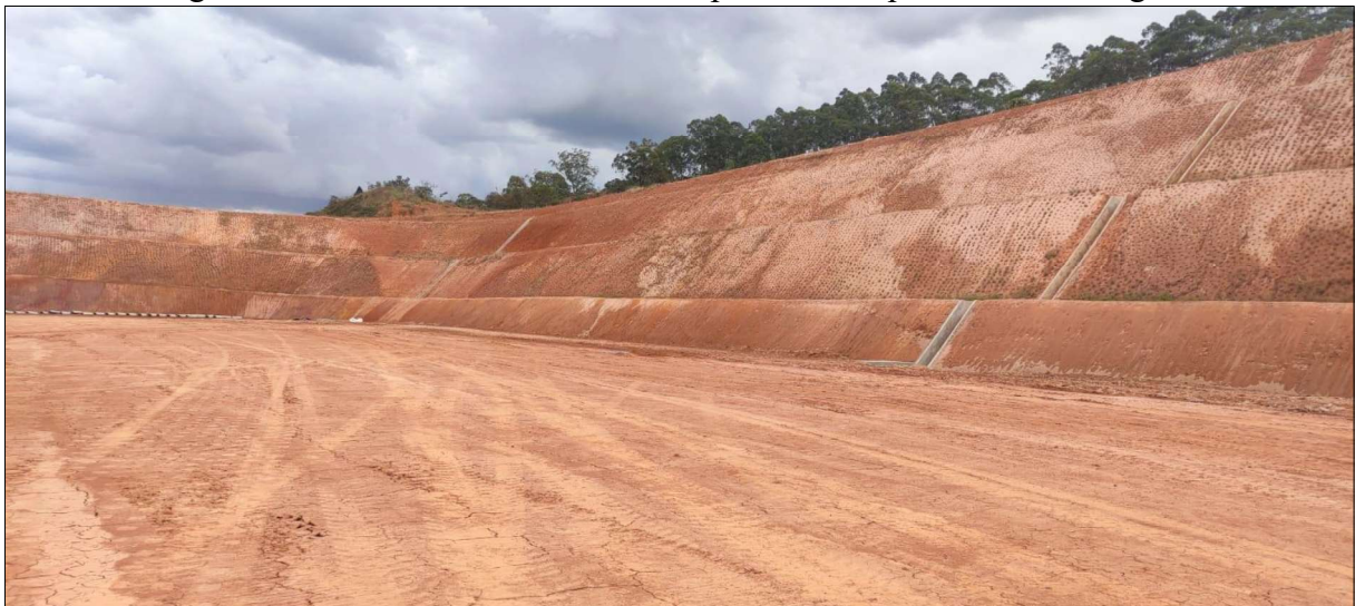
Figura 40 – Platô concluído com vista para os dissipadores de drenagem
