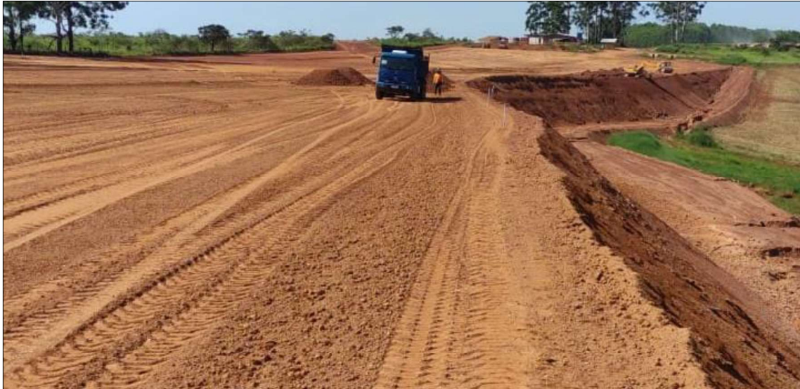
Figura 70 – Construção do aterro
