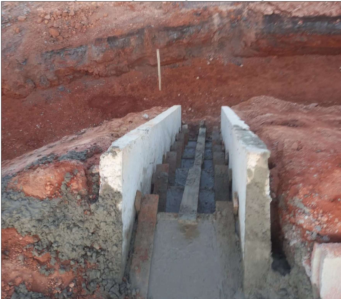
Figura 37 – Dissipador de energia na fase concretagem
