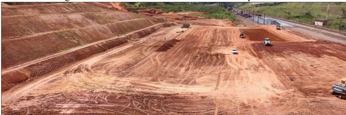
Figura 32 – Vista da obra mostrando os taludes após o corte
