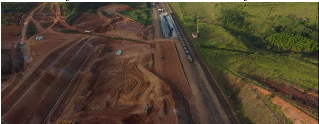
Figura 3 – Local da obra com início das obras de drenagens
