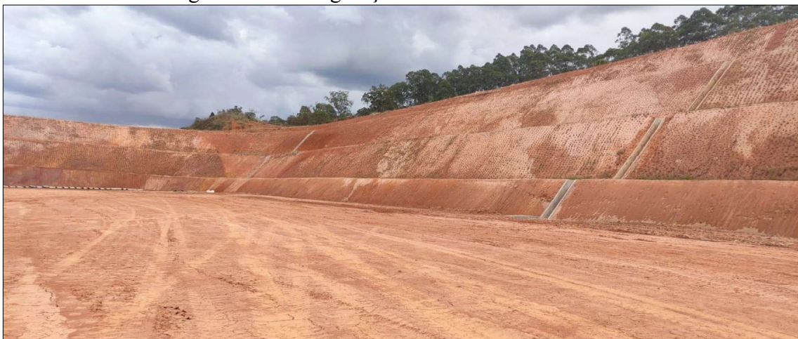
Figura 64 – Configuração final dos taludes de corte
