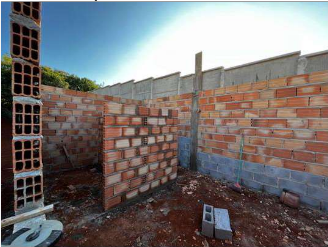
Figura 51 – Paredes de alvenaria da obra
