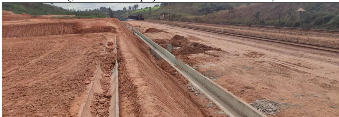
Figura 83 –Canaleta projetada em fase final de construção
