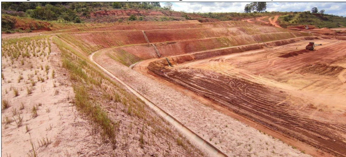
Figura 33 – Vista da instalação das drenagens, detalhe na inclinação das bermas
