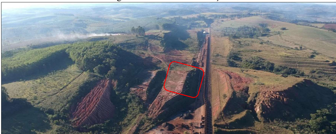
Figura 59 – Local da escavação
