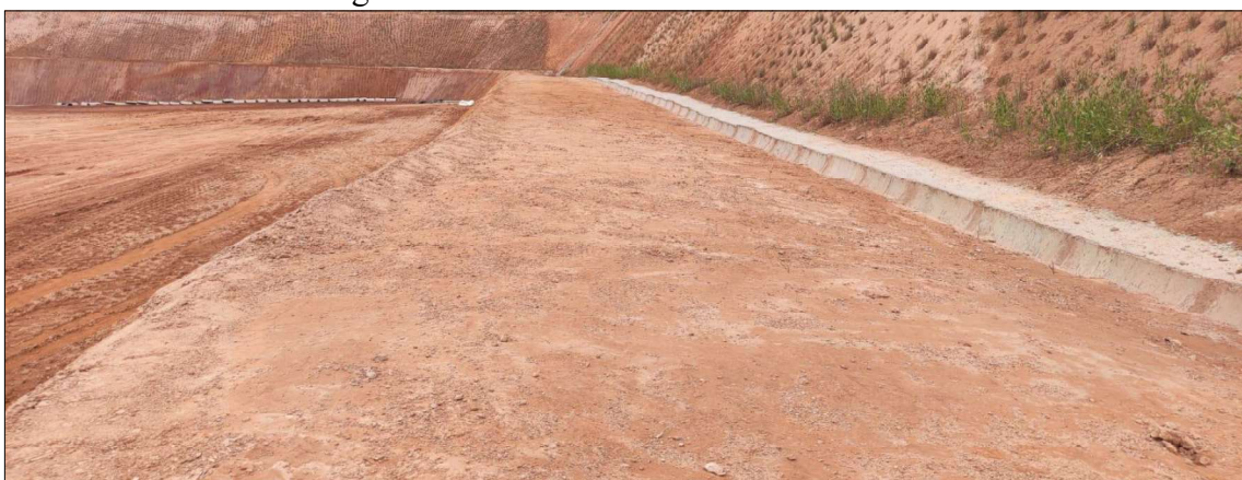
Figura 35 – Bermas com canaleta finalizada
