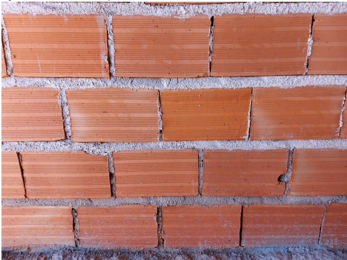
Figura 53 – Assentamento de tijolos
