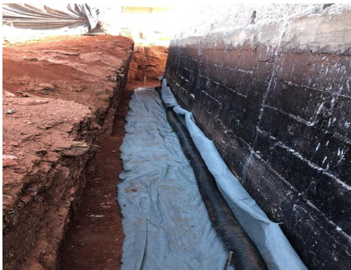
Figura 14 – Muro de arrimo impermeabilizado e drenado
