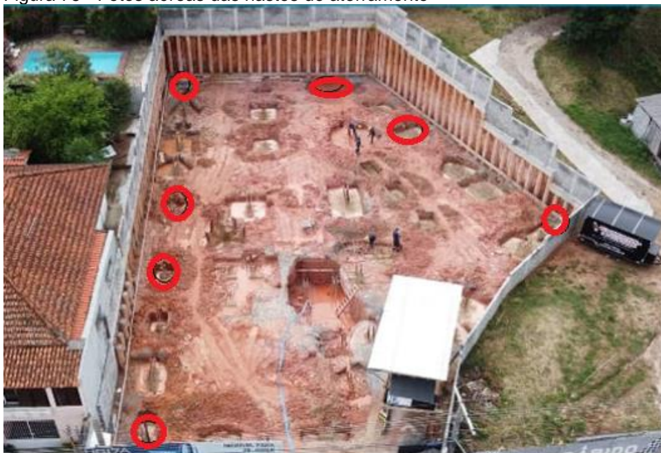
Figura 75 - Fotos aéreas das hastas de aterramento
