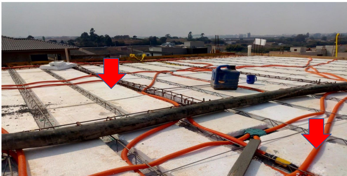
Figura 42 – Laje preenchida com isopor (EPS) e tubulações (Eletroduto Corrugado)
