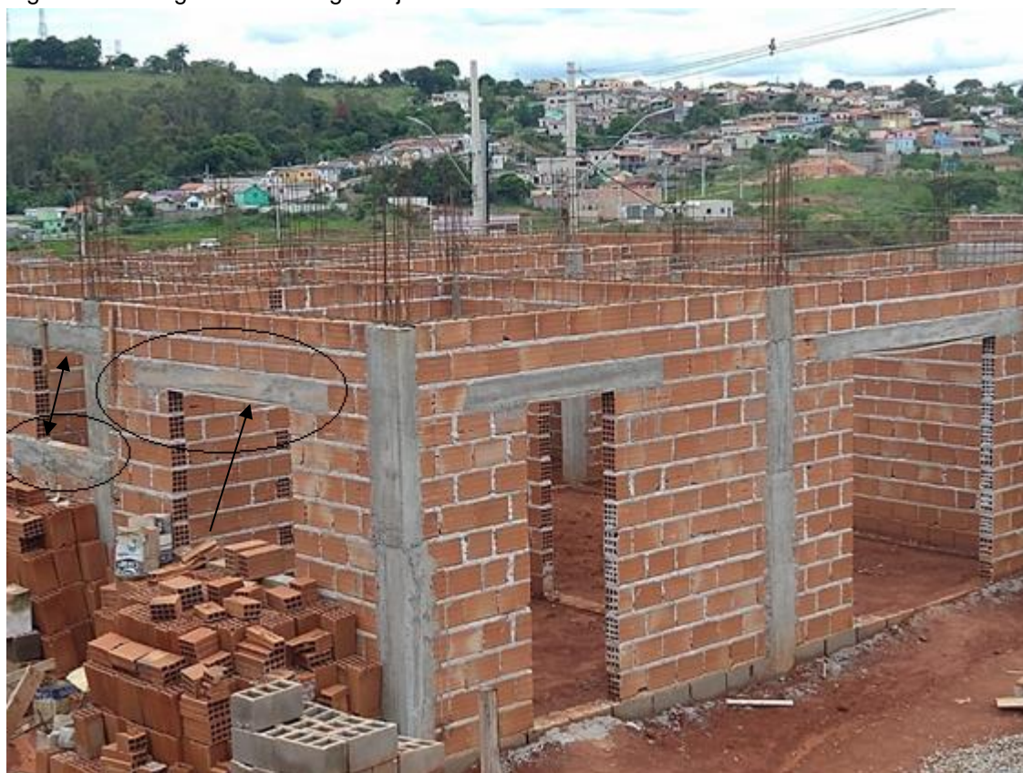
Figura 54 – Verga e contraverga na janela
