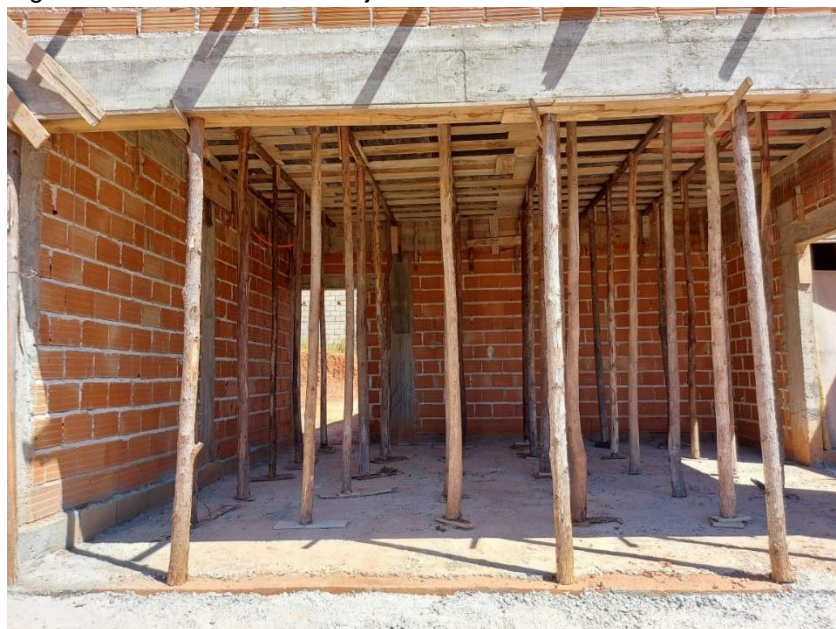
Figura 45 - Escoramento da laje
