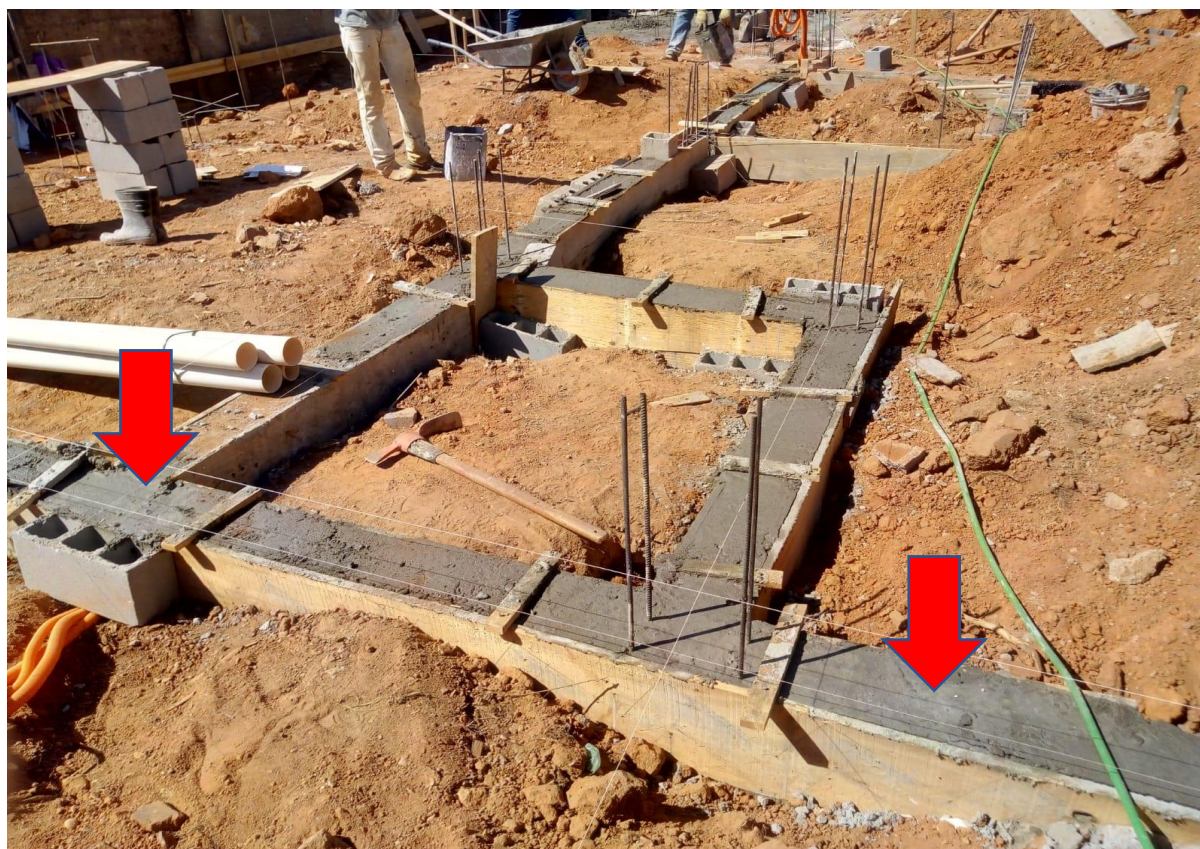
Figura 33 – Estrutura de fôrmas concretada
