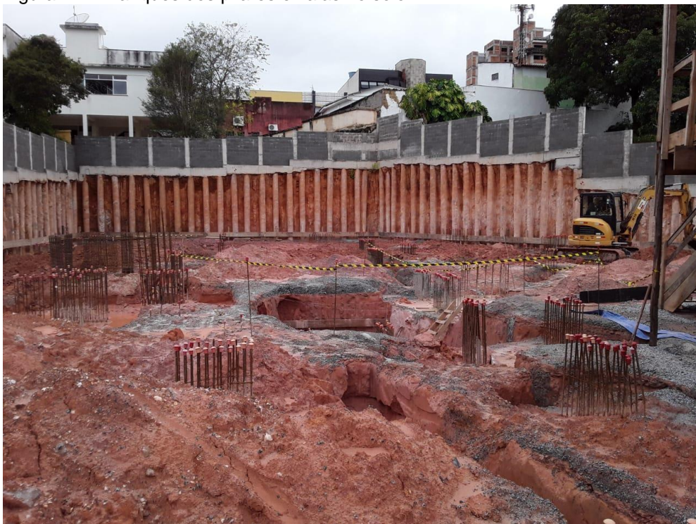
Figura 71- Arranques dos pilares e valas no solo
