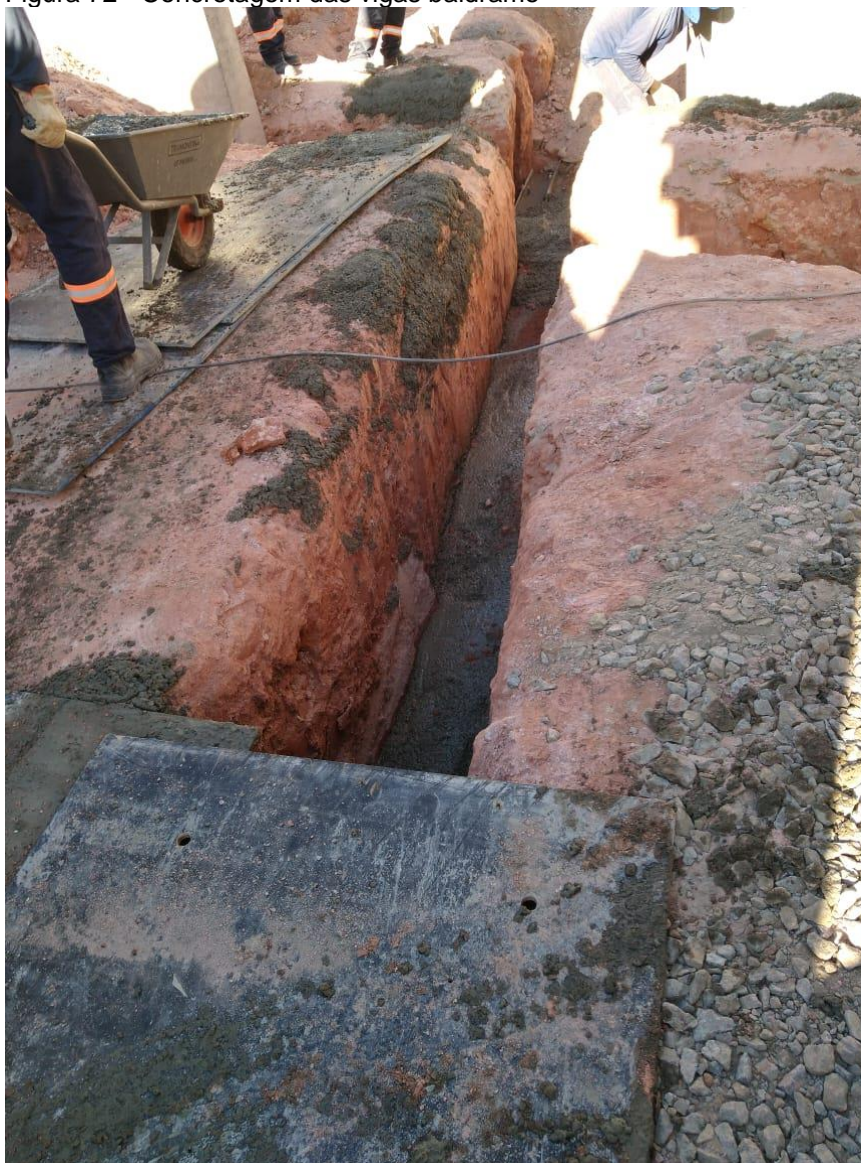
Figura 72 - Concretagem das vigas baldrame
