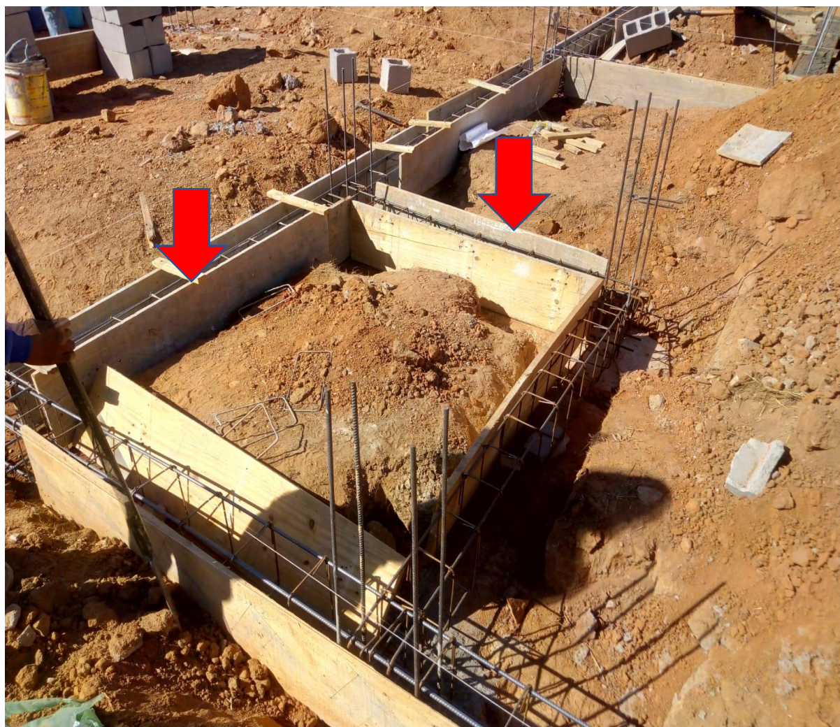
Figura 32 - Estruturas de fôrmas
