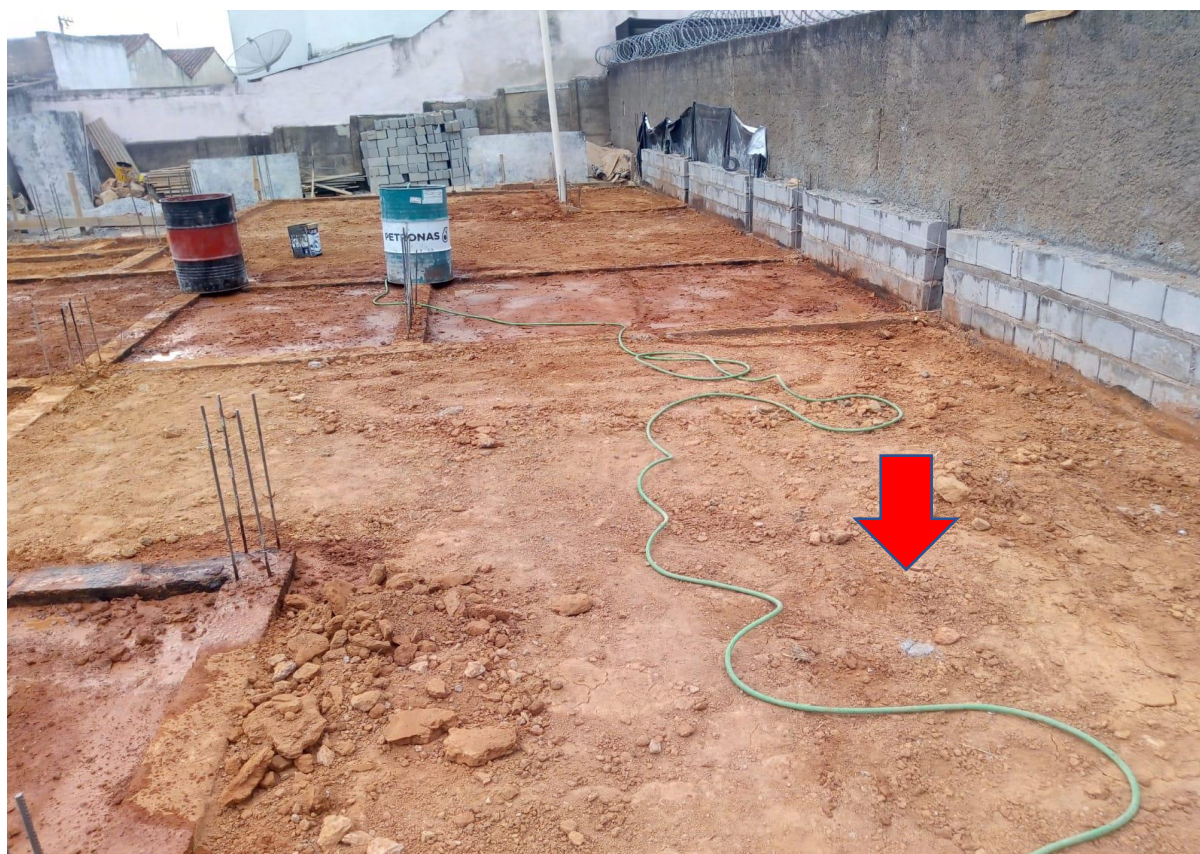
Figura 35 – Nivelamento da área interna para a concretagem
