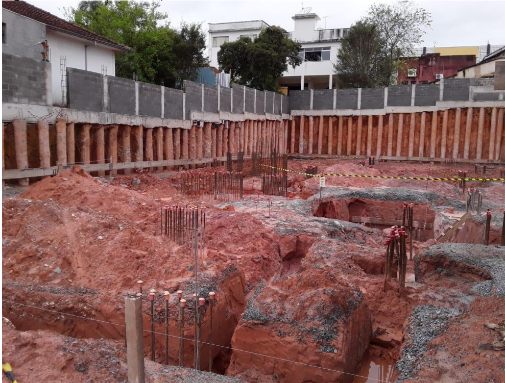
Figura 70- Arranques dos pilares e valas no solo
