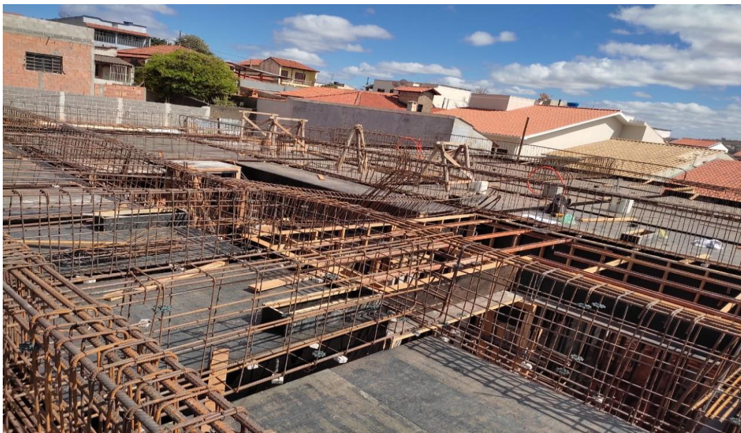
Figura 19 – Armaduras colocadas
