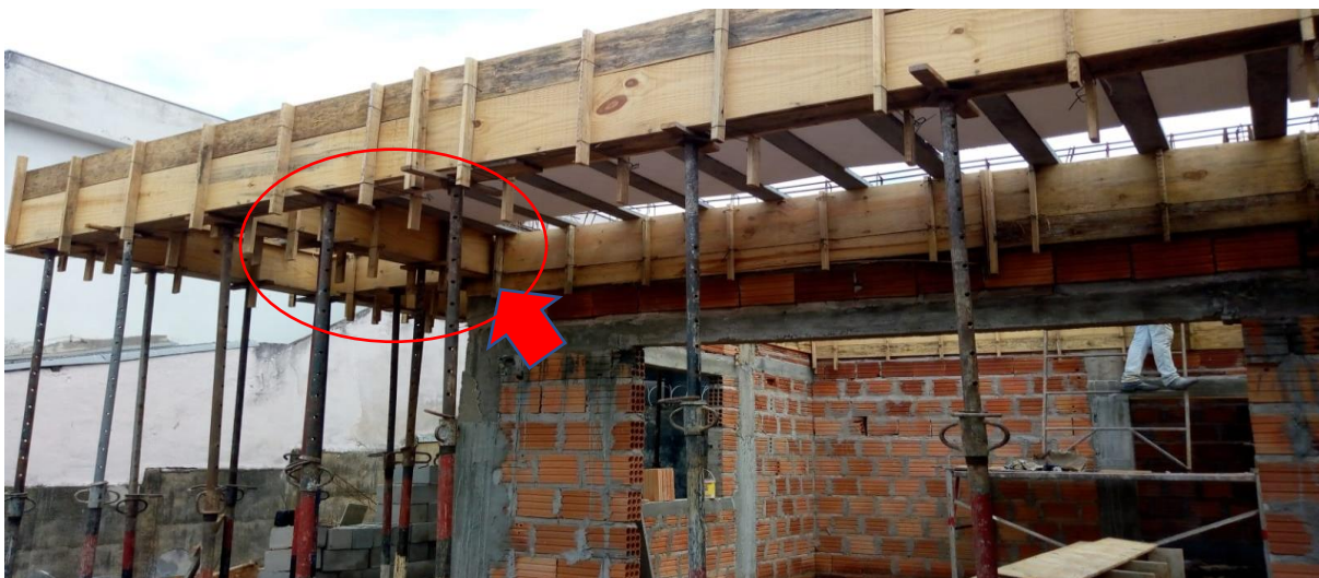
Figura 40 – Viga em balanço
