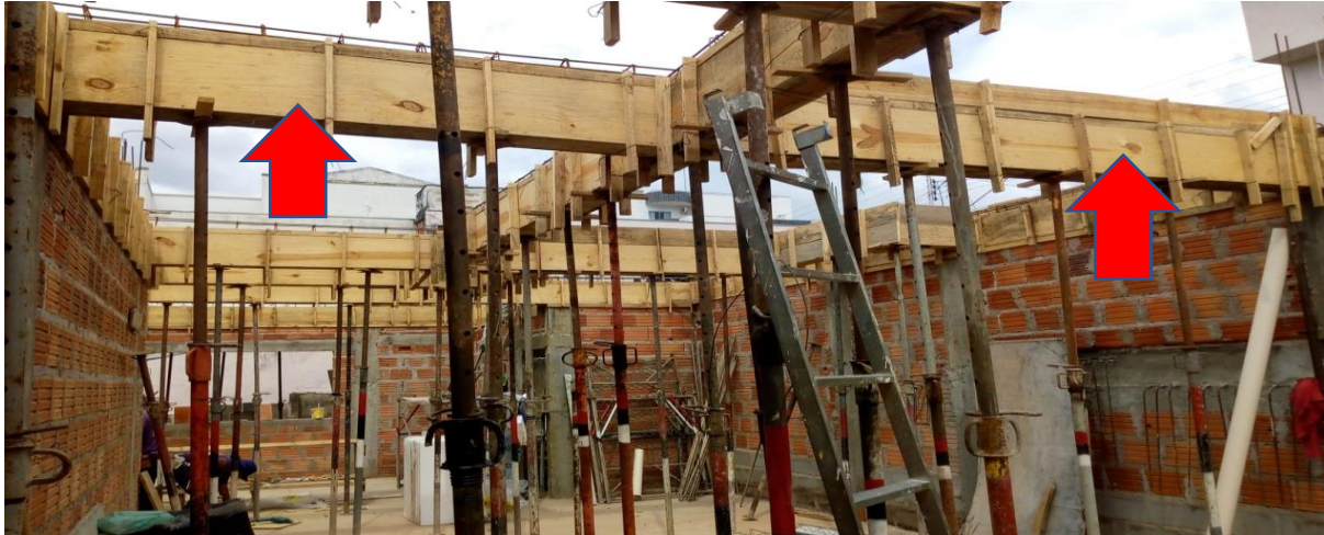
Figura 39 – Estruturas de vigas
