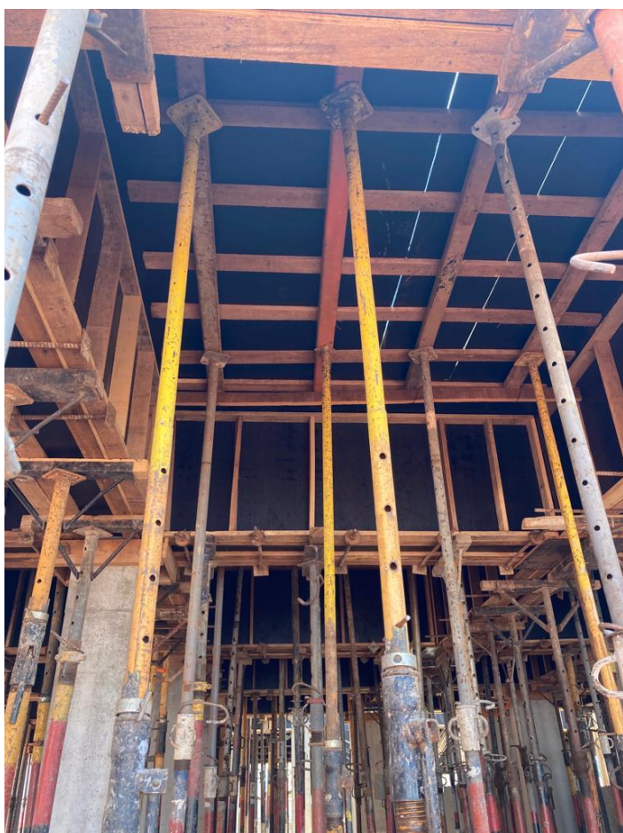
Figura 18 – Escoras e fôrmas dos fundos de vigas e lajes
