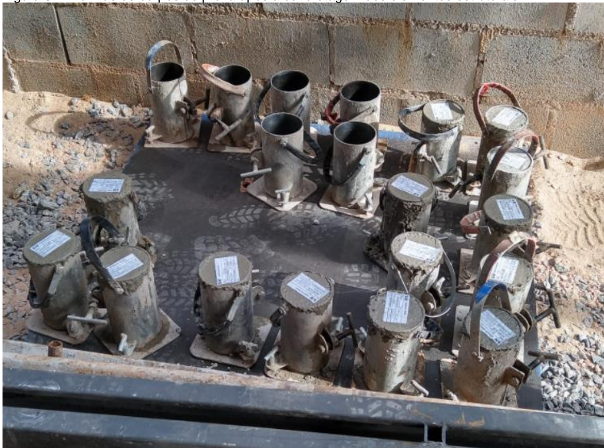
Figura 81 - Formas de corpos de prova após a concretagem dos elementos estruturais
