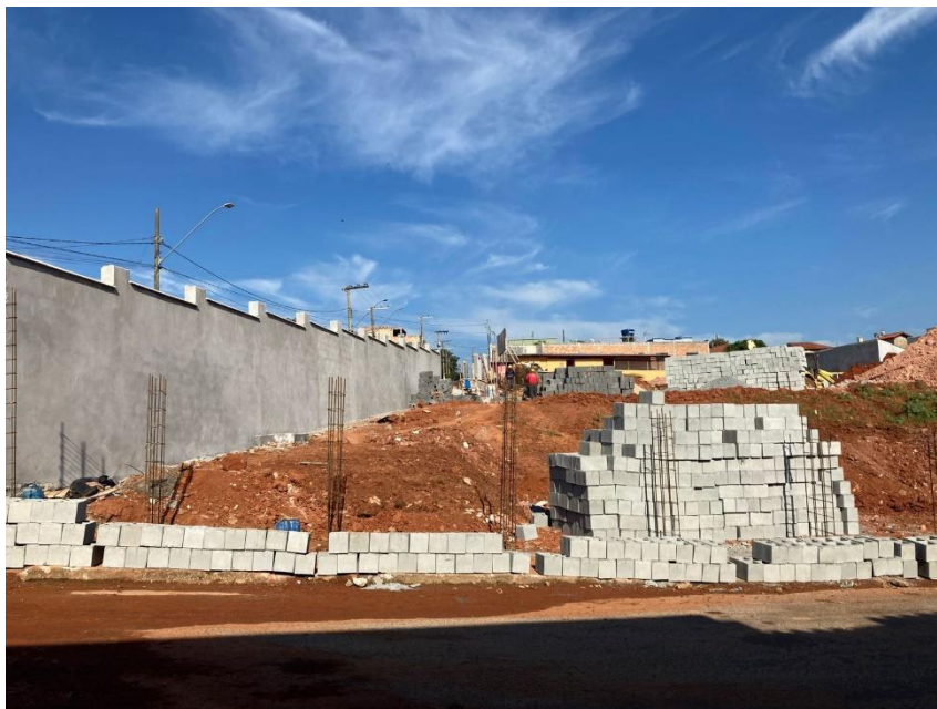
Figura 11 – Início da construção do muro de arrimo
