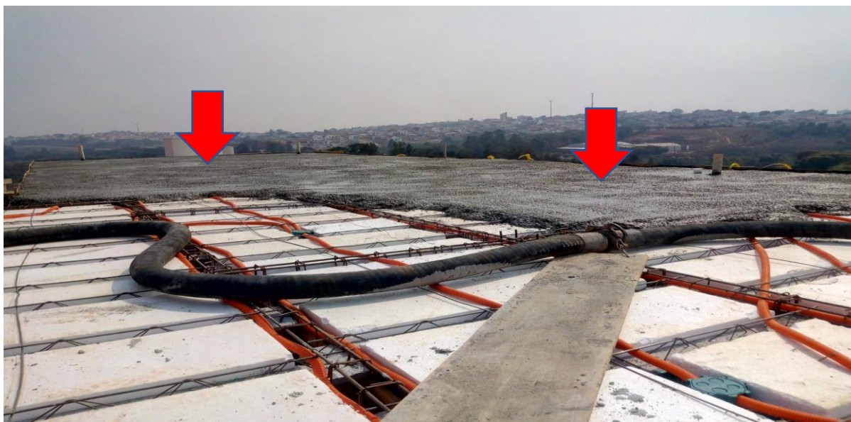
Figura 43 – Laje sendo concretada
