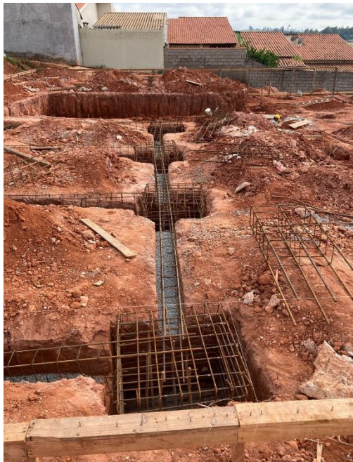
Figura 9 – Armações em aço e blocos colocados após concretagem de estacas
