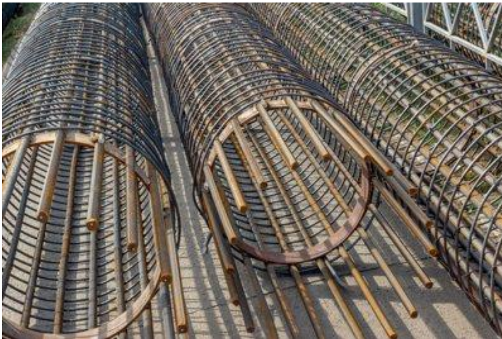
Figura 4 – Ferragem das estacas
