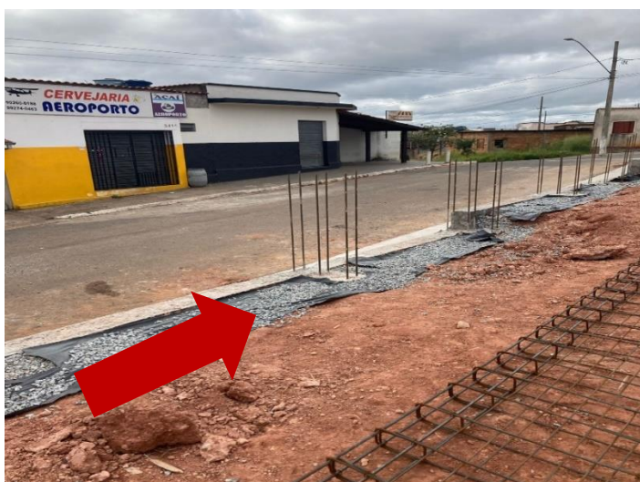
Figura 13 – Pilares de sustentação concretados
