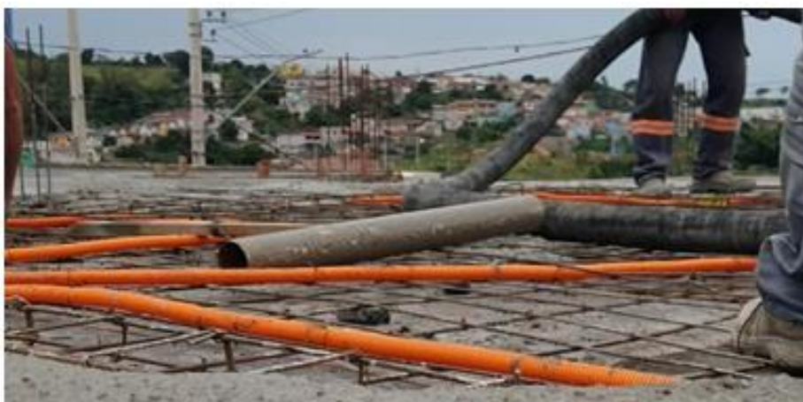
Figura 47 – Concretagem da Laje
