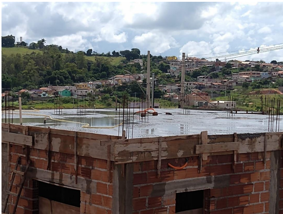
Figura 48 – Cura da Laje
