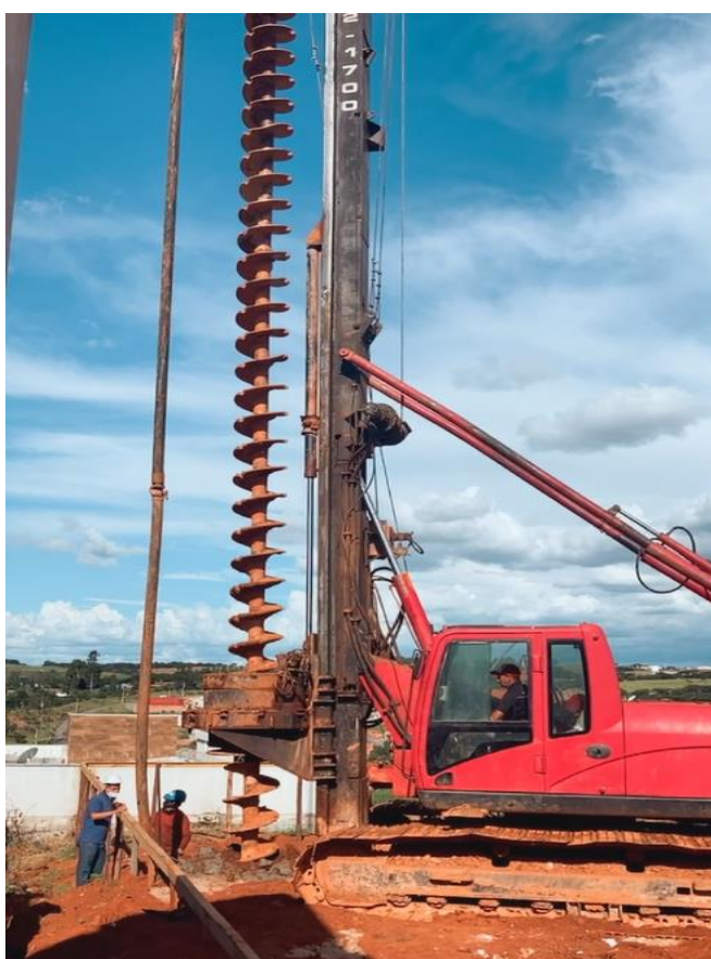
Figura 5 – Perfuratriz para escavação monitorada das estacas
