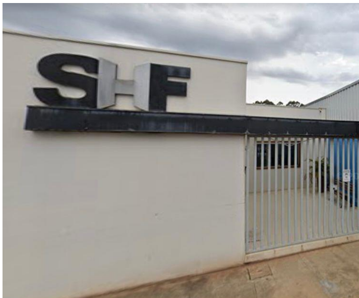
Figura 1 – Fachada da empresa
