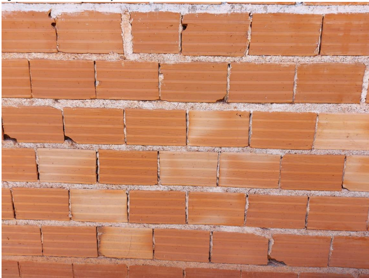
Figura 49 – Alvenaria de vedação
