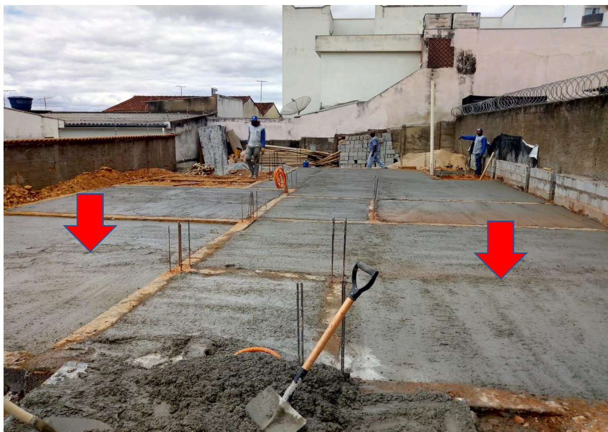
Figura 36 – Execução do contrapiso
