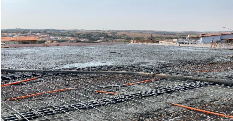
Figura 20 – Concretagem da laje maciça
