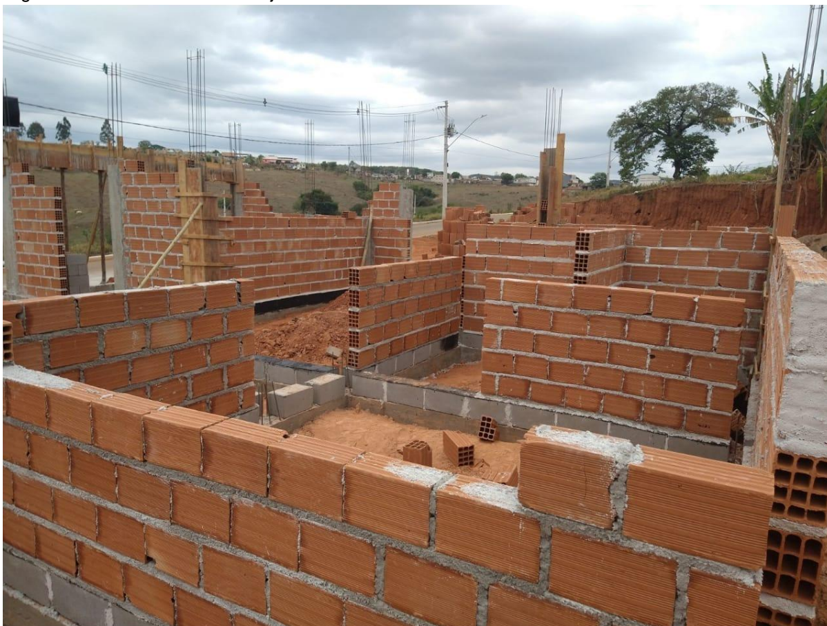
Figura 51 – Assentamento dos tijolos
