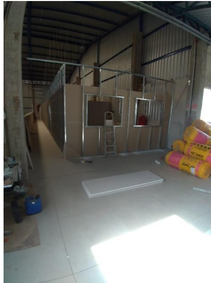
Figura 11 – Continuação da execução
