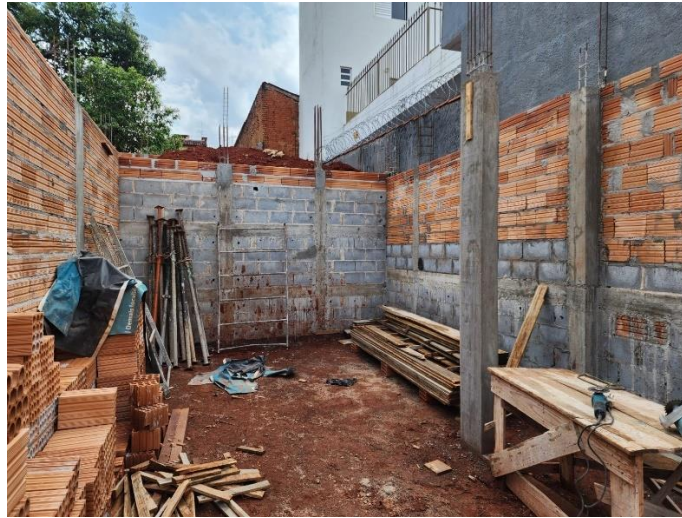
Figura 32 – Alvenarias do térreo respaldadas
