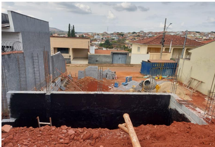
Figura 27 – Muro de arrimo com impermeabilizante
