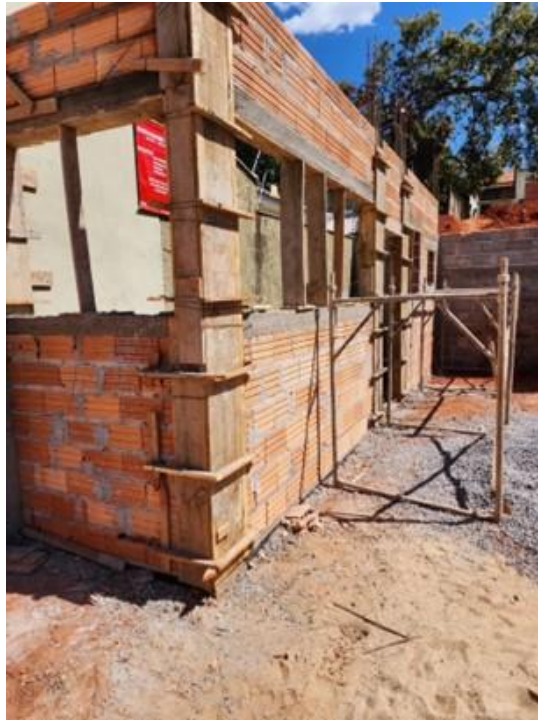
Figura 36 – Vergas e Contravergas da obra (ângulo 2)
