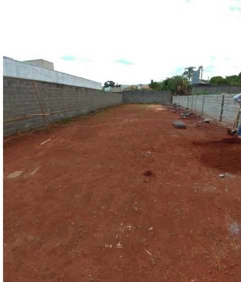
Figura 6 – Canteiro de Obra
