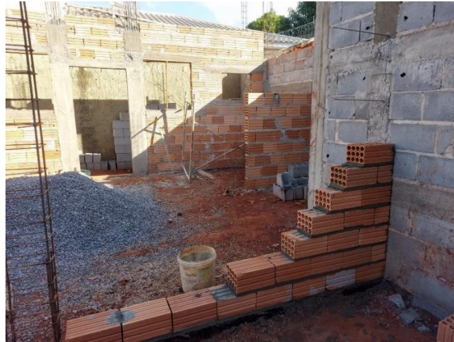
Figura 30 – Execução da prumada guia na obra
