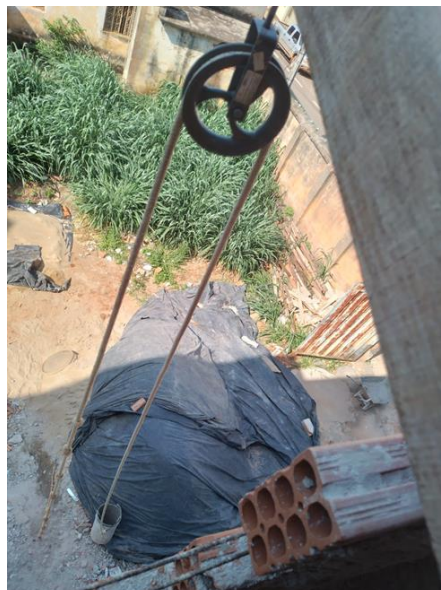
Figura 7 – Canteiro de Obra no Segundo Pavimento
