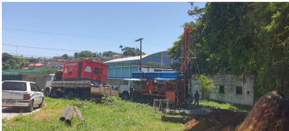
Figura 66 – Caminhões utilizados na perfuração do poço
