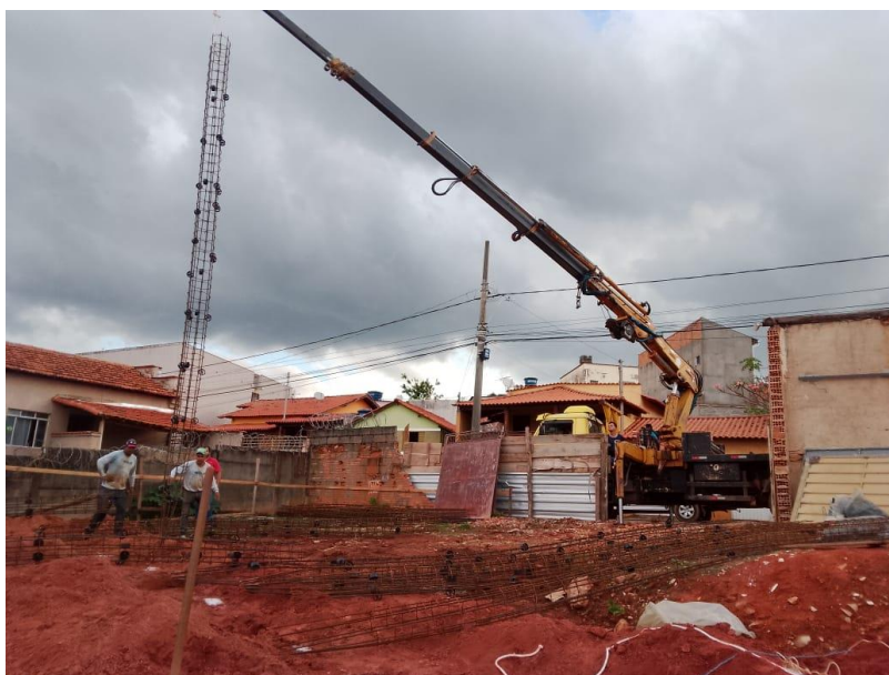
Figura 8 – Caminhão Munck em operação
