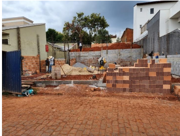
Figura 18 – Fachada da obra
