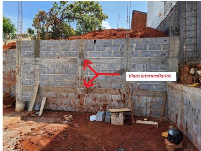
Figura 26 – Vigas Intermediárias
