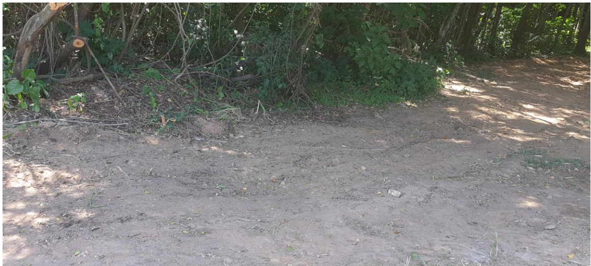
Figura 74 – Local onde está passando tubulação do poço para o reservatório
