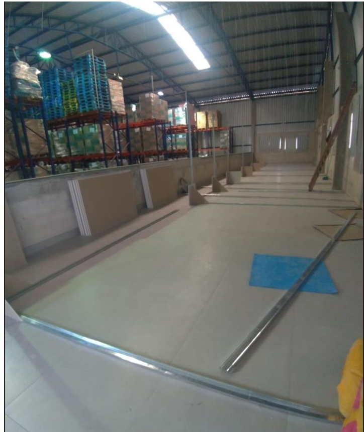
Figura 10 – Início da execução
