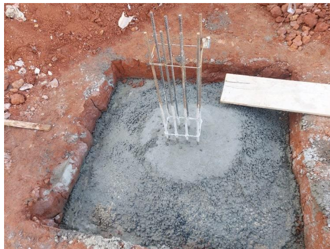
Figura 22 – Sapata concretada
