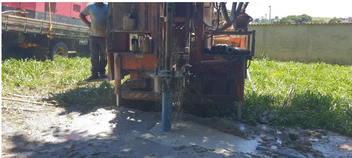
Figura 69 – Momento de perfuração do poço
