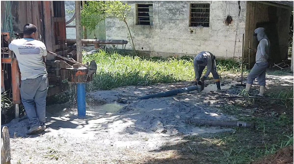
Figura 71 – Técnicos fazendo a estimativa de vazão do poço
