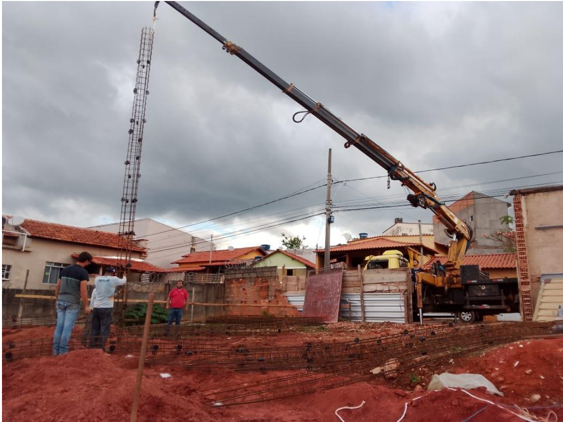
Figura 16 – Tubulão sendo colocado nos furos
