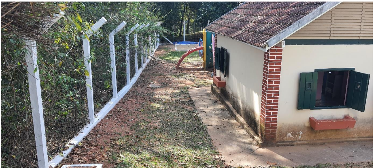
Figura 50 – Local para construção do banheiro visto de outro sentido
