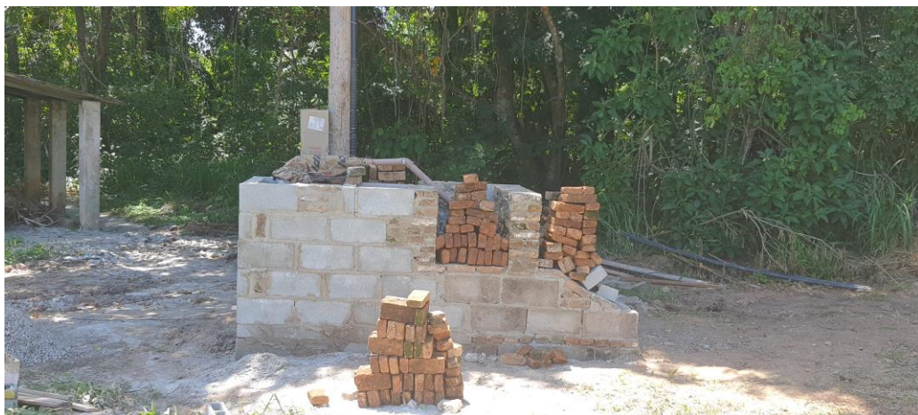
Figura 77 – Estrutura complementar do poço
