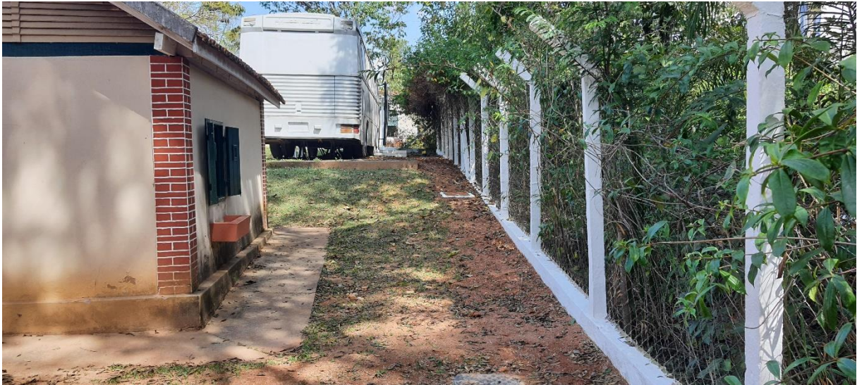
Figura 49 – Local para a construção do banheiro
