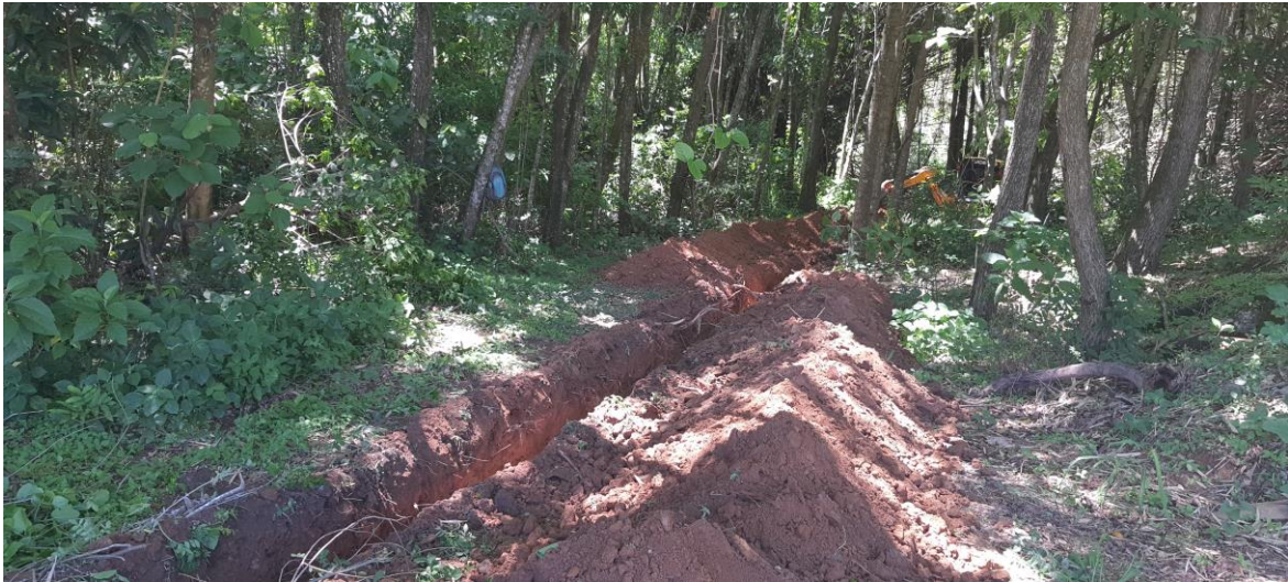
Figura 73 – Vala para a passagem de água do poço para o reservatório
