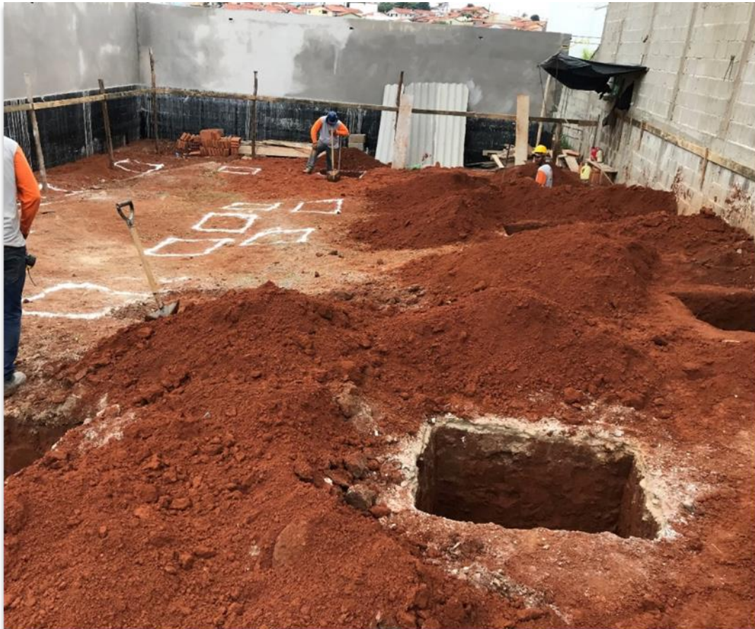
Figura 38 - Canteiro de Obras da Edificação
