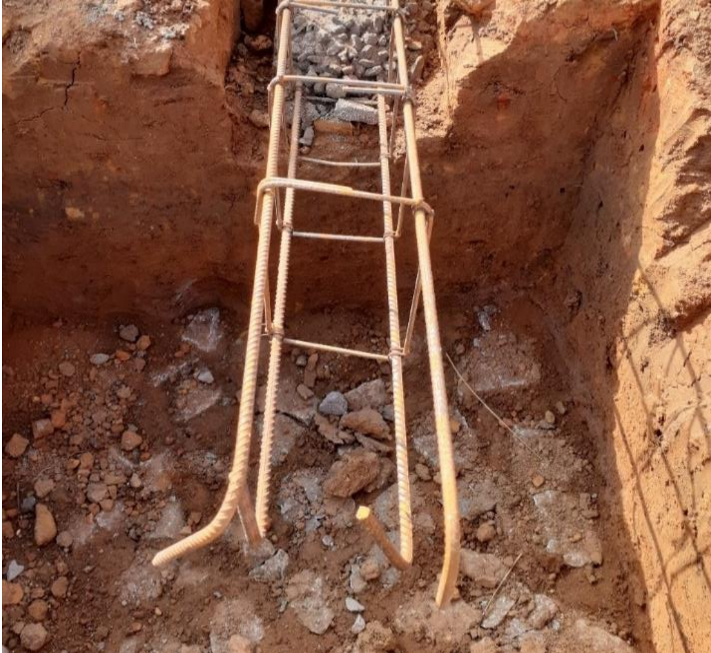
Figura 75 - Compactação do Solo
