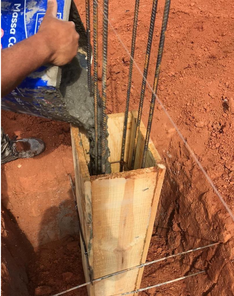
Figura 46 - Concretagem do Pilar da Sapata
