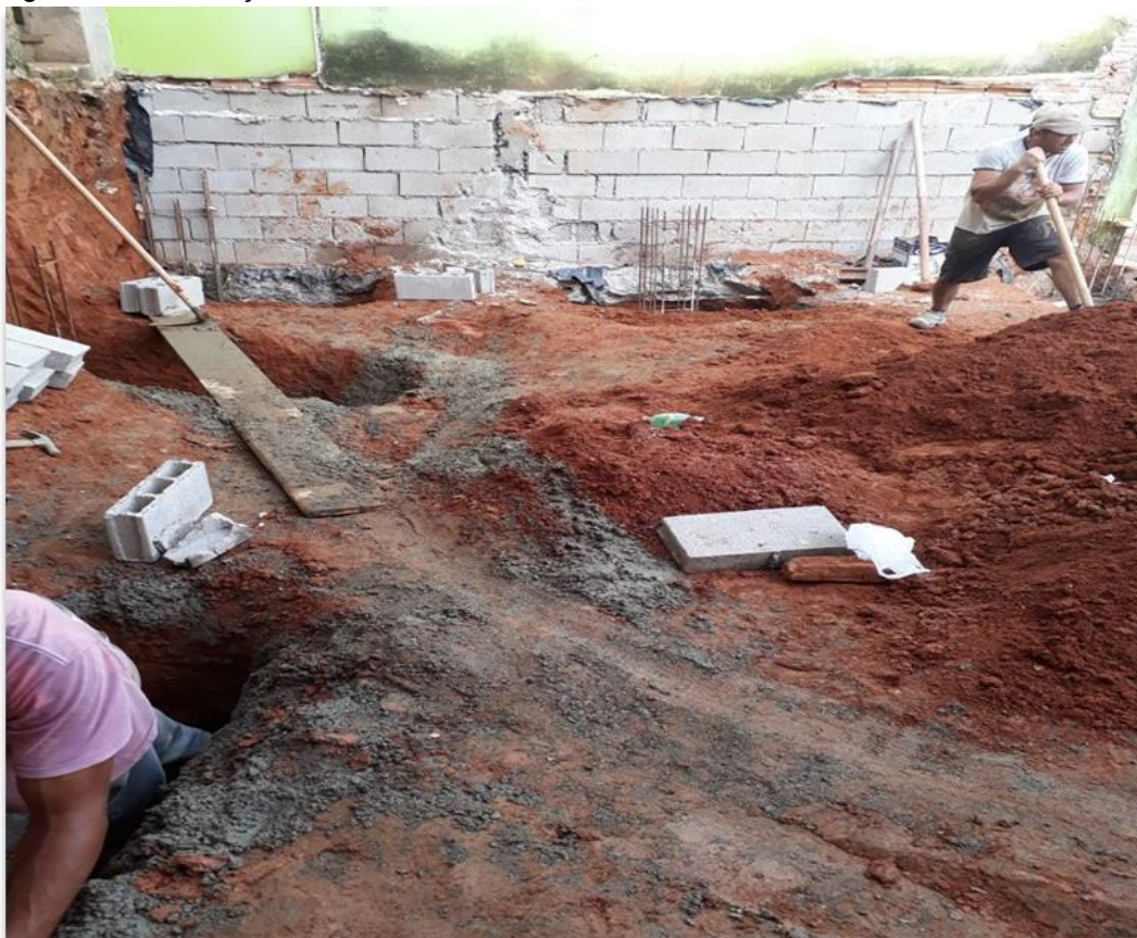
Figura 74 - Perfuração do Terreno
