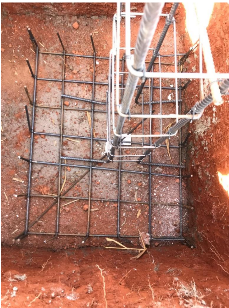
Figura 44 - Armadura da Sapata
