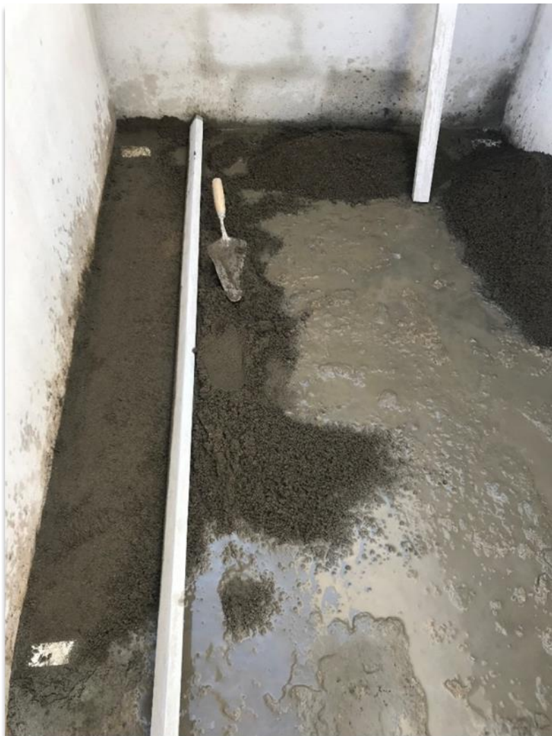
Figura 56 - Execução do Contrapiso
