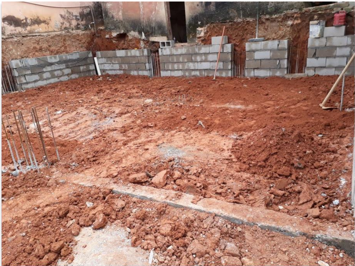
Figura 79 - Execução da Fundação Finalizada
