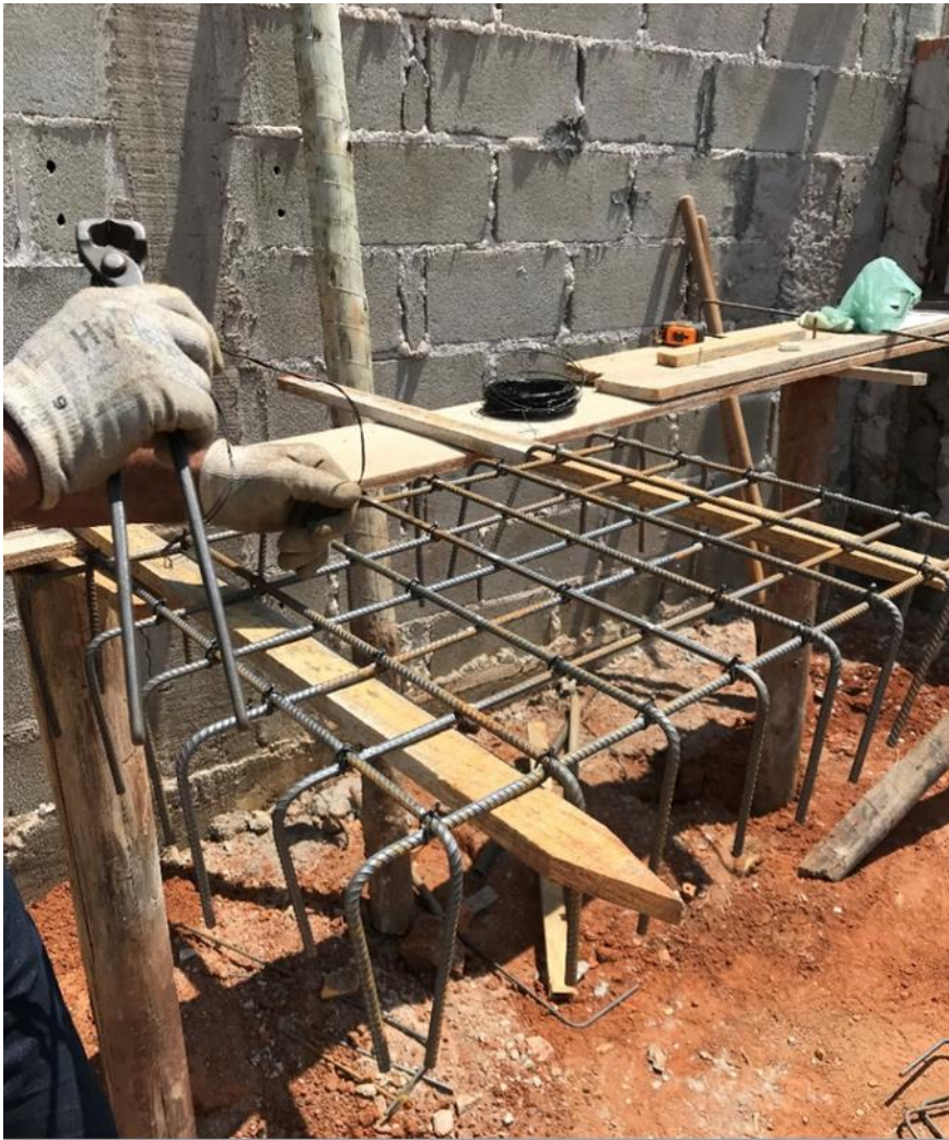
Figura 43 - Montagem da Armadura da Sapata
