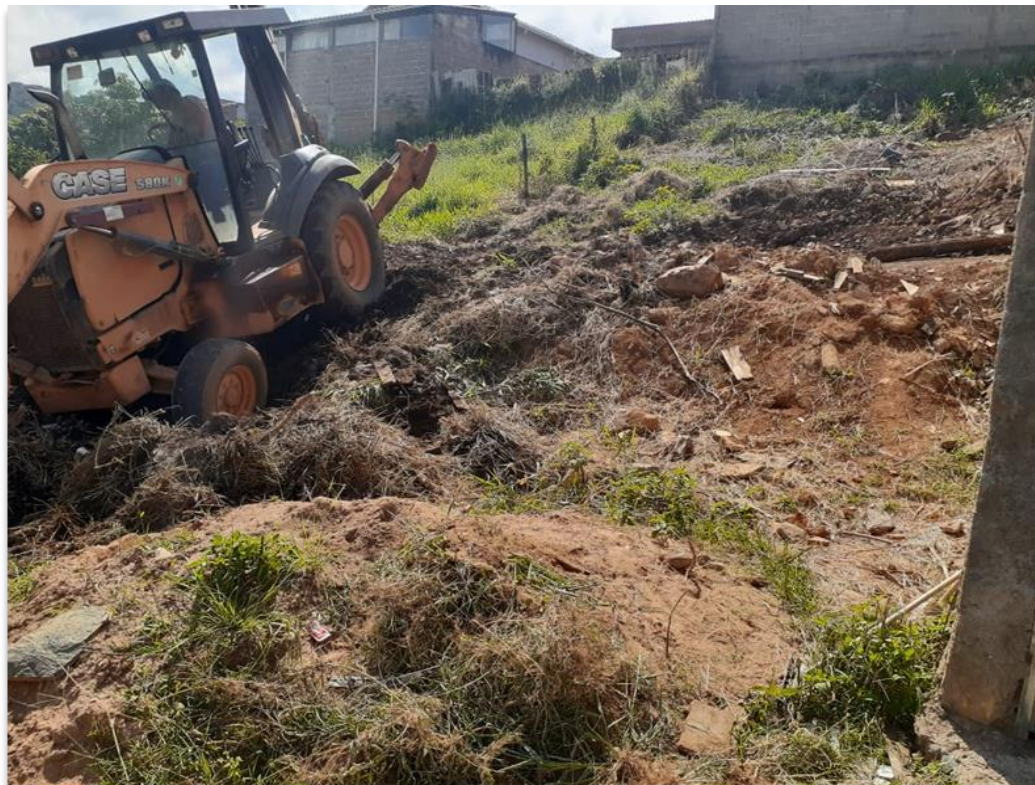
Figura 72 - Nivelamento e compactação do terreno
