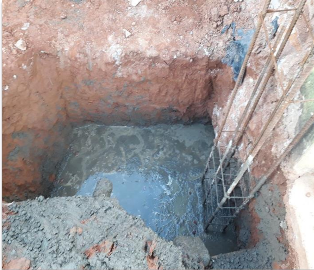
Figura 76 - Concretagem das Sapatas
