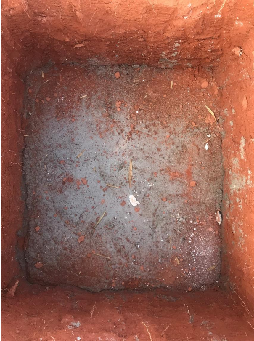
Figura 42 - Lastro de concreto não estrutural
