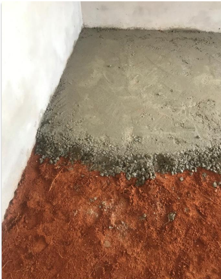
Figura 53 - Execução da Base
