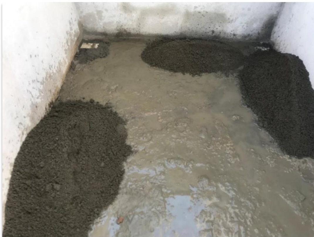
Figura 55 - Preparo para Execução do Contrapiso
