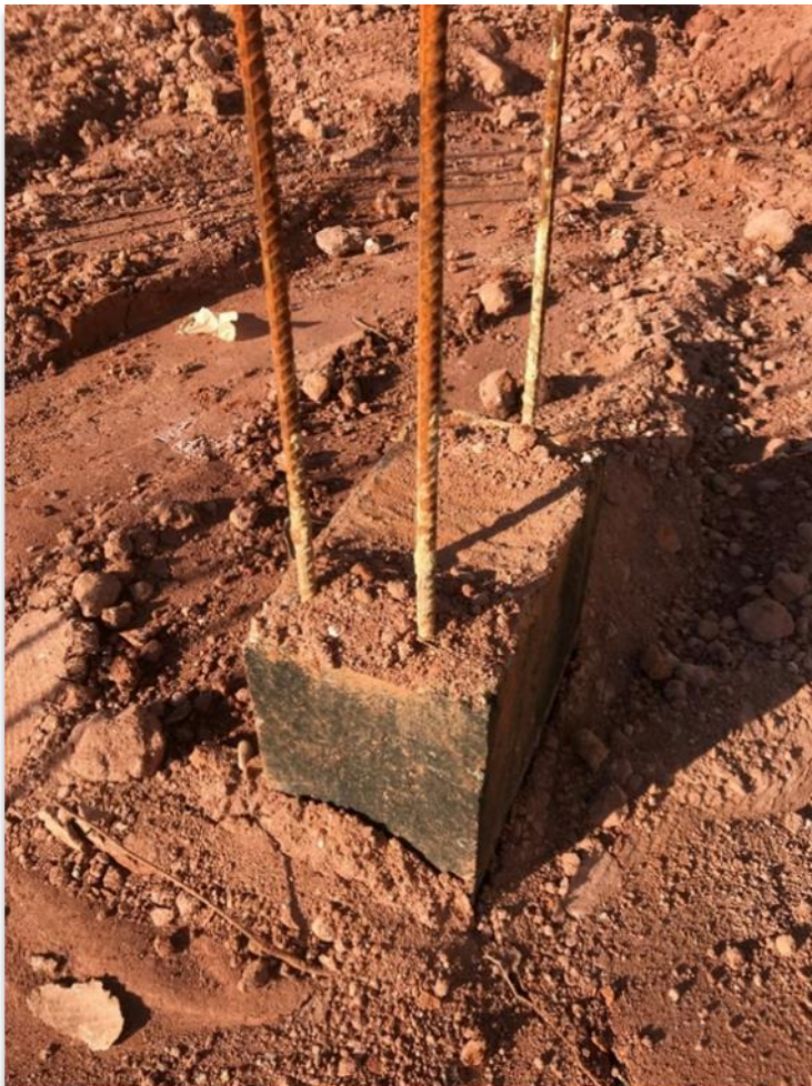
Figura 47 - Sapata Impermeabilizada e Finalizada
