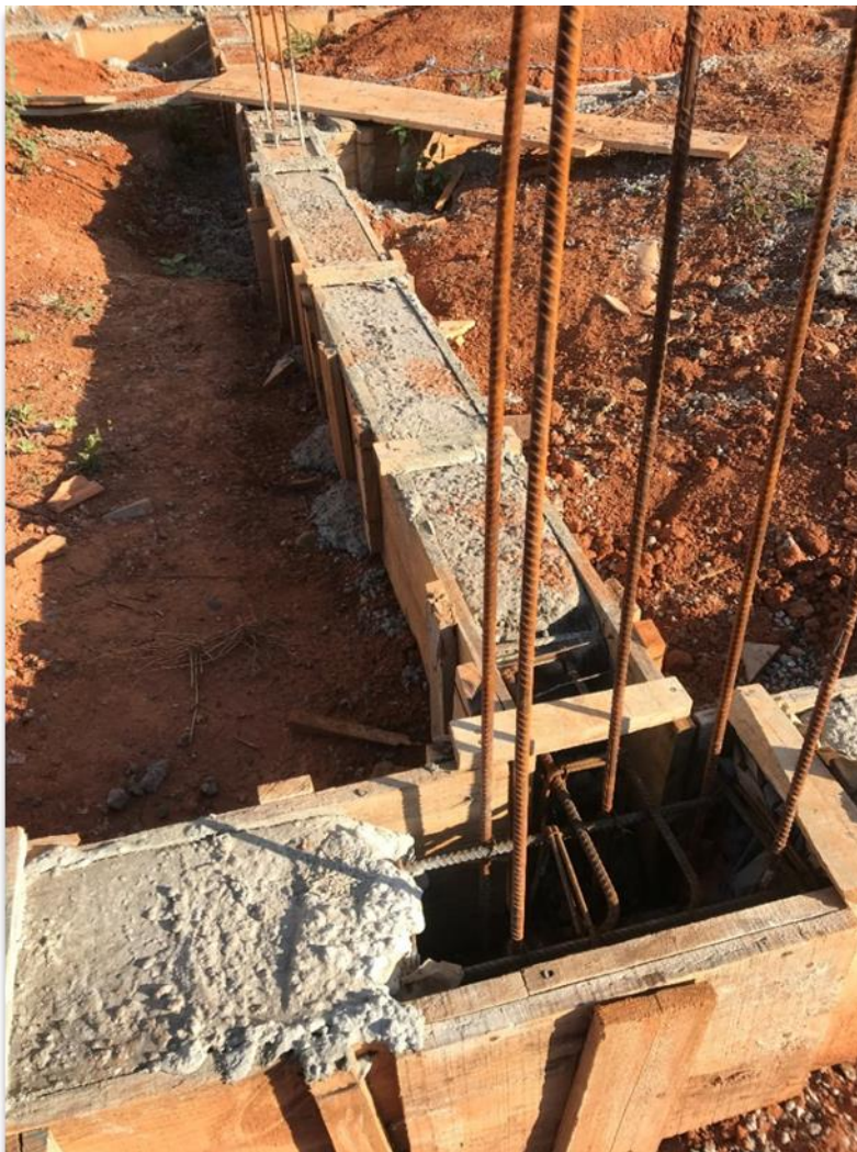
Figura 49 - Viga Baldrame Concretada
