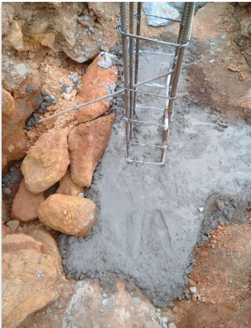
Figura 77 - Sapata concretada
