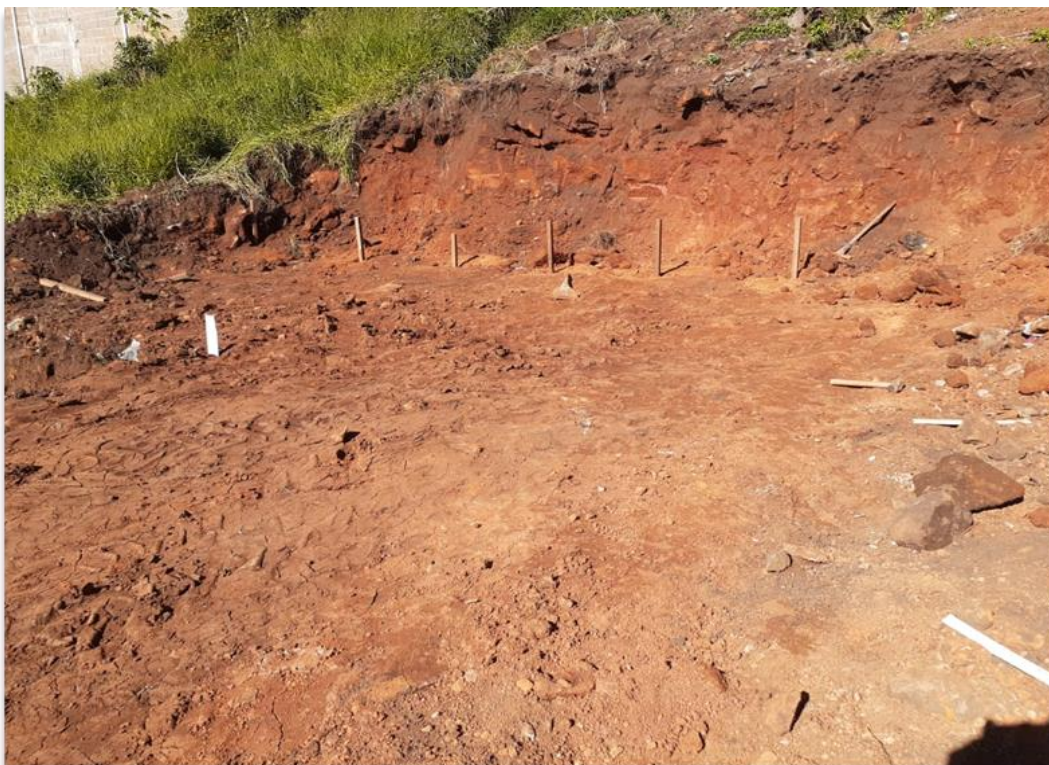
Figura 73 - Terreno Nivelado e Compactado
