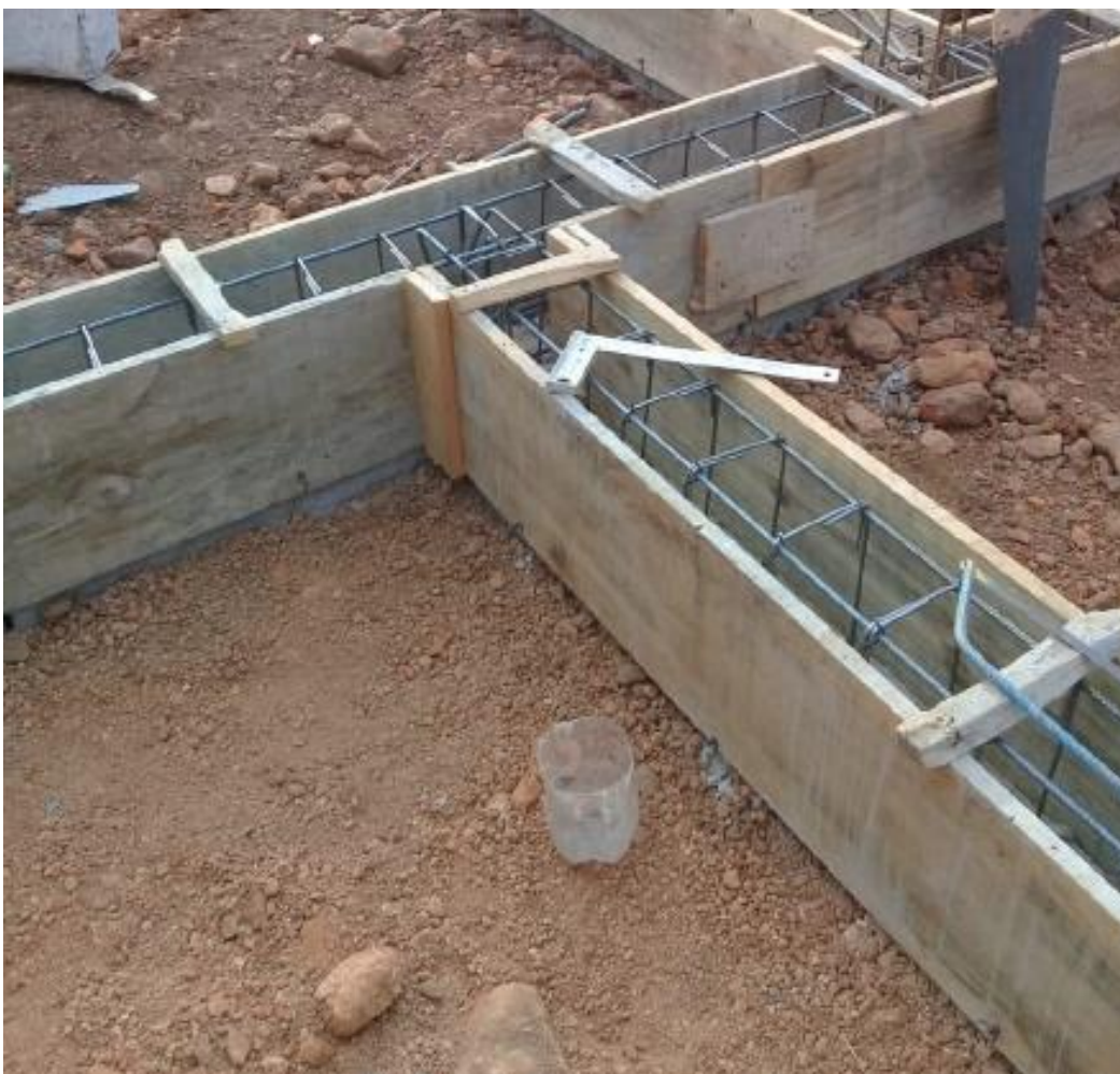
Figura 78 - Execução da Fundação e Vigas Baldrame
