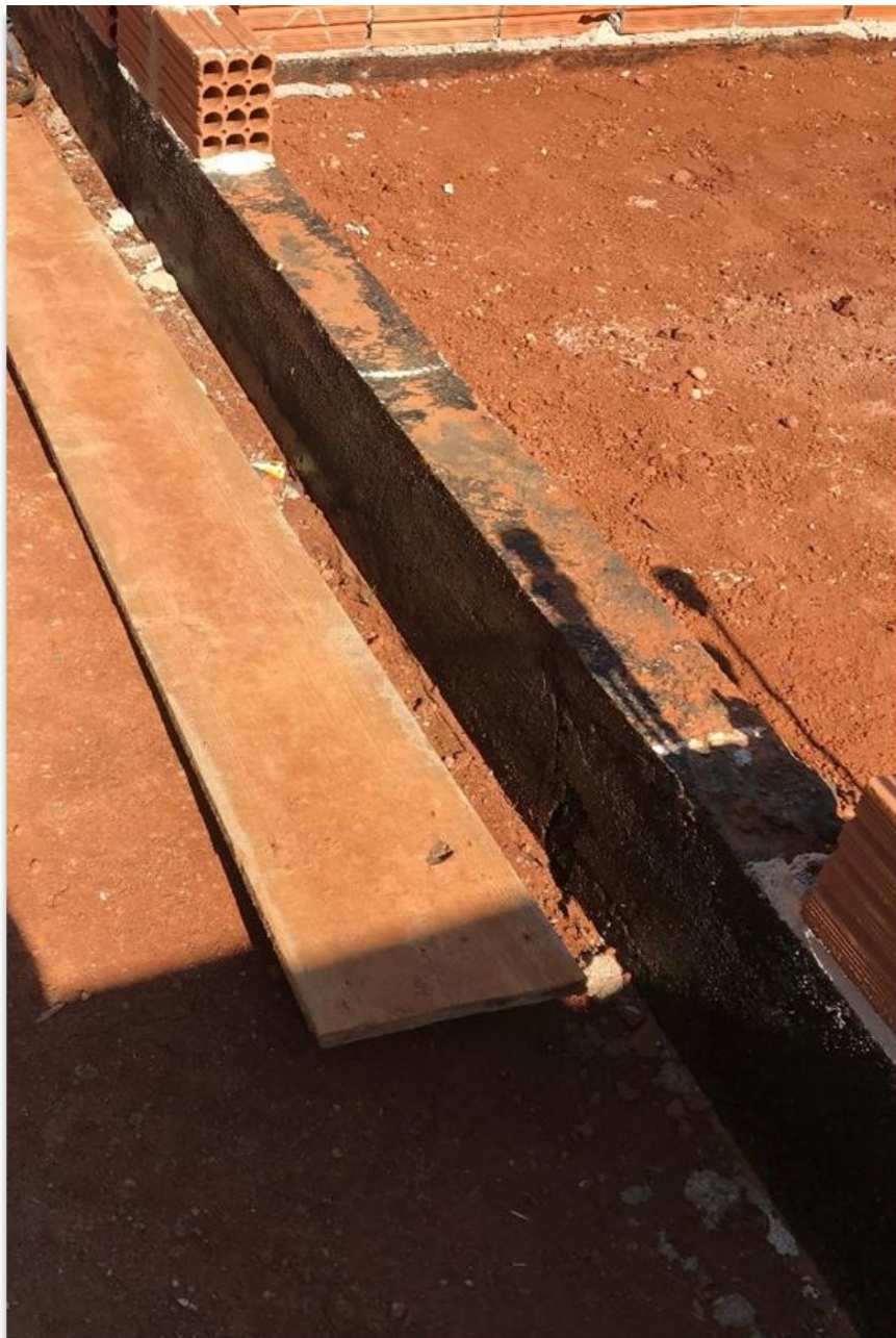
Figura 50 - Viga Baldrame Impermeabilizada
