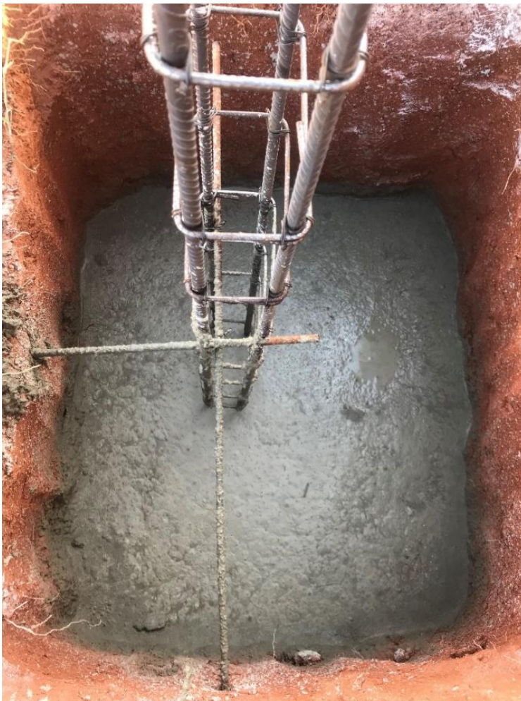
Figura 45 - Concretagem da Sapata
