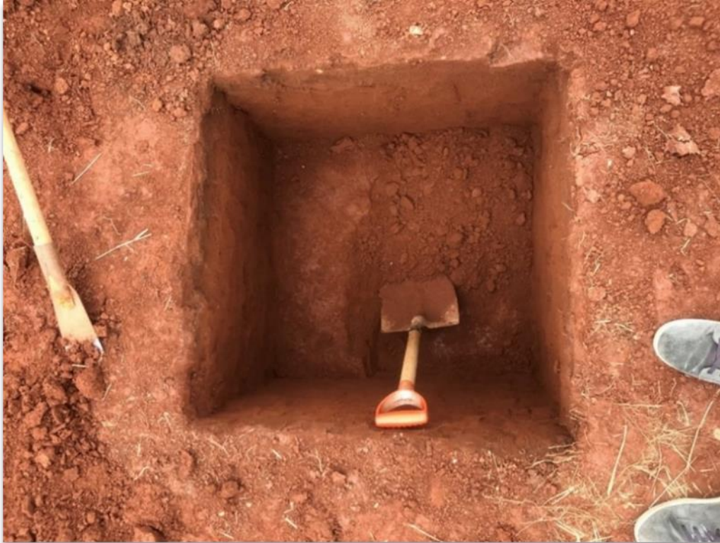
Figura 41 - Escavação das cavas
