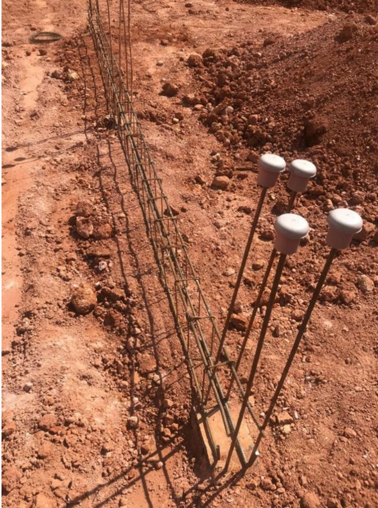
Figura 48 - Armadura da Viga Baldrame
