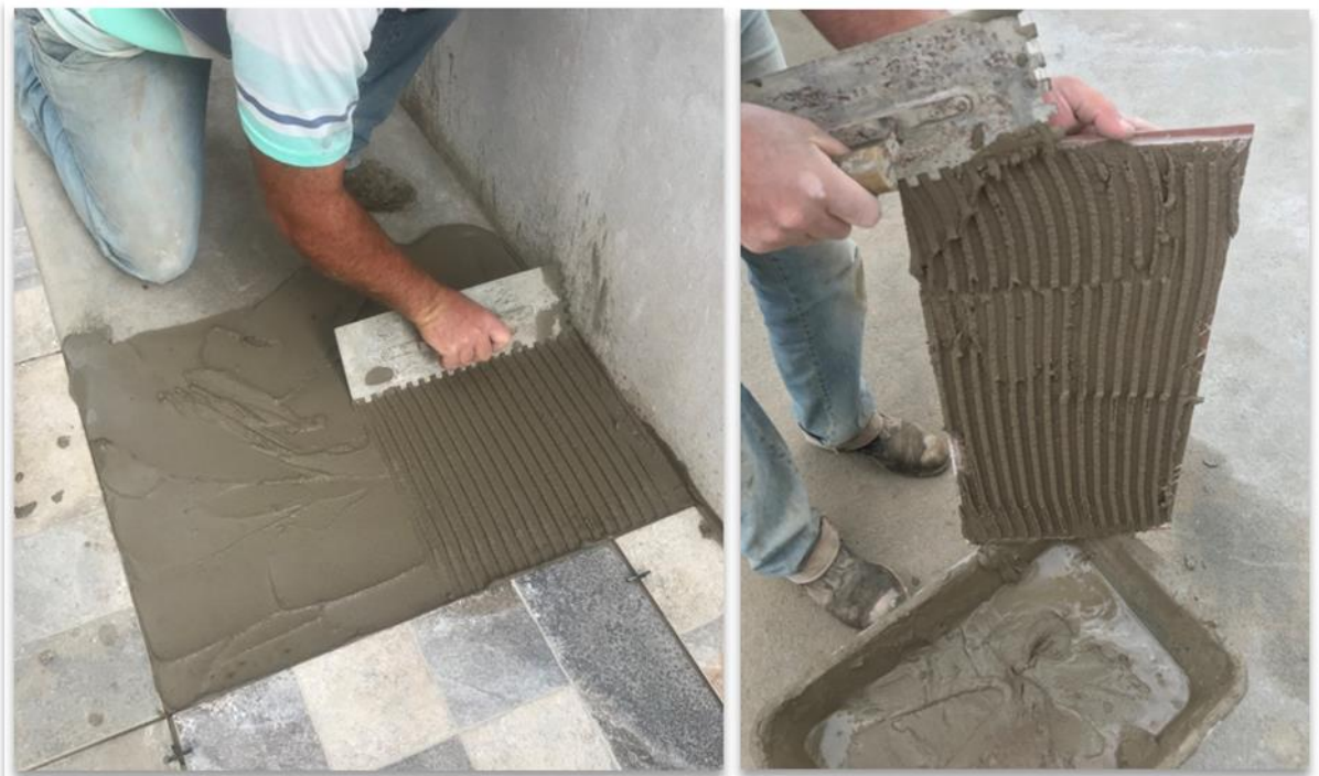
Figura 60 - Aplicação da Cerâmica
