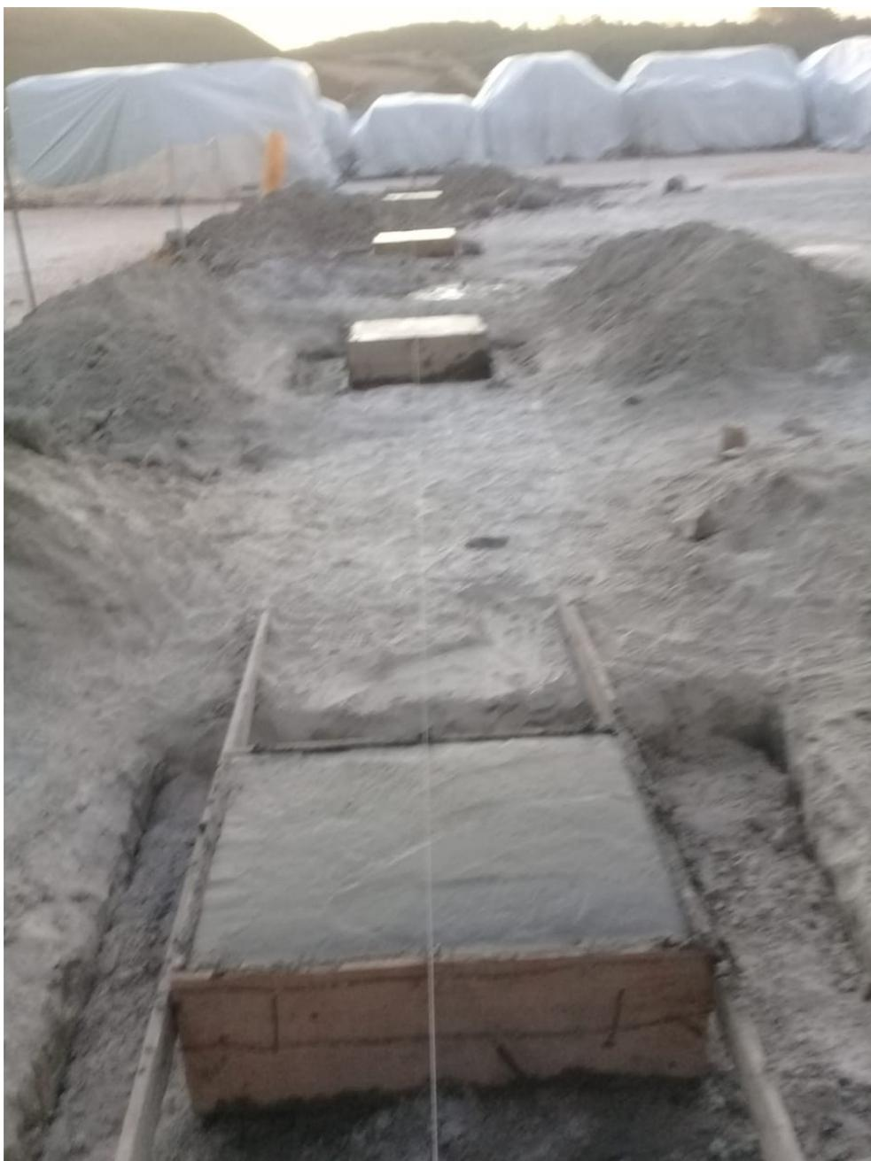
A figura 19 mostra as a fundação com a cura do concreto já concluída e o galpão sendo montado.
