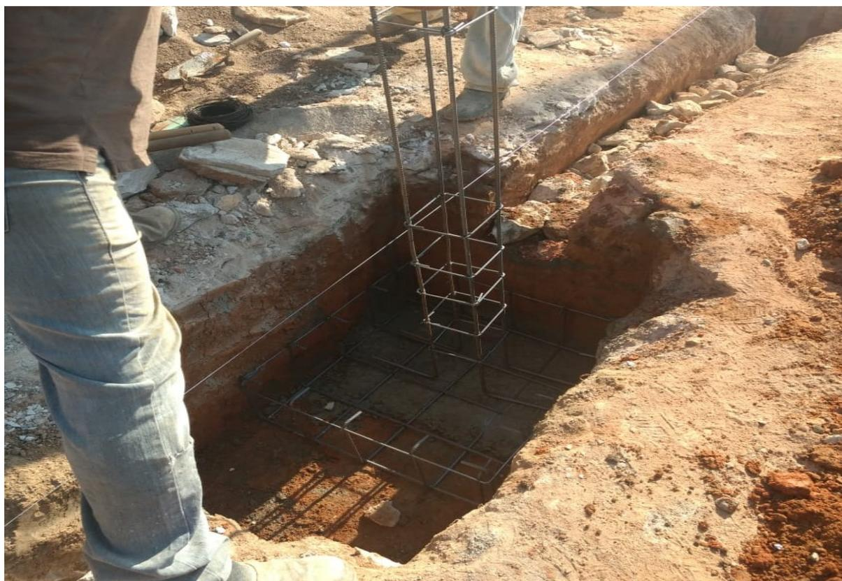
Para a fabricação das armações colocadas nas sapatas, foram utilizadas barras de 8 mm de diâmetro, com espaçamento de 20 cm entre elas e comprimento total das barras de 1,26 m para as sapatas de 80 cm x 80 cm. Para as sapatas de 1,0 m x 1,0 m, barras de 8 mm de diâmetro, espaçamento de 20 cm entre elas e o comprimento total das barras de 1,46 m.
