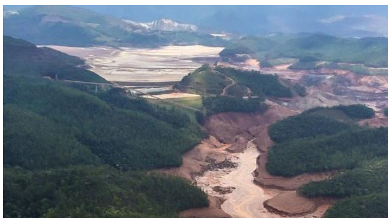
Figura 1- Barragem do Fundão, rompida em Mariana/MG
