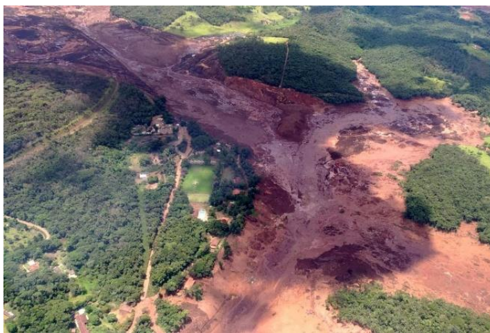
Figura 2- Barragem do córrego do feijão em Brumadinho/MG
